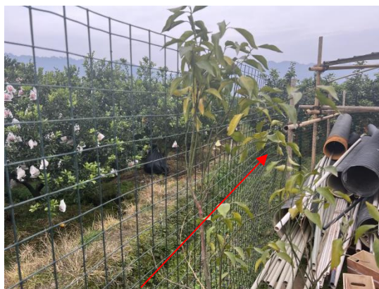
施工生产生活区临时排水沟
