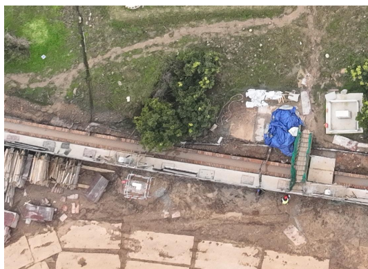
变电站永久排水沟
