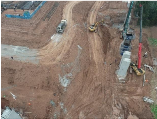
图5-3 图5-4 变电站开挖堆土苫盖不到位
