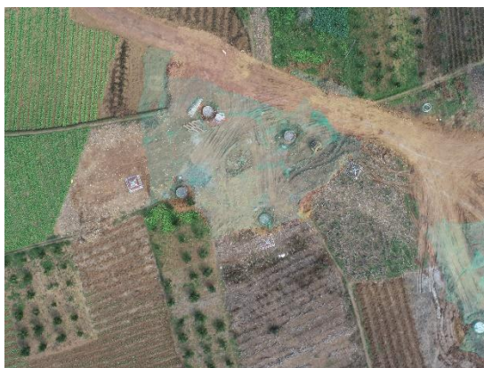
图8-18 塔基区密目网苫盖
