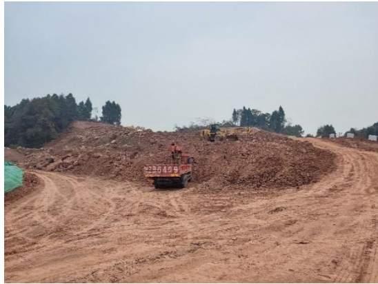
图5-3 图5-4 变电站开挖堆土苫盖不到位
