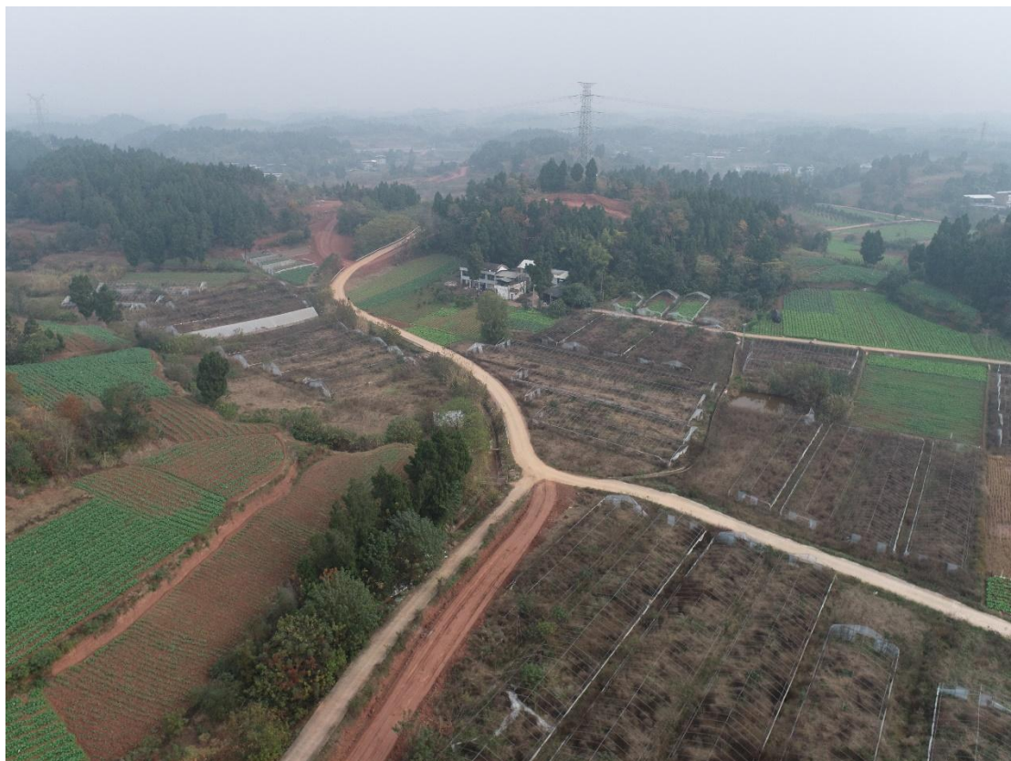
图3-3 施工道路无人机航拍
