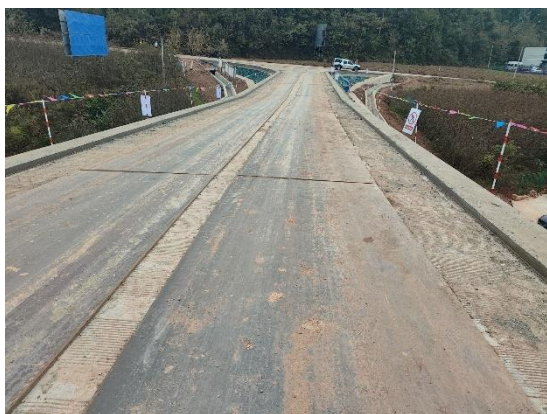
图8-8 变电站道路钢板铺垫
