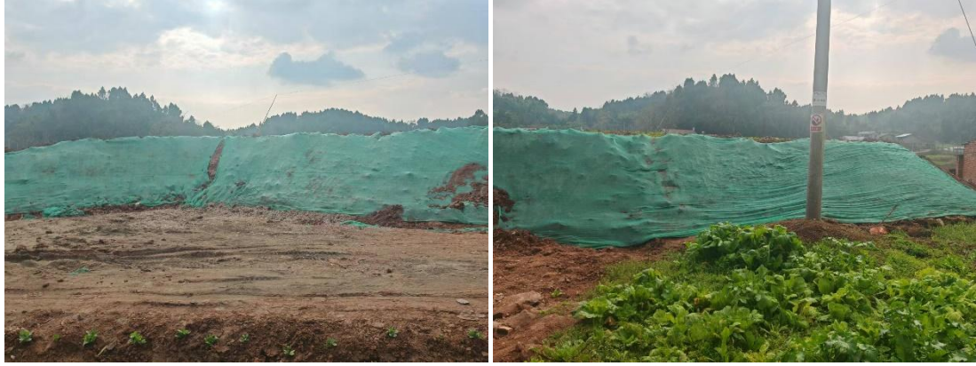
图 1-2 表土堆存场现状照片
