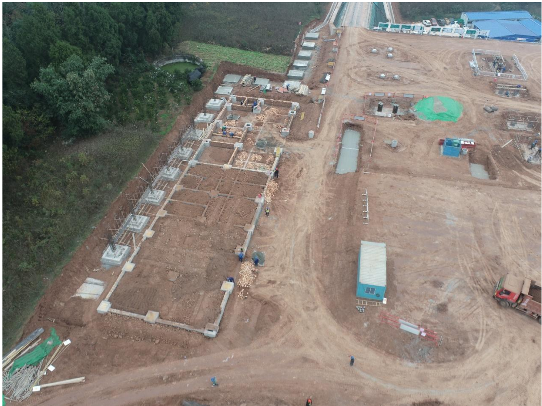
图3-2 变电站无人机航拍
