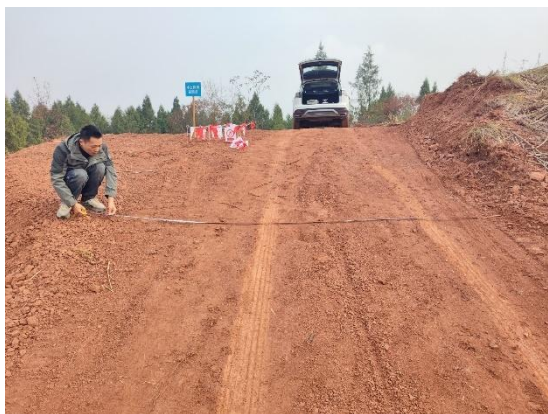
图3-11 对现场施工道路进行量测
