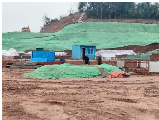
图8-3 施工项目部边坡密目网苫盖 图8-4 变电站站区堆土及边坡密目网苫盖
