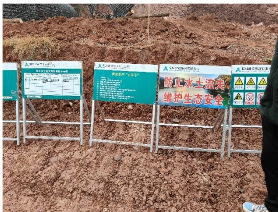
图8-10 施工现场设置水土保持宣传牌
