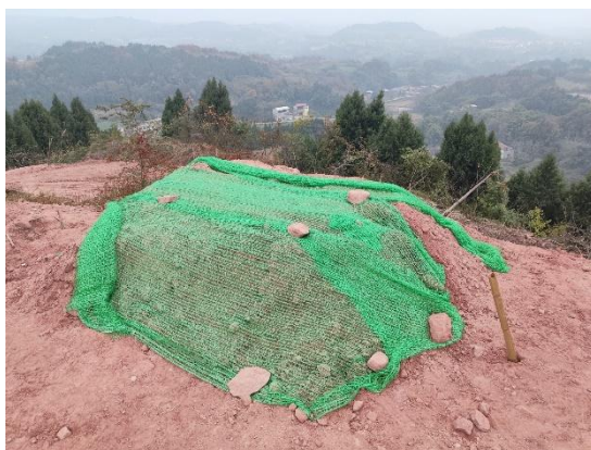
图8-12 塔基区剥离表土进行保护
