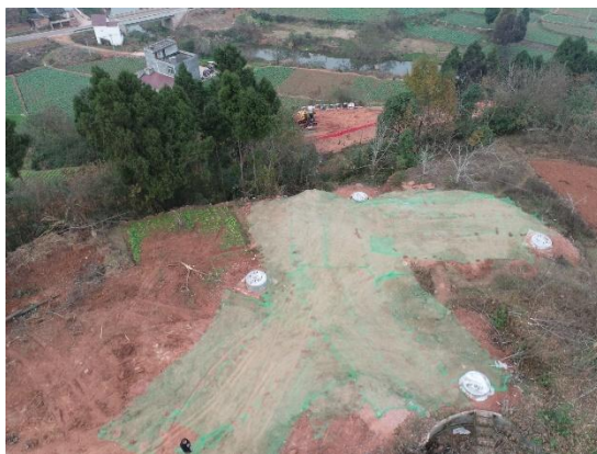
图8-20 塔基区完成土地整治
