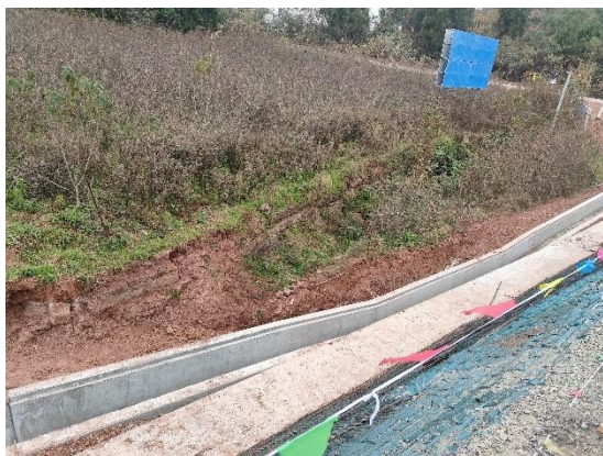
图8-9 变电站修筑混凝土排水沟
