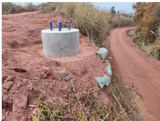
图8-15 塔基区袋装土拦挡
