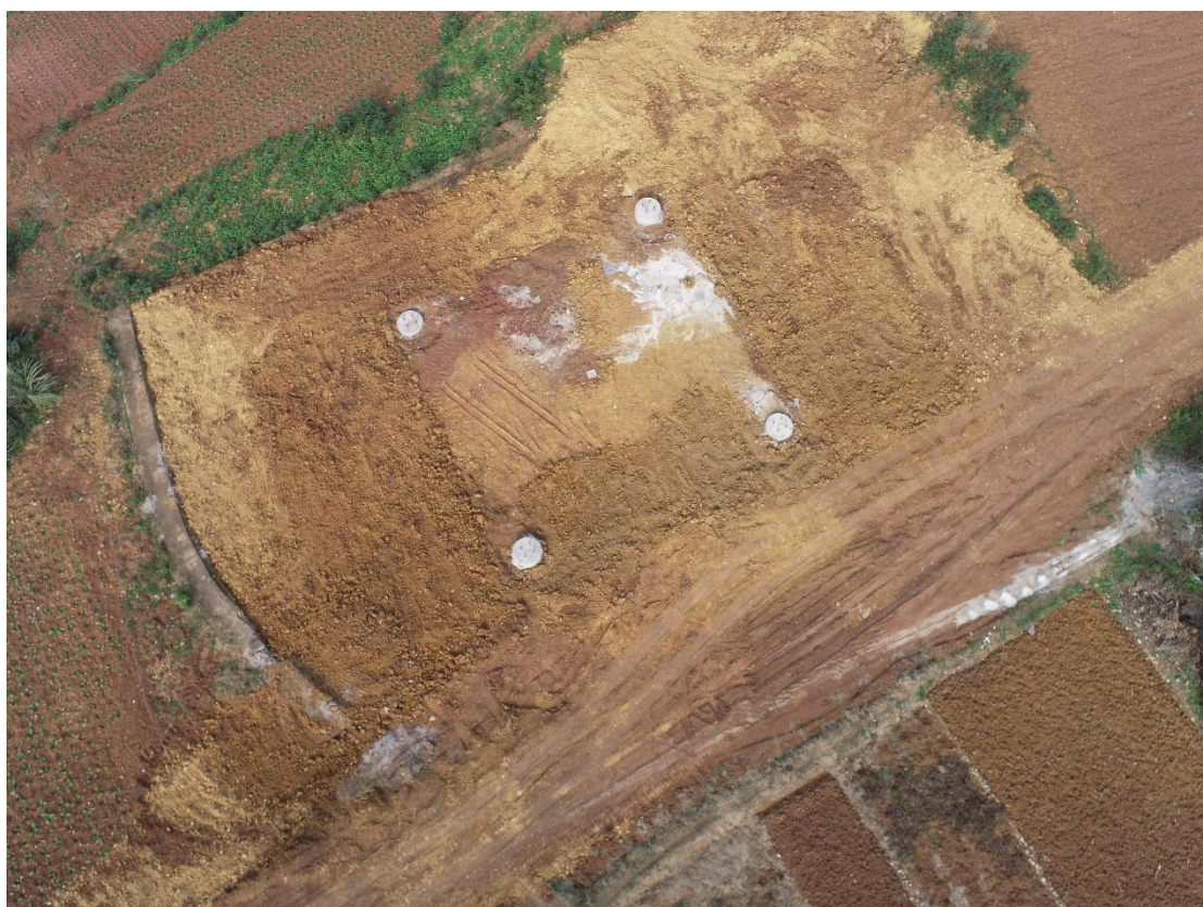
图3-4 塔基区无人机航拍
