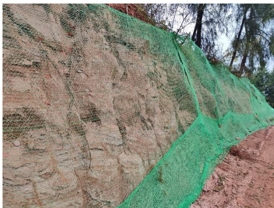
图8-14 塔基区开挖边坡密目网苫盖
