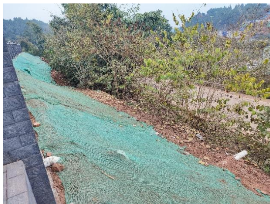
图8-3 施工项目部边坡密目网苫盖 图8-4 变电站站区堆土及边坡密目网苫盖
