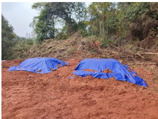
图8-13 塔基区表土分开堆存养护
