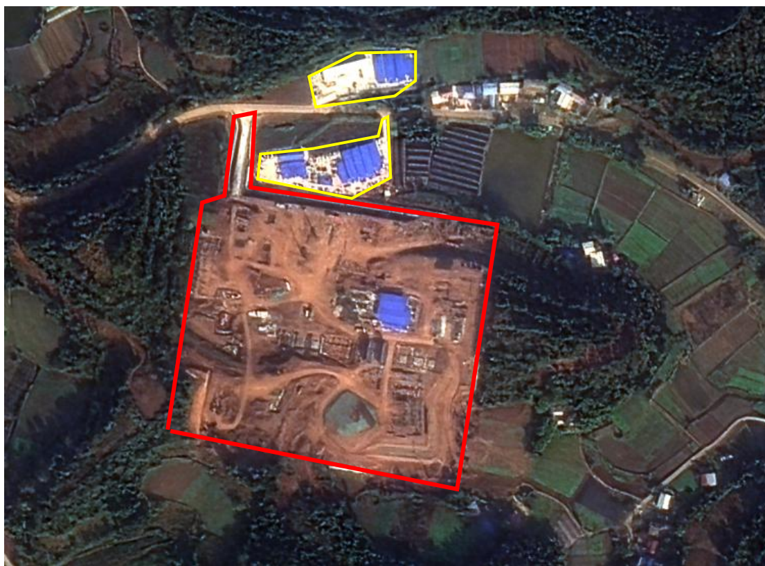
图8-2 变电站现状卫星影像图（12月）
