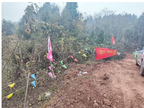
图8-17 施工道路彩条旗限界
