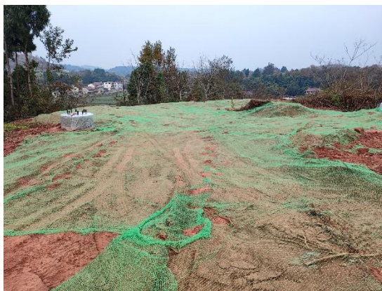
图8-16 塔基区密目网苫盖
