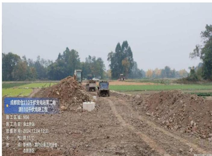
图 4.3-3 N56 塔基施工临时占地区域临时堆存的土石方未及时进行防雨布遮盖、土袋拦挡
