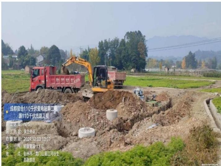
图 4.3-5 N75 塔基施工临时占地区域临时堆存的土石方未及时进行防雨布遮盖、土袋拦挡
