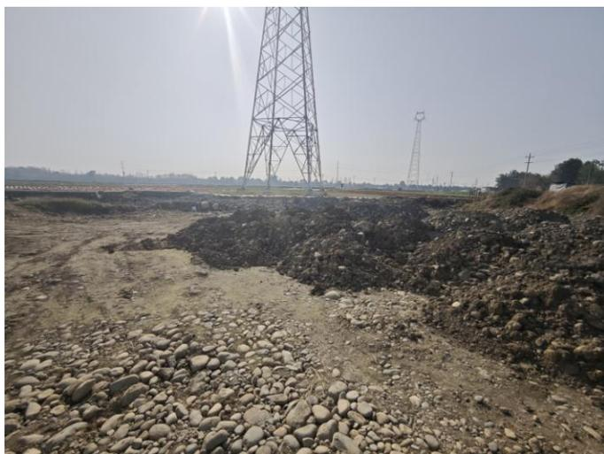
图 4.3-8 N45 施工道路存在临时堆存的土石方未及时清理，且临时堆存期间未及时布设防雨布遮盖、土袋拦挡措施
