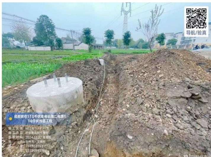
图 4.3-1 N51 塔基施工过程中未对临时堆存的土石方进行有效拦挡、遮盖，对开挖产生的裸露边坡未进行遮盖
