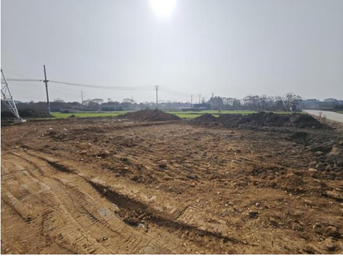
图 4.3-9 N73 塔基施工临时占地区域临时堆存的土石方未及时进行防雨布遮盖、土袋拦挡
