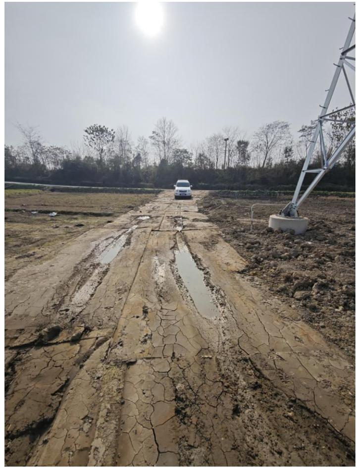
图 4.3-12 已组塔塔基, 施工道路使用结束后未及时进行土地整治交还当地村民进行恢复耕地, 如 N74 施工道路
