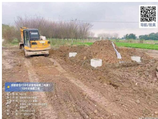
图 4.3-4 N57 塔基施工临时占地区域临时堆存的土石方未及时进行防雨布遮盖、土袋拦挡
