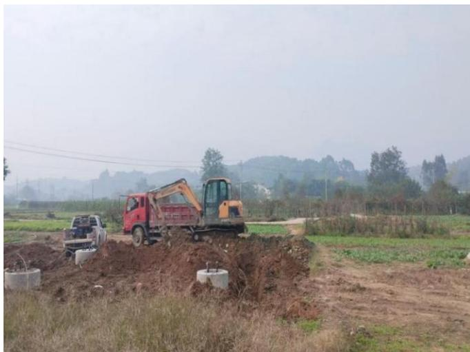
图 4.3-6 N78 塔基施工临时占地区域临时堆存的土石方未及时进行防雨布遮盖、土袋拦挡
