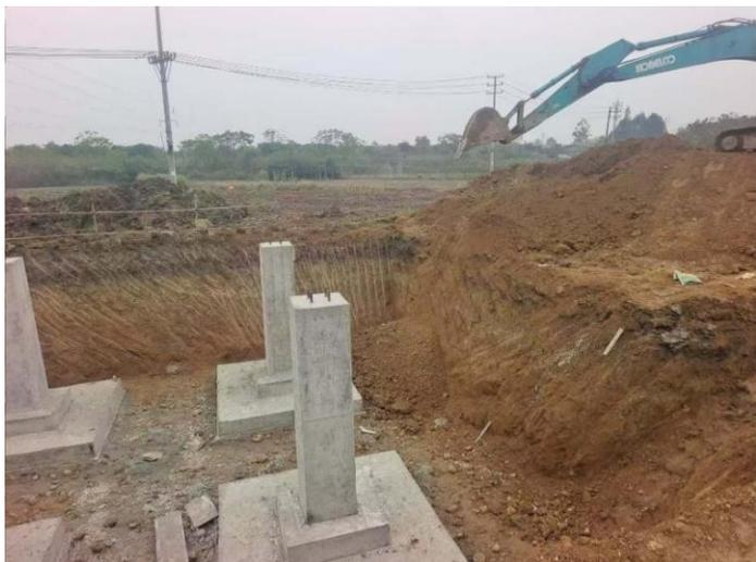
图 4.3-7 N73 塔基施工过程中未对临时堆存的土石方进行有效拦挡、遮盖，对开挖产生的裸露边坡未进行遮盖
