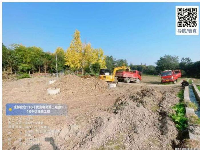
图 4.3-2 N54 塔基施工临时占地区域临时堆存的土石方未及时进行防雨布遮盖、土袋拦挡
