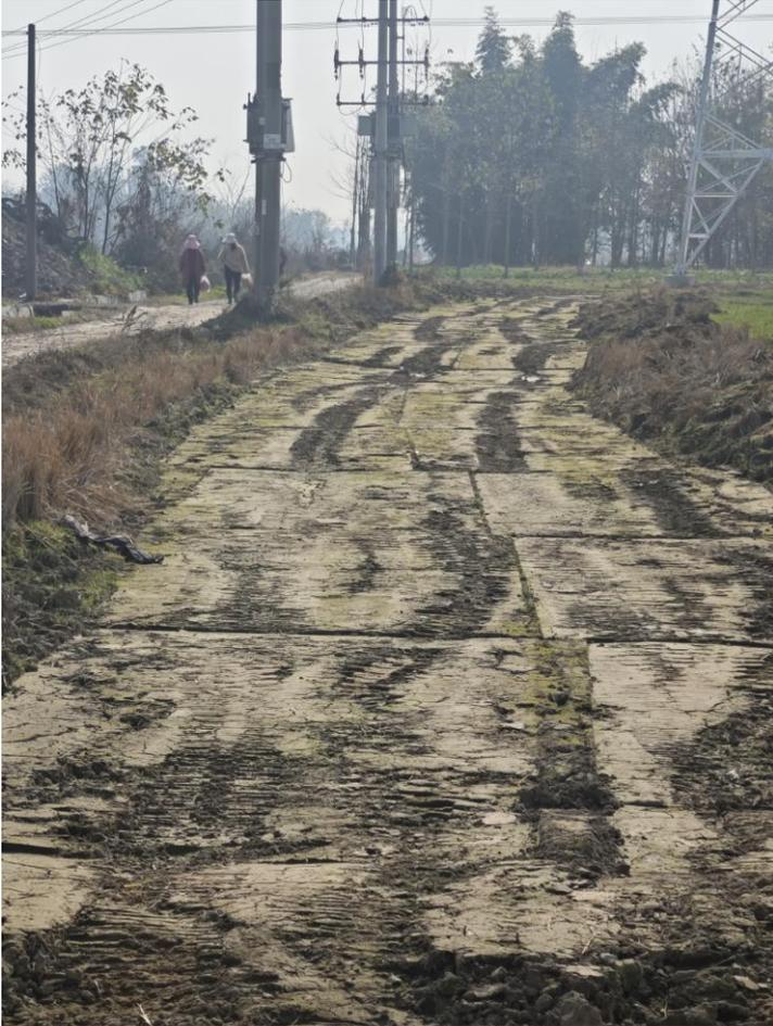
图 4.3-11 已组塔塔基, 施工道路使用结束后未及时进行土地整治交还当地村民进行恢复耕地, 如 N59 施工道路
