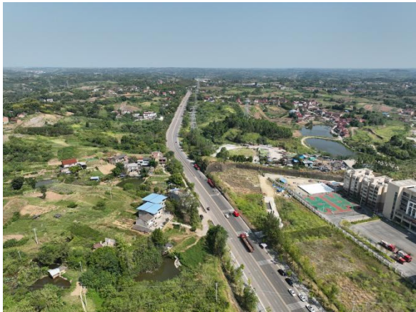
图2-5 项目占地现状
