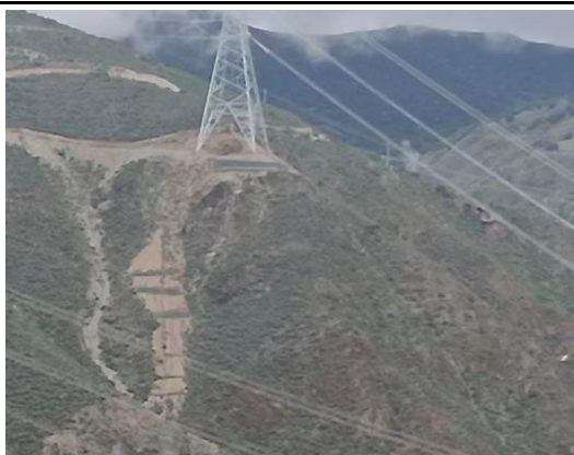
79#塔基 坡面治理前
