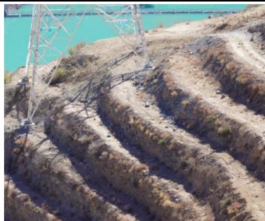
2#塔基 余土清运后
