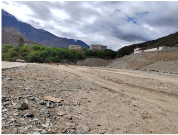
6#索道场地（施工完成后，2022.6）
