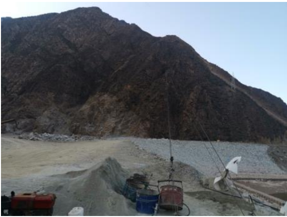
6#索道场地（施工期，2021.8~2022.4）
