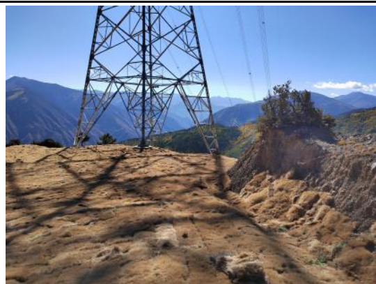
62#塔基 实施植物措施后
