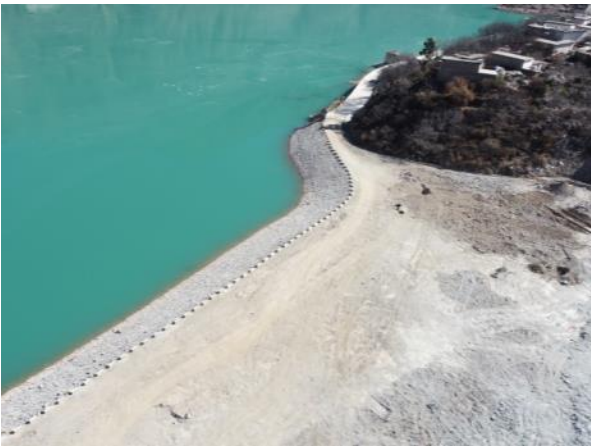
6#索道场地（施工完成后，2022.6）
