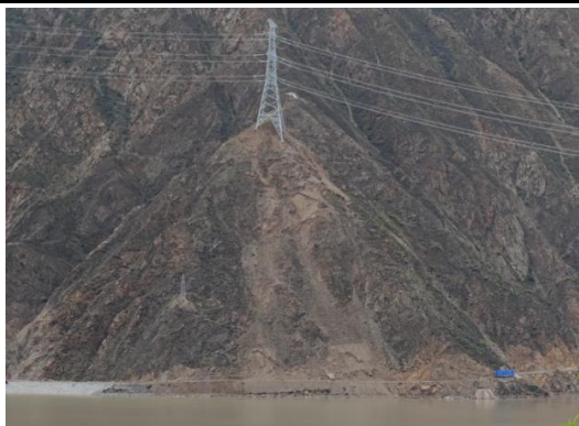
6#塔基 坡面治理前
