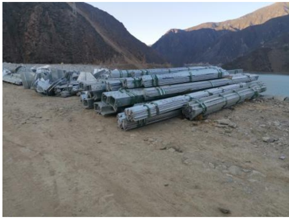
6#索道场地（施工期，2021.8~2022.4）
