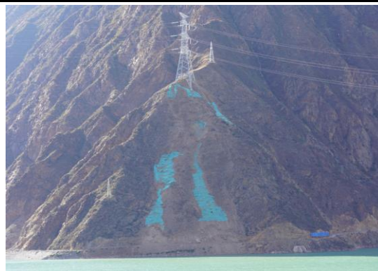
6#塔基 坡面治理后
