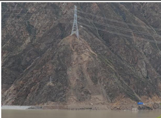
6#塔基 坡面治理前
