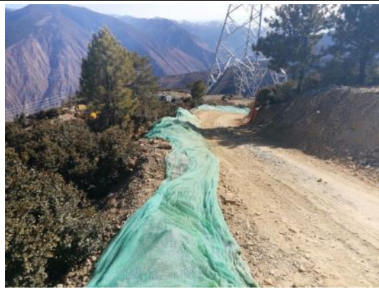
便道 临时遮盖
