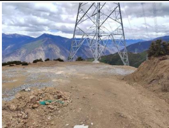
62#塔基 植物措施滞后
