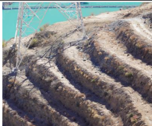
2#塔基 余土清运后
