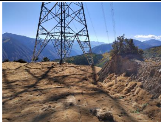
62#塔基 实施植物措施后
