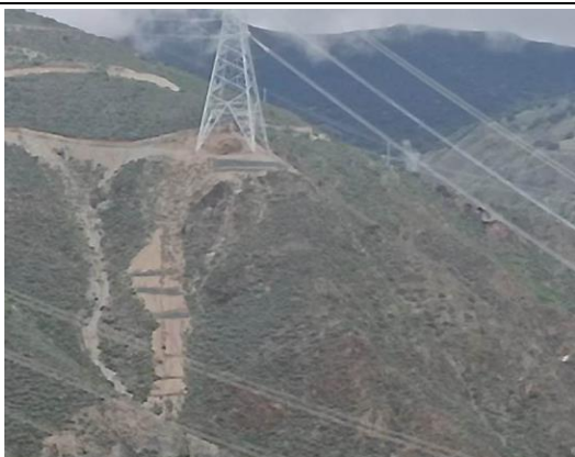
79#塔基 坡面治理前
