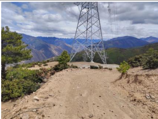
便道 临时遮盖不完善
