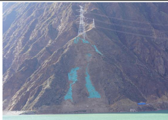
6#塔基 坡面治理后
