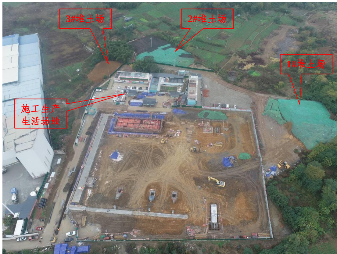
施工生产生活场地和临时堆土场现状照片(2024年12月)
