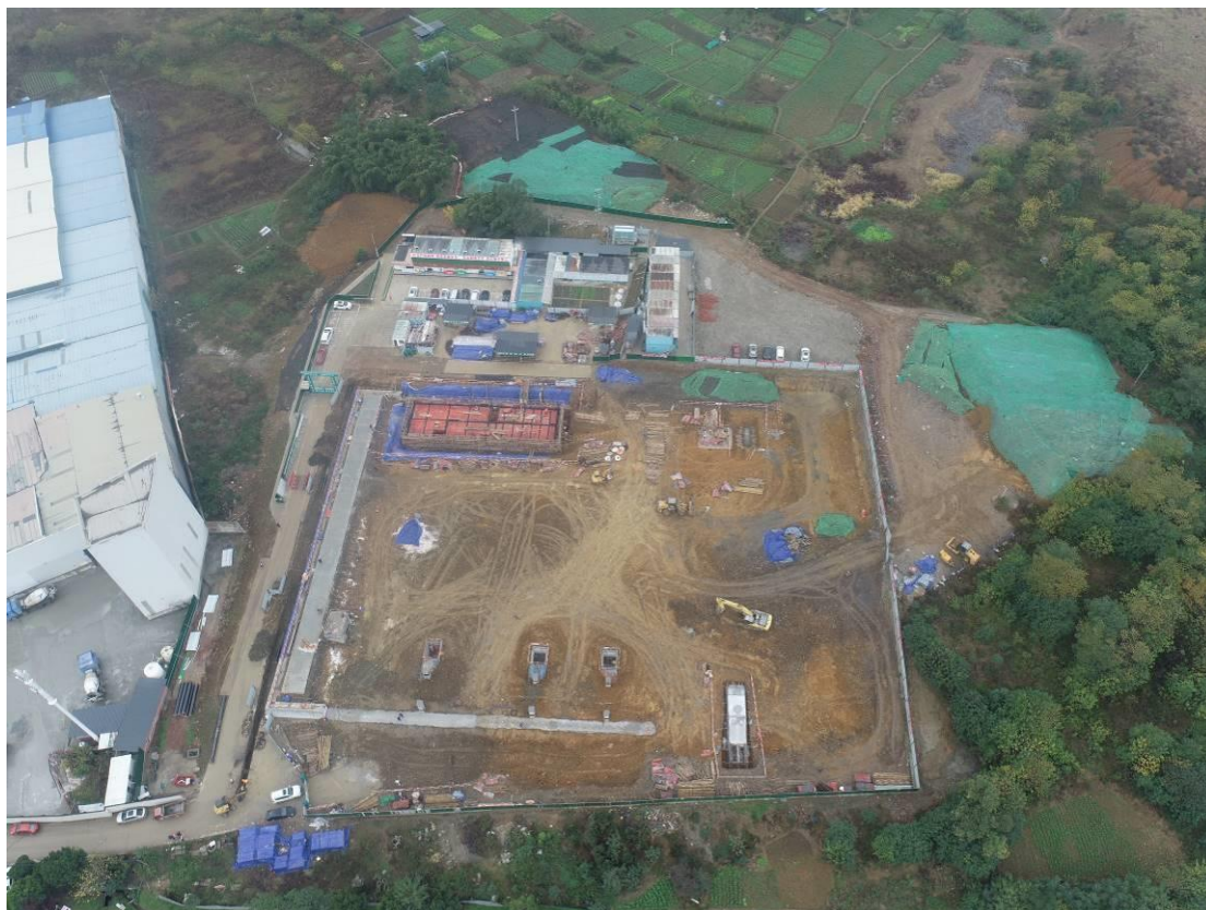
蜀龙 220kV 变电站变电站建设现状
