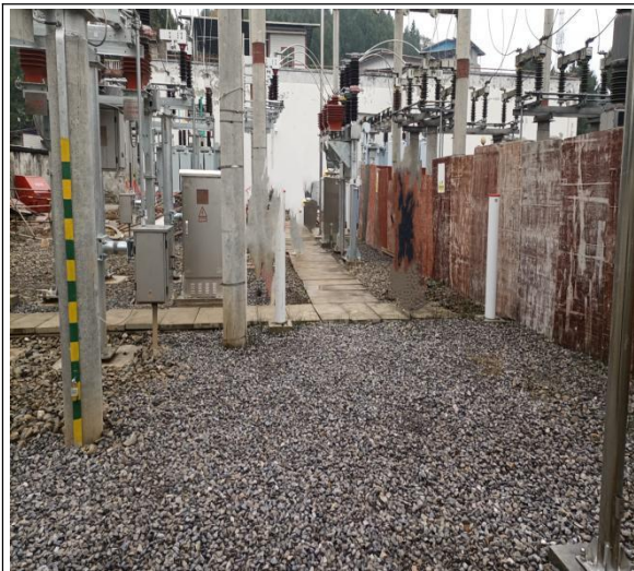
变电站碎石铺盖照片（2024. 11. 3）
