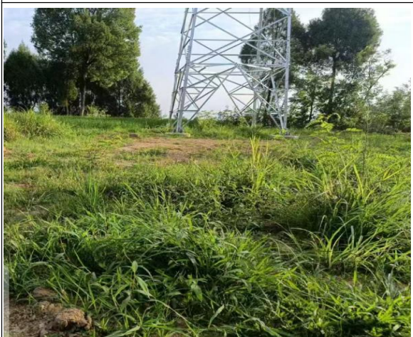
临时占地植草恢复照片（2024. 11. 3）
