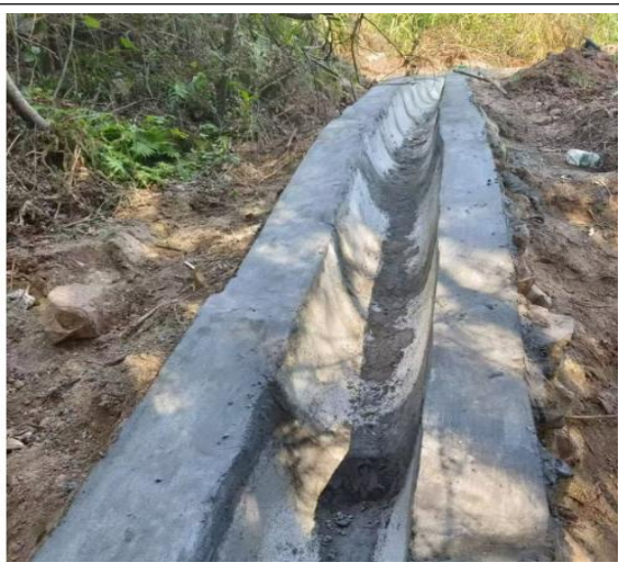
塔基区排水沟照片（2024. 11. 3）
