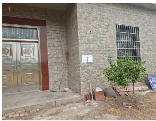
图 3-28 泸州市泸县方洞镇新联村居民处
