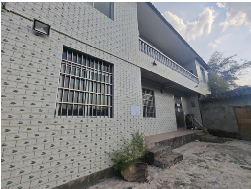
图 3-25 泸州市泸县石桥镇大堰村居民处
