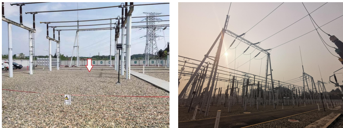
图 2.4-1 站内地坪现状（碎石压盖）
