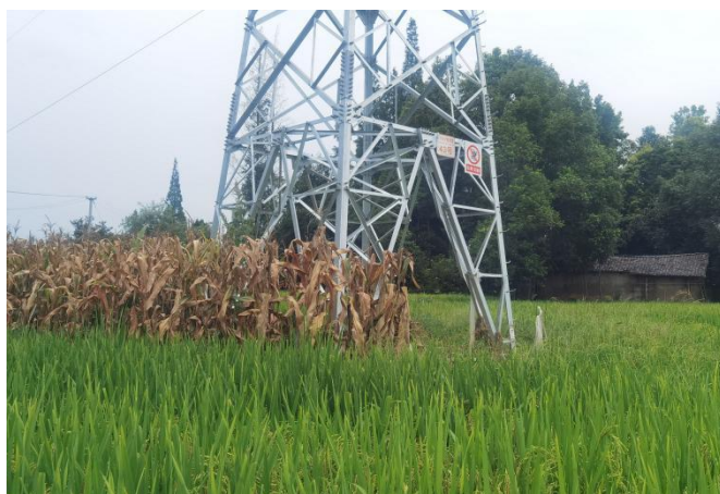
43#铁塔（新建 N3#）
