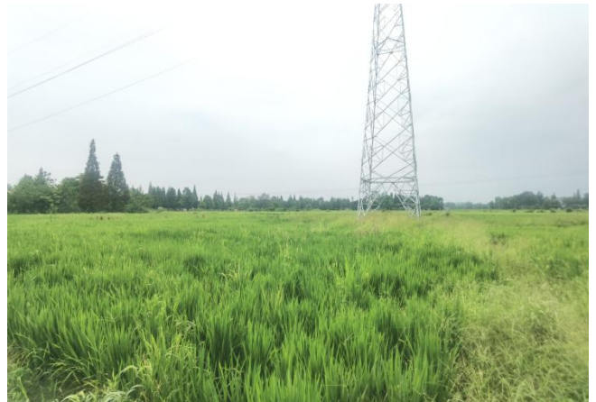
施工临时占地区域耕地恢复情况
