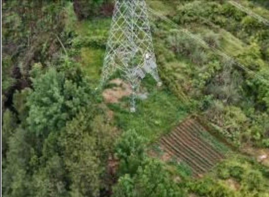
图 35 盘郭线 10#高低腿铁塔
