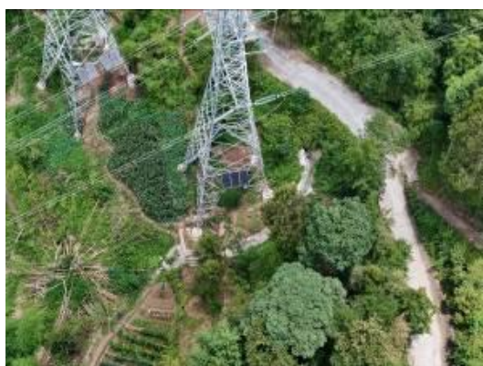
图 34 盘郭线 35#高低腿铁塔
