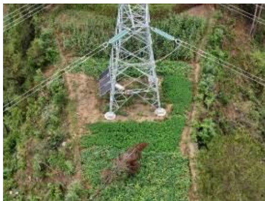
图 38 盘郭线 14#塔基临时占地复垦
