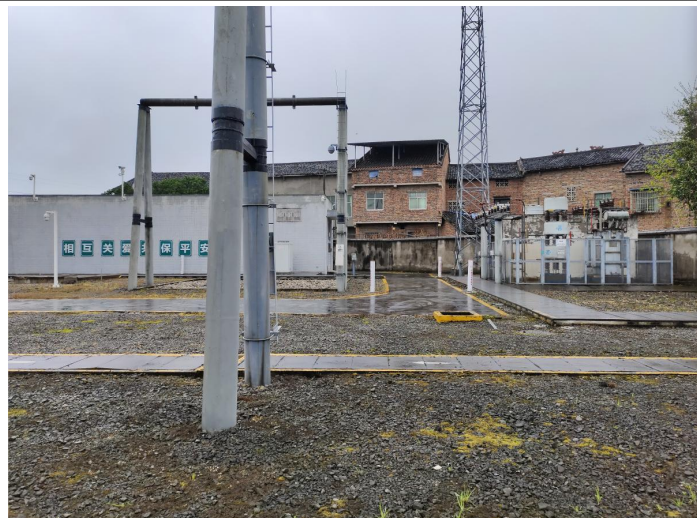
卫桥变电站扩建预留地照片
