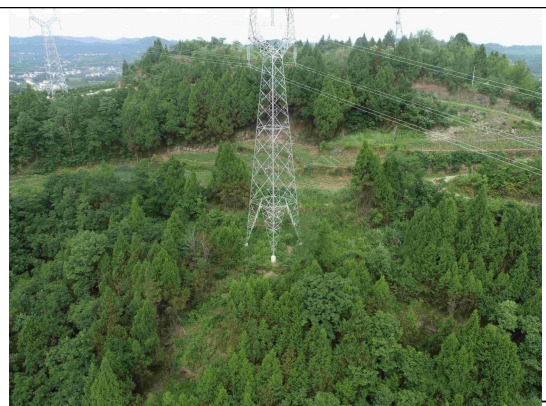
220kV 仪鞍线 37#-塔基及塔基施工临时占地绿化
