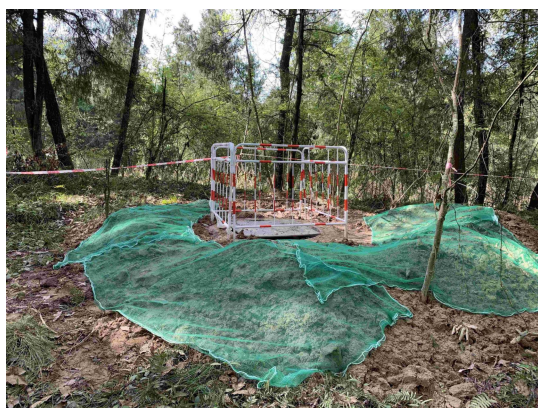
塔基及塔基施工临时占地区-密目网遮盖
