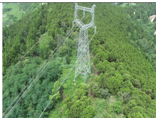
220kV 仪鞍线 8#-塔基及塔基施工临时占地绿化
