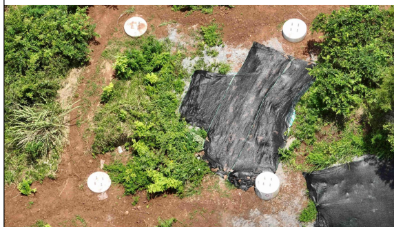
塔基及塔基施工临时占地区-密目网遮盖
