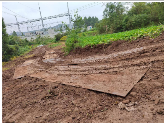
施工汽运道路-铺设钢板
