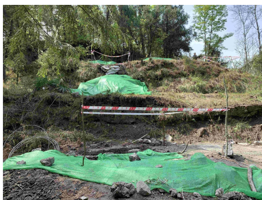
塔基及施工临时占地区-密目网、防雨布遮盖
