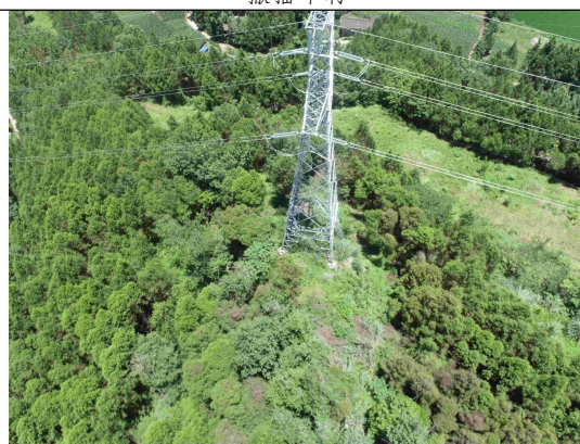
220kV 德鞍线 4#-塔基及塔基施工临时占地绿化
