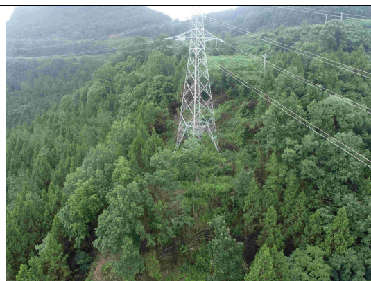
220kV 仪鞍线 95#-塔基及塔基施工临时占地绿化
