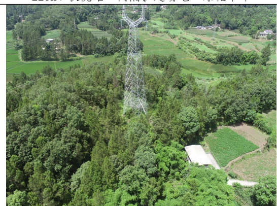
220kV 德鞍线 23#-塔基及塔基施工临时占地绿化
