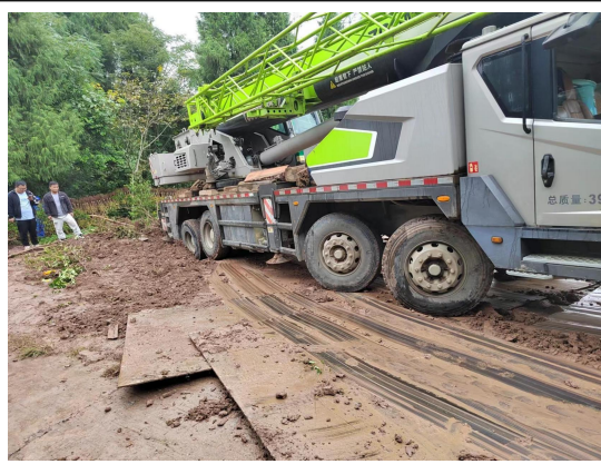
施工汽运道路-铺设钢板
