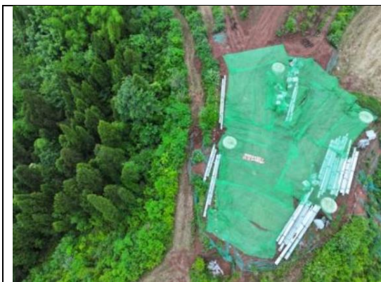
N5887 施工道路区临时措施 (2024.6)
