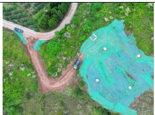
N6148 塔基区临时措施 (2024.6)
