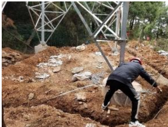
图2.1-1同类项目接地极施工
