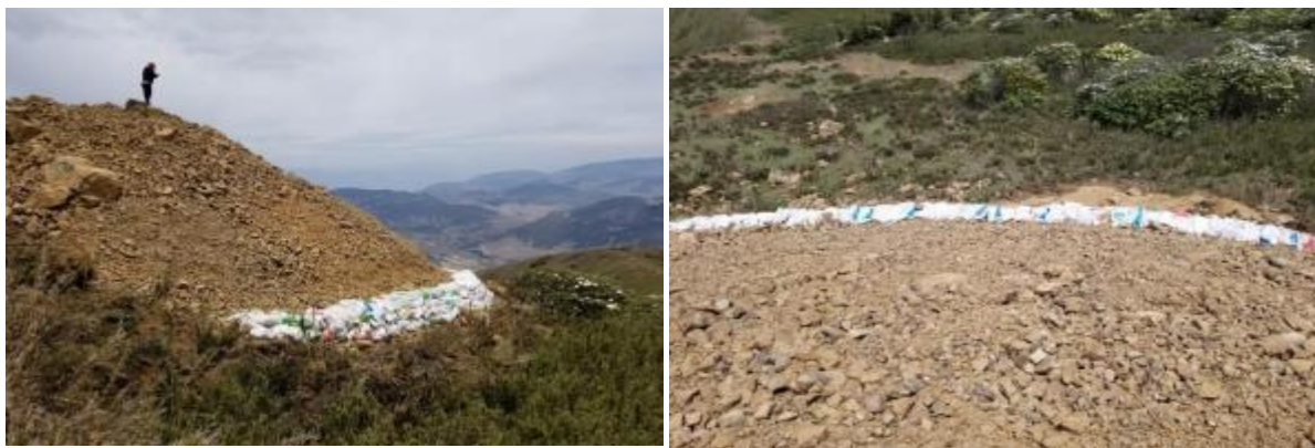
图5.3-1同类工程临时堆土土袋拦挡措施
