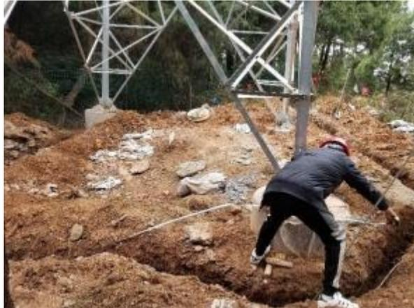
图2.1-1同类项目接地极施工
