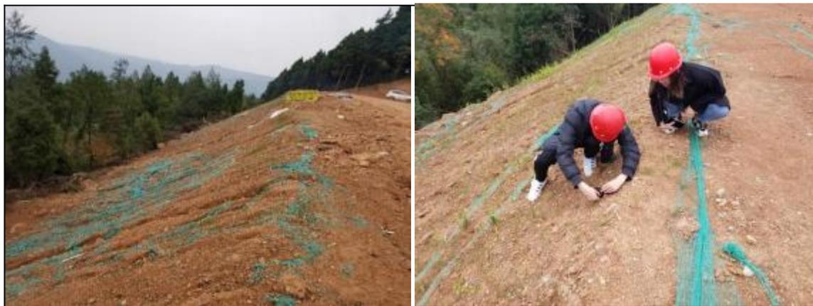
图6.1-1同类项目边坡侵蚀沟
