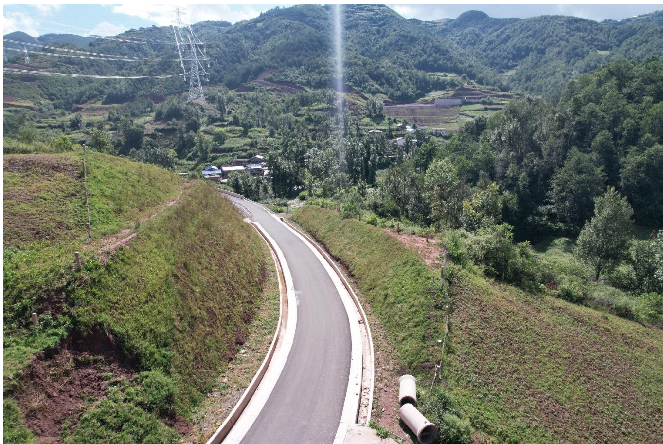
进站道路现状航拍图
