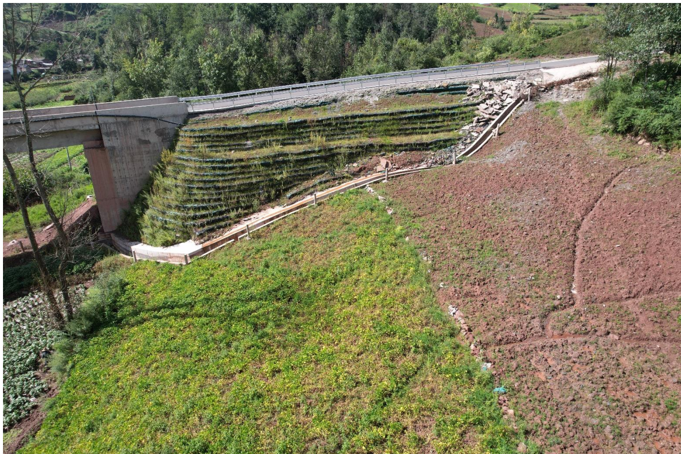
施工营地迹地恢复（绿化及复耕）
