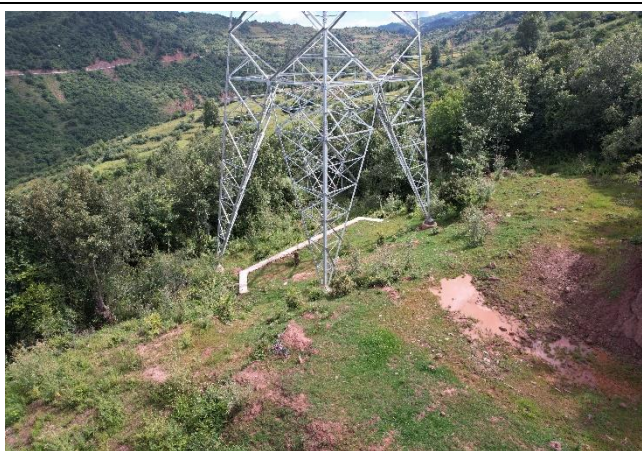
N1043#塔基已绿化、并实施了浆砌石挡墙
