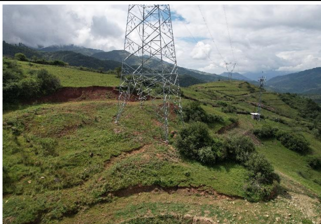
N1046#塔基及其施工便道已绿化
