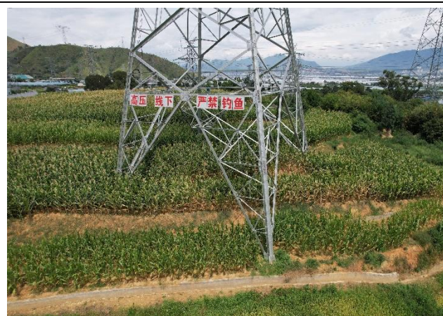
N3002#塔基已绿化、已实施浆砌石排水沟
