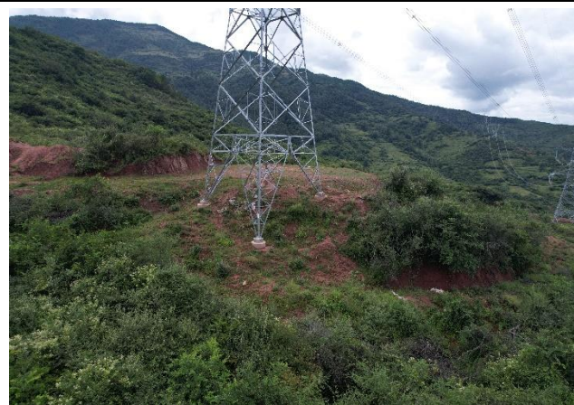
N1050#塔基及牵张场已绿化
