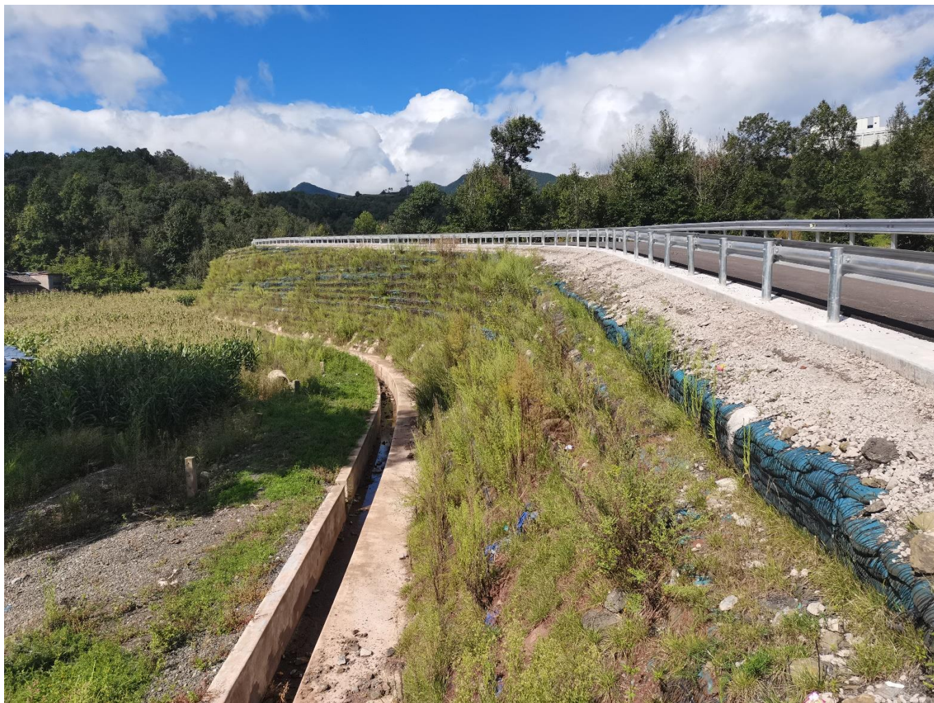
开关站进站道路边坡实施的植物措施、植生袋挡护及截排水措施
