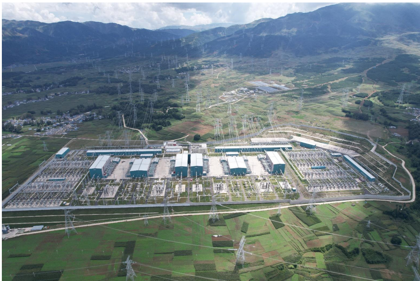
布拖换流站现状航拍图
