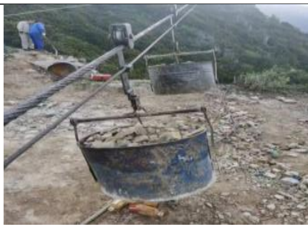
1L103正在进行余土外运，已进行临时拦挡，现场垃圾已清理。
