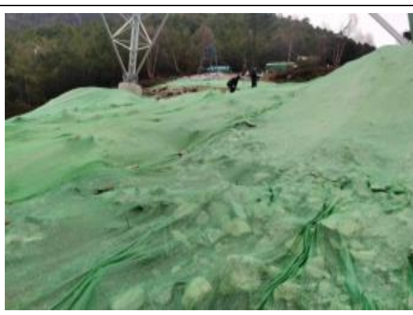
1L100已补充苫盖、铺垫措施。
