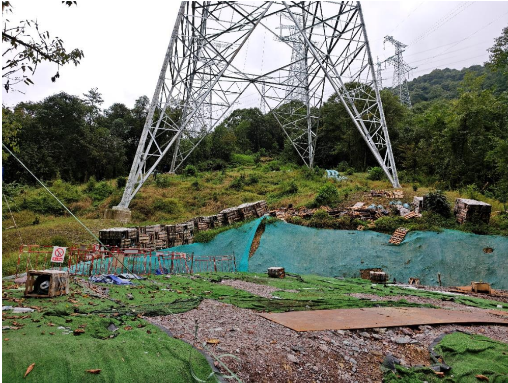
塔基恢复绿化
