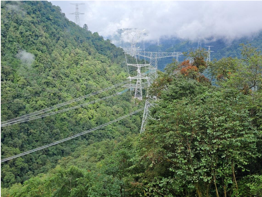
塔基恢复绿化
