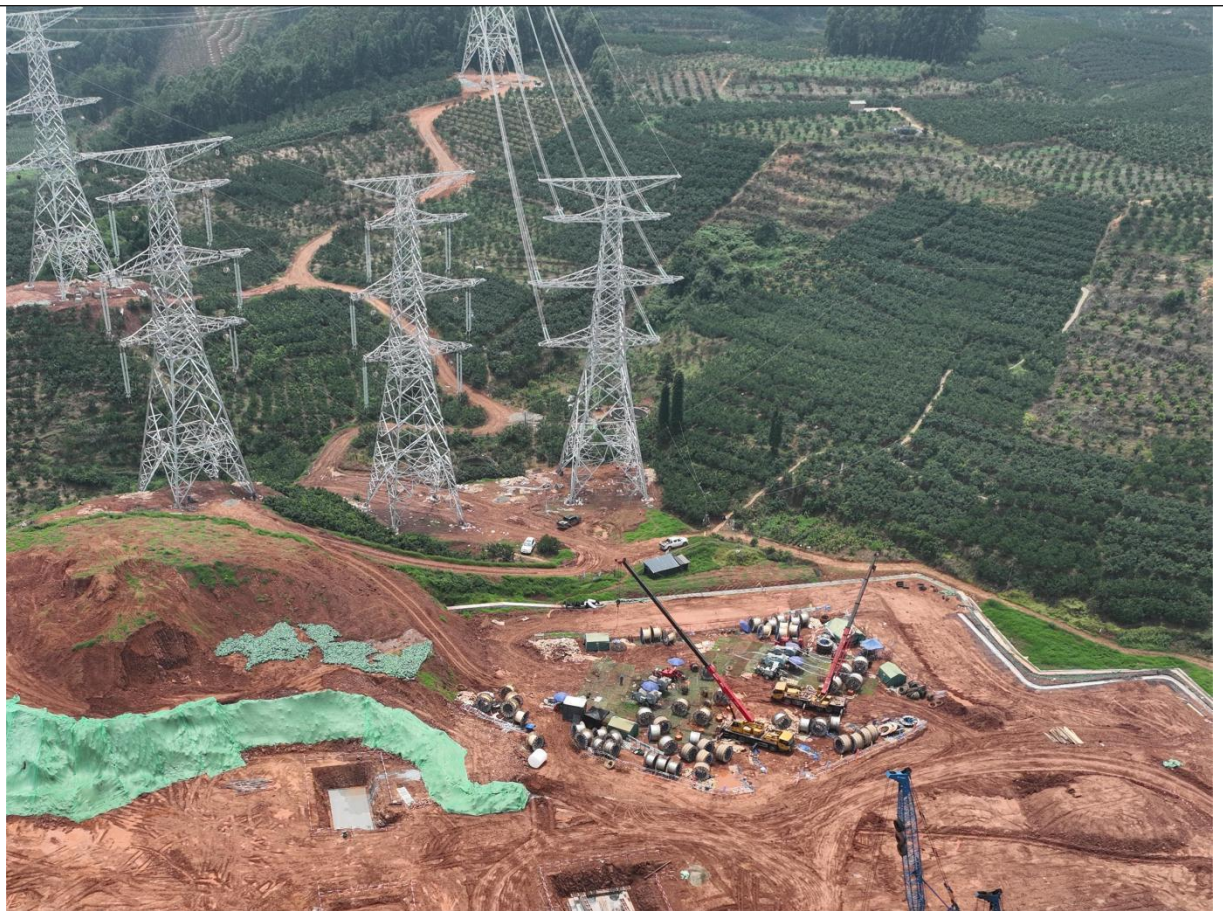
线路工程牵张场（变电站内）
