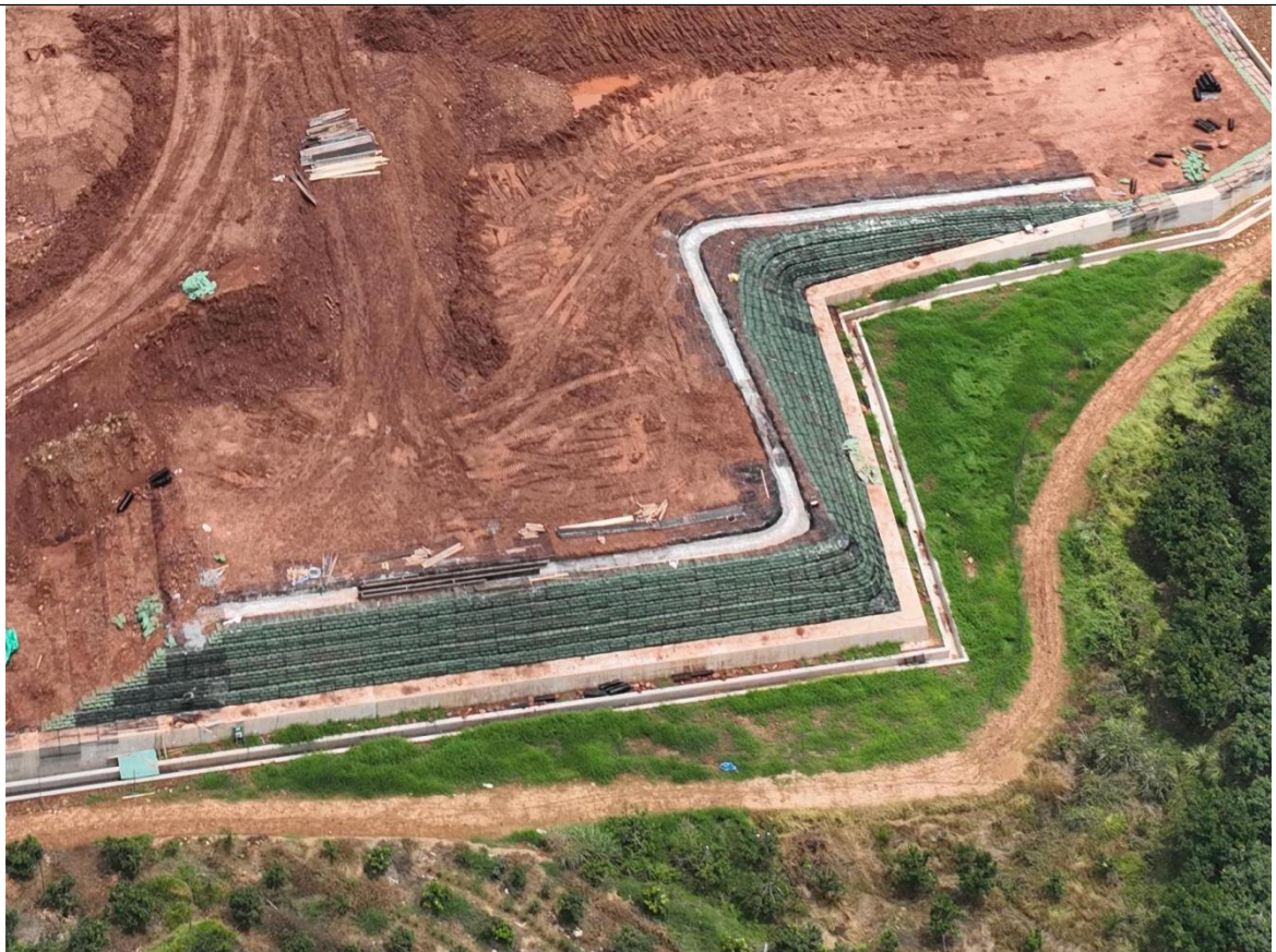
植基袋护坡及站外排水
