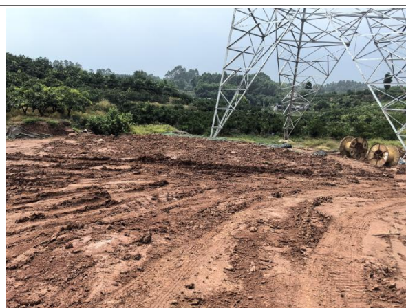
牵张场（布置在塔基临时施工场地）
