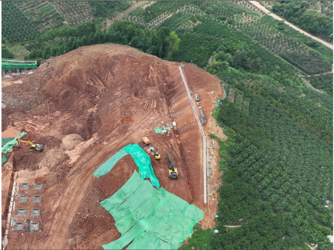
挖方边坡截水沟
