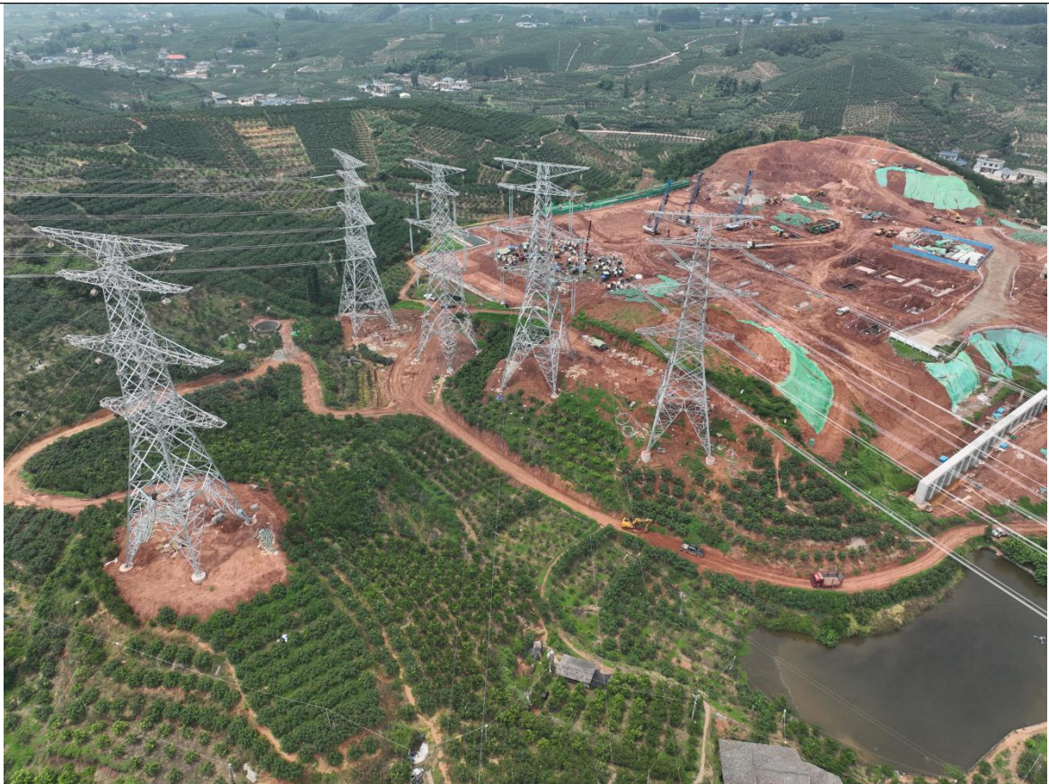
变电站外侧塔基现状
