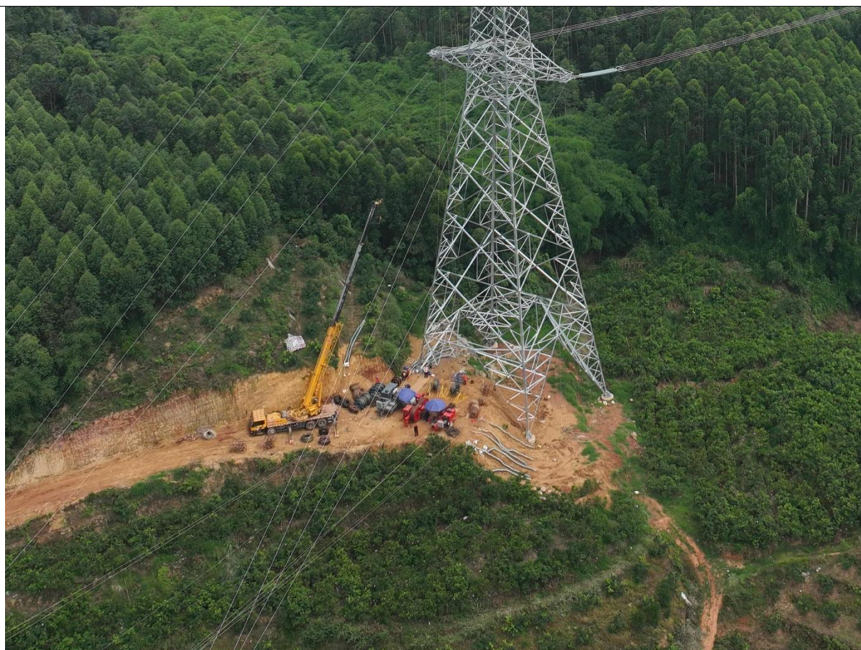
牵张场（布置在塔基临时施工场地）
