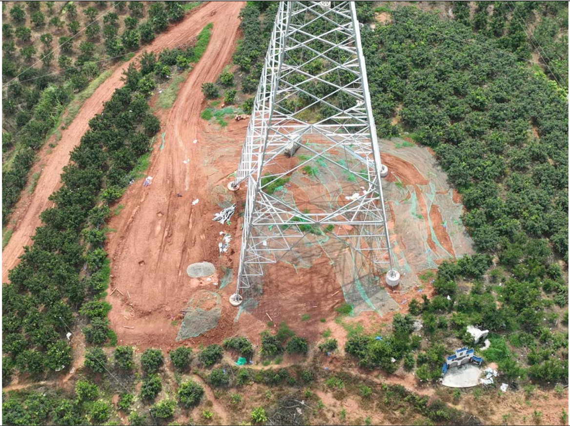
大号侧塔基现状
