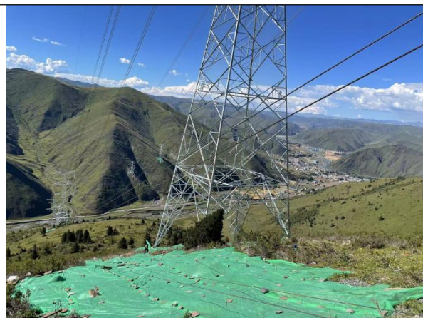
N18 植草恢复及无纺布苫盖
