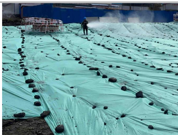
A2 植草恢复、无纺布苫盖及洒水养护
