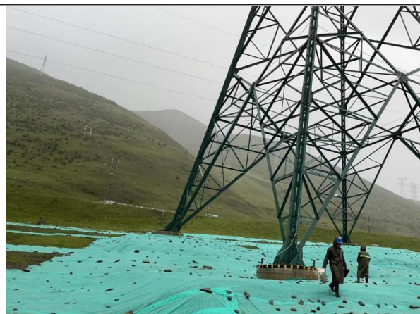
A17 植草恢复及无纺布苫盖
