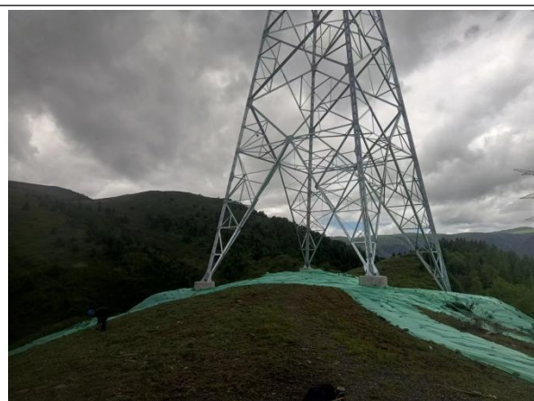
N5 植草恢复及无纺布苫盖
