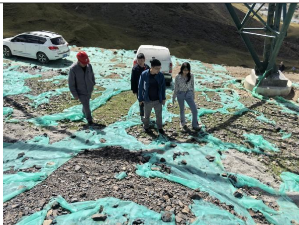
现场检查 A10
