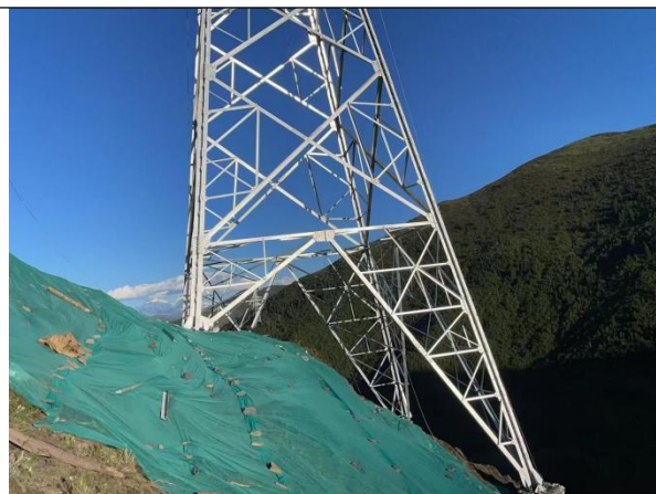
N7 植草恢复及无纺布苫盖
