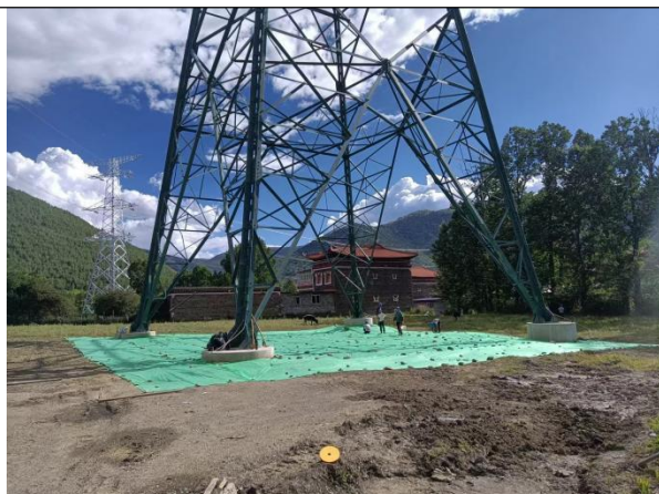
B1 土地整治、植草恢复及无纺布苫盖
