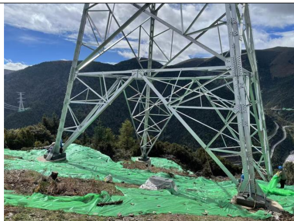
N1 植草恢复及无纺布苫盖
