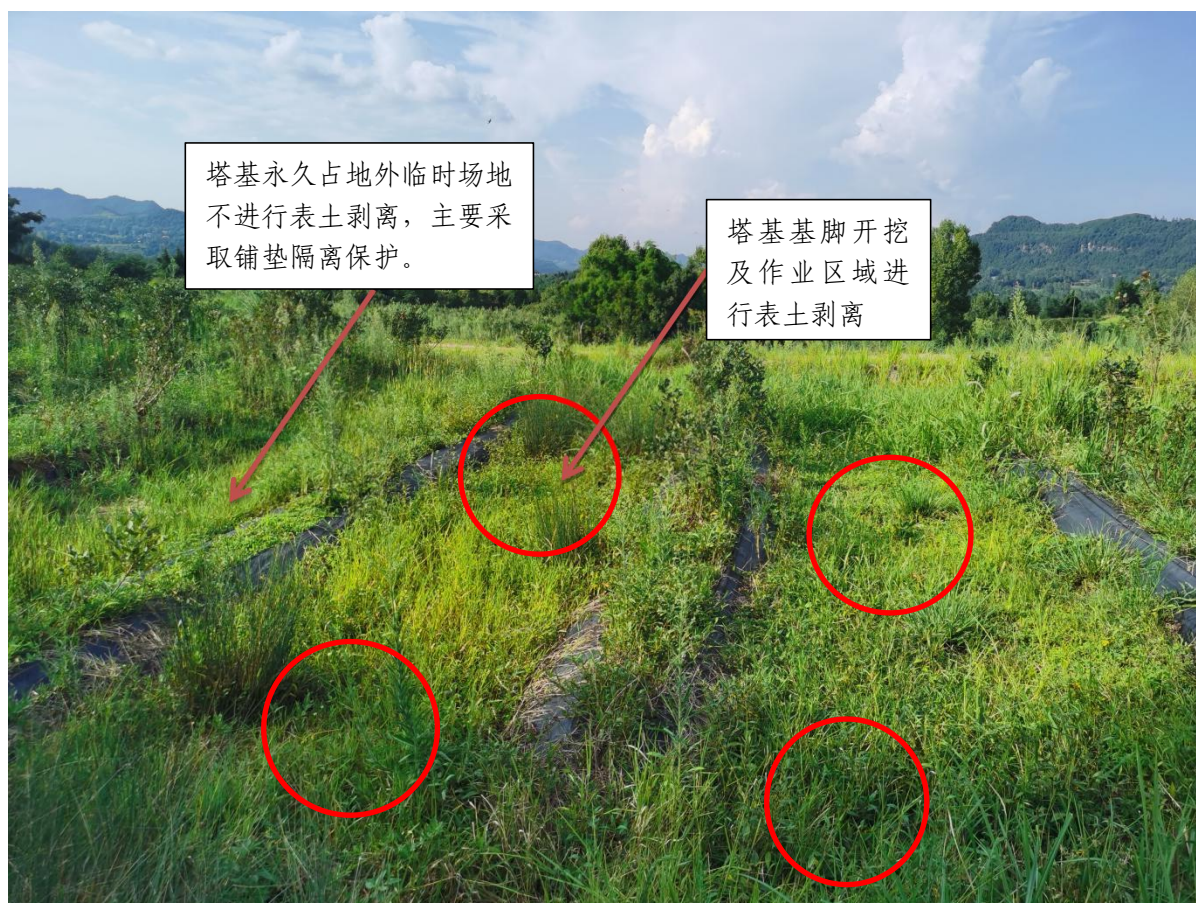
塔基表土剥离规划示意
