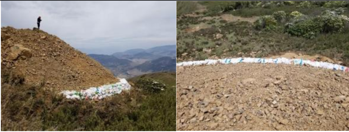
图5.3-4同类工程临时堆土土袋拦挡措施
