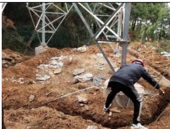
图2.1-1同类项目接地极施工
