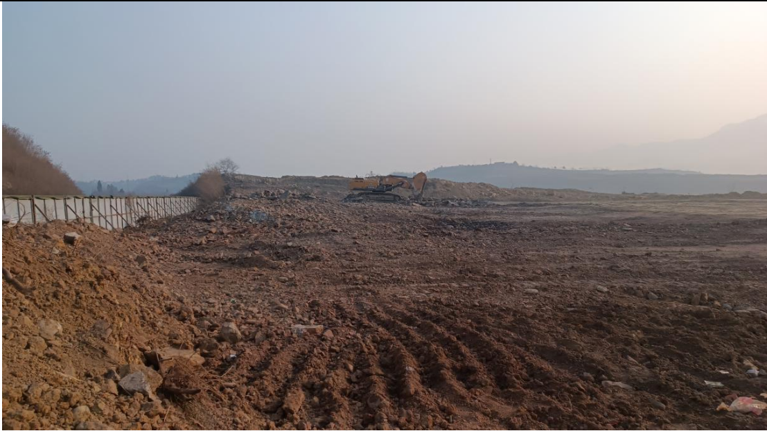
站址现场照片1
