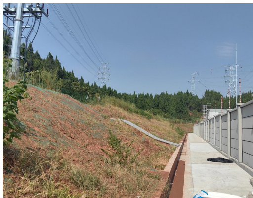
变电站站区截水沟和边坡绿化
