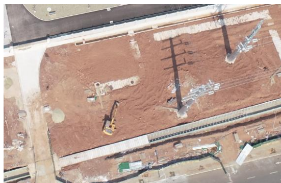
施工临时设施区
