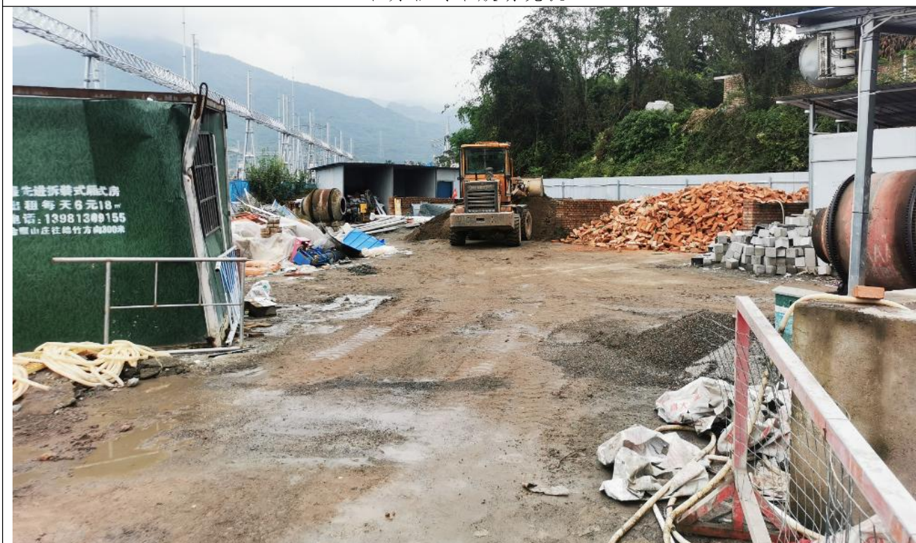
2#施工场地现状
