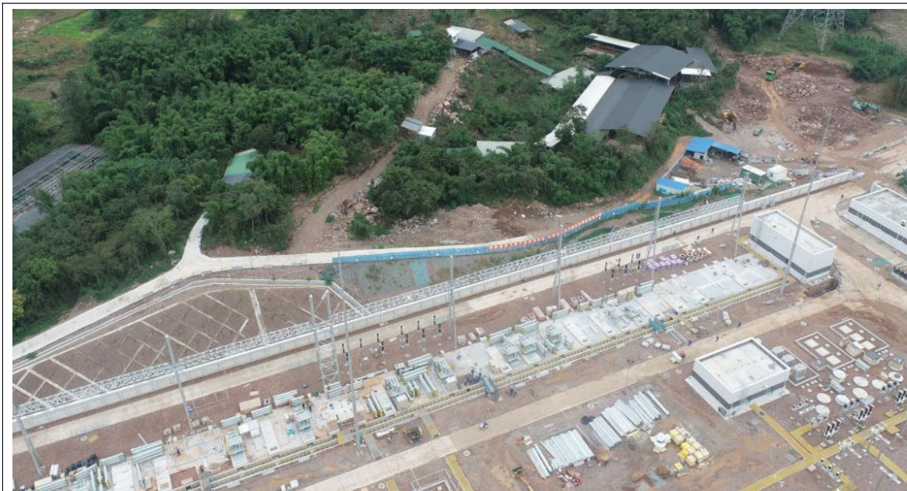
开关站东侧自然放坡段边坡密目网覆盖
