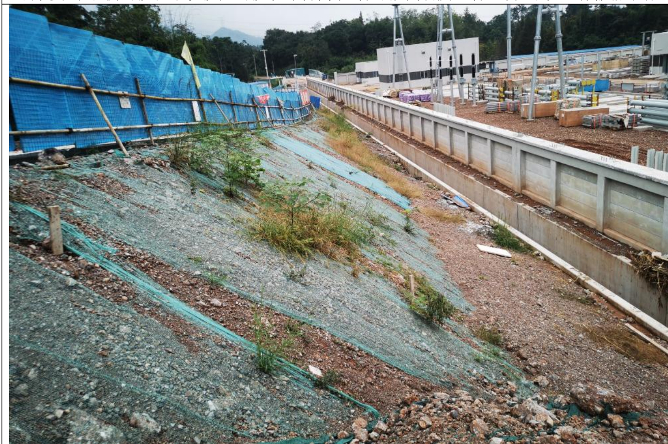
开关站周边围墙修建，围墙外建排洪沟，自然放坡段裸露地表临时遮盖
