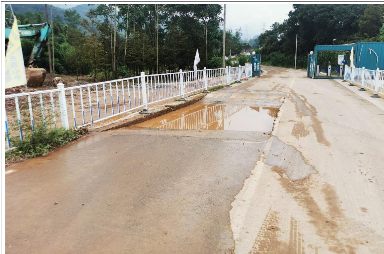
场地出入口新设置洗车槽
