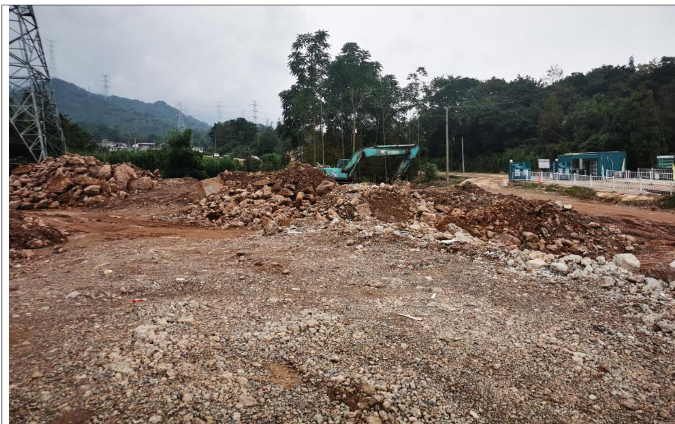
石方临时堆放场现状
