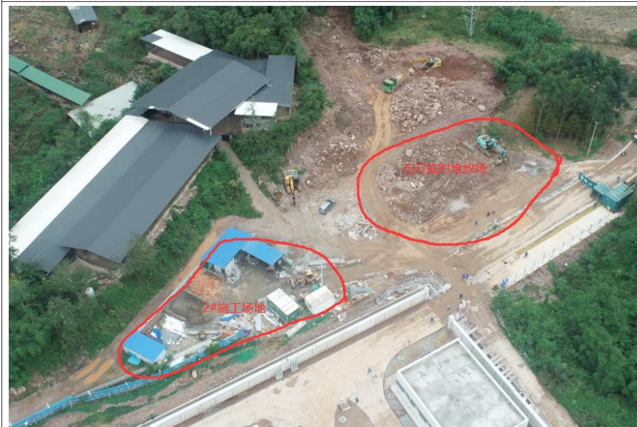
2#施工场地和石料临时堆放场现状（后面如果不再使用，建议土地整治后恢复原现状）
