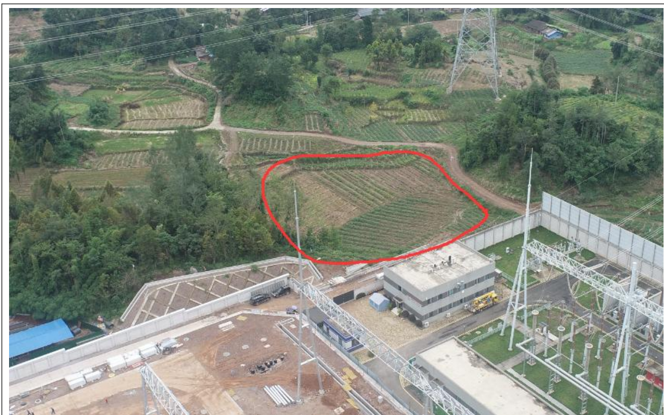
开关站南侧边坡框架护坡，坡顶设截水沟，坡底设排洪沟；方案设计表土堆放场现状
