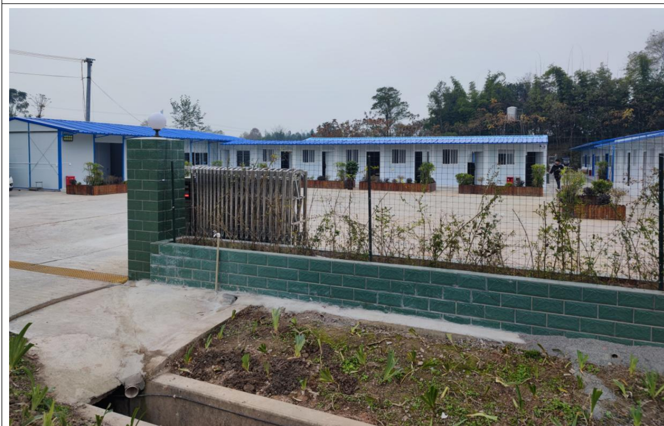
1#施工场地现状
