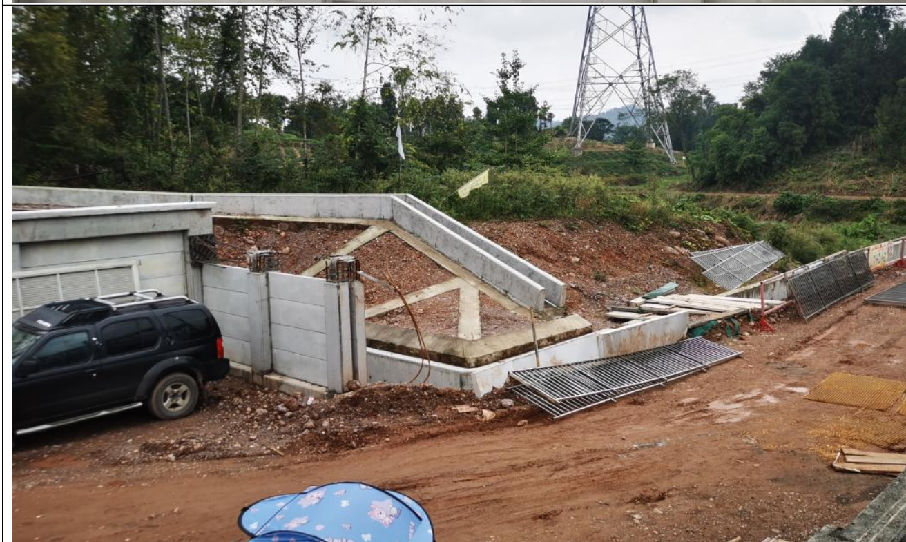
开关站南侧边坡框架护坡，边坡顶部设截水沟，底部设排洪沟，建议尽快进行撒播草籽
