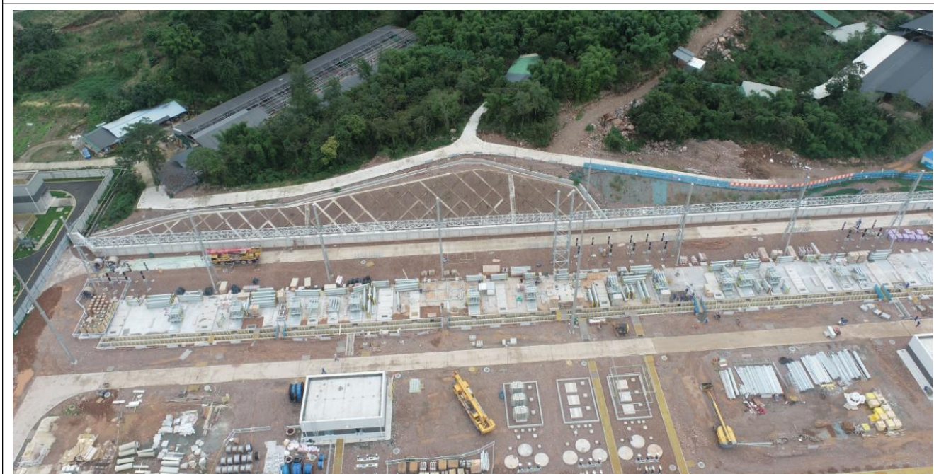
开关站东侧边坡框架护坡，坡顶设截水沟，坡底设排洪沟；还建路现状
