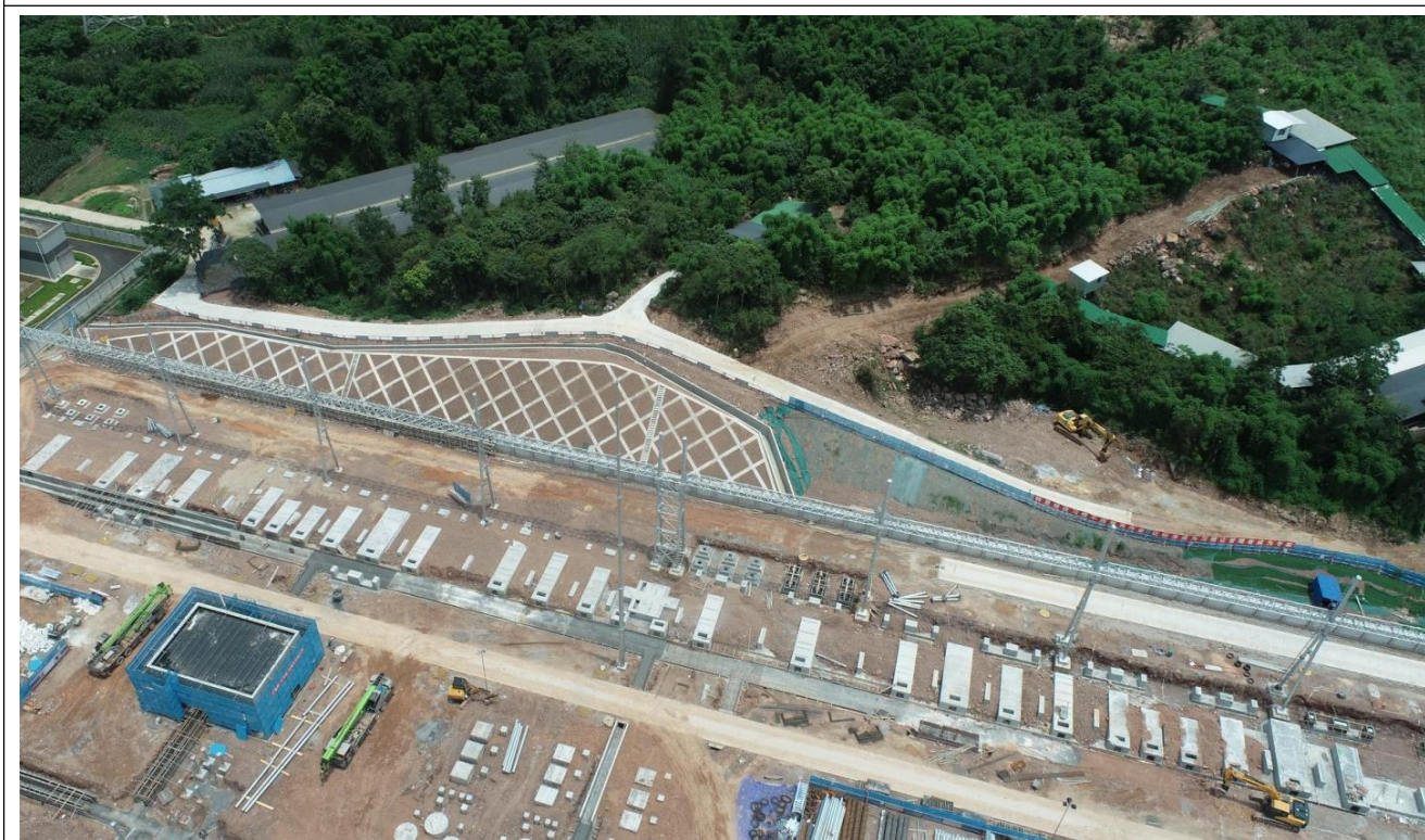
开关站东侧边坡框架护坡，坡顶设截水沟，坡底设排洪沟；还建路现状
