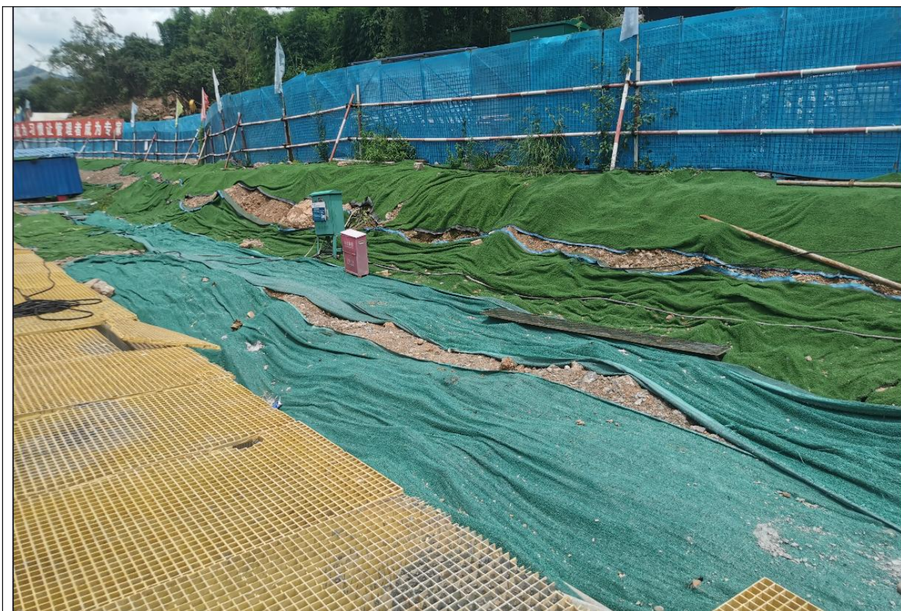
开关站外裸露地表临时遮盖
