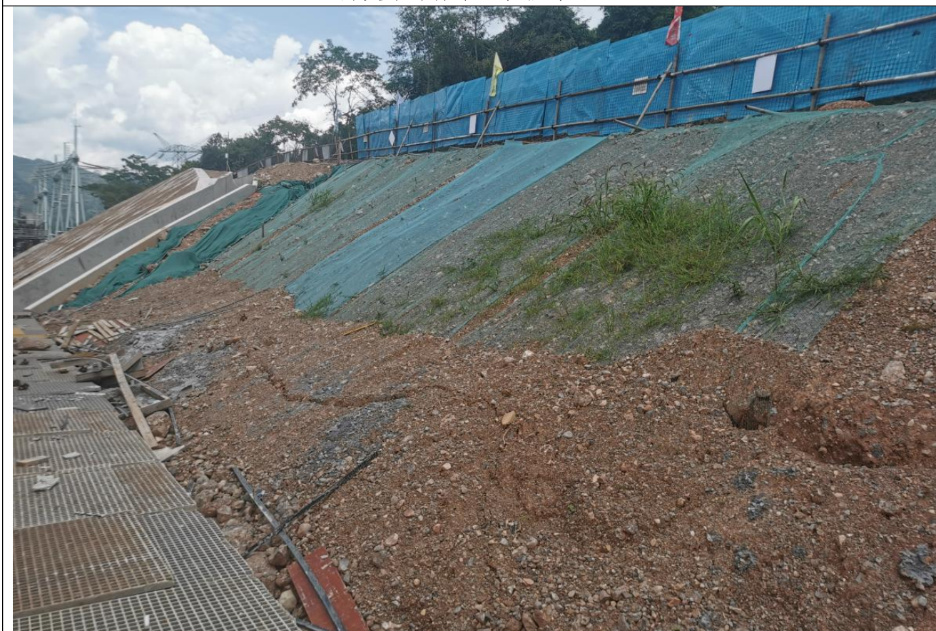
开关站东侧自然放坡边坡建议采用防水布遮盖
