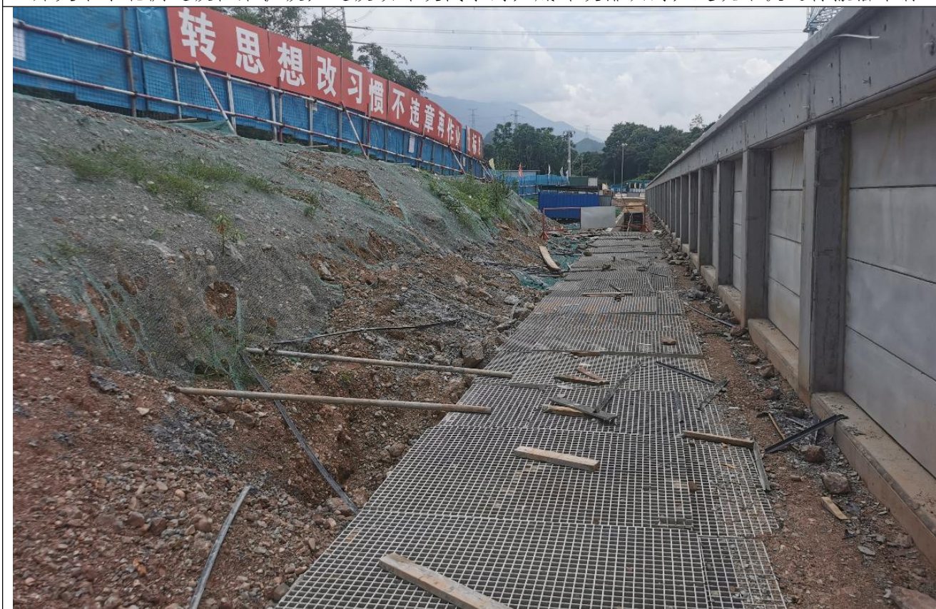
开关站周边围墙修建，围墙外建排洪沟，自然放坡段裸露地表临时遮盖
