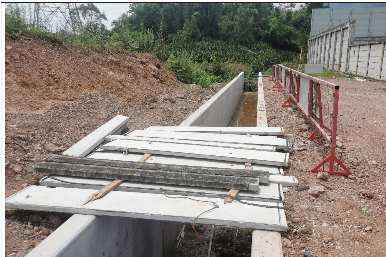
开关站南侧排洪沟排入现有水系
