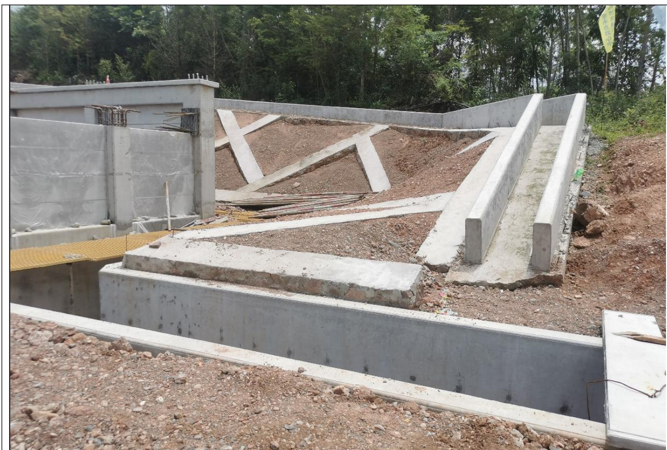
开关站南侧边坡框架护坡，边坡顶部设截水沟，底部设排洪沟，建议尽快进行撒播草籽
