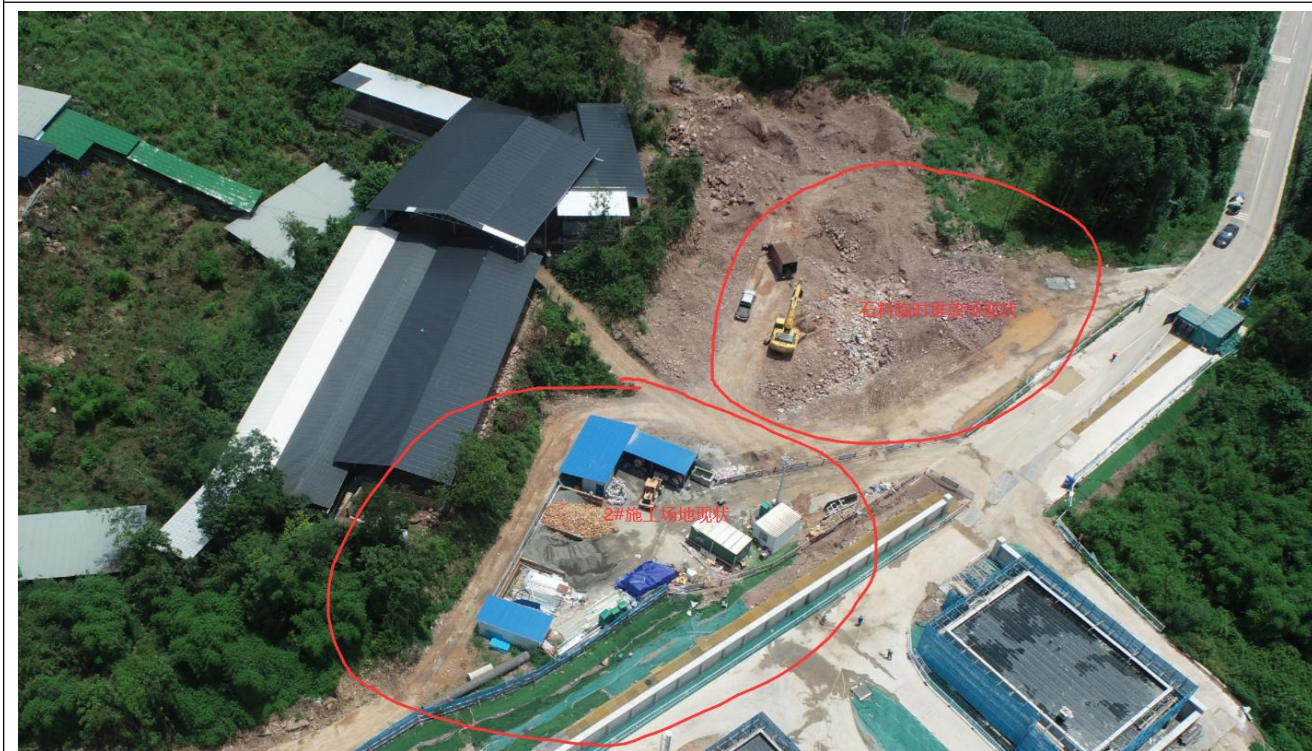
2#施工场地和石料临时堆放场现状（后面如果不再使用，建议土地整治后恢复原现状）
