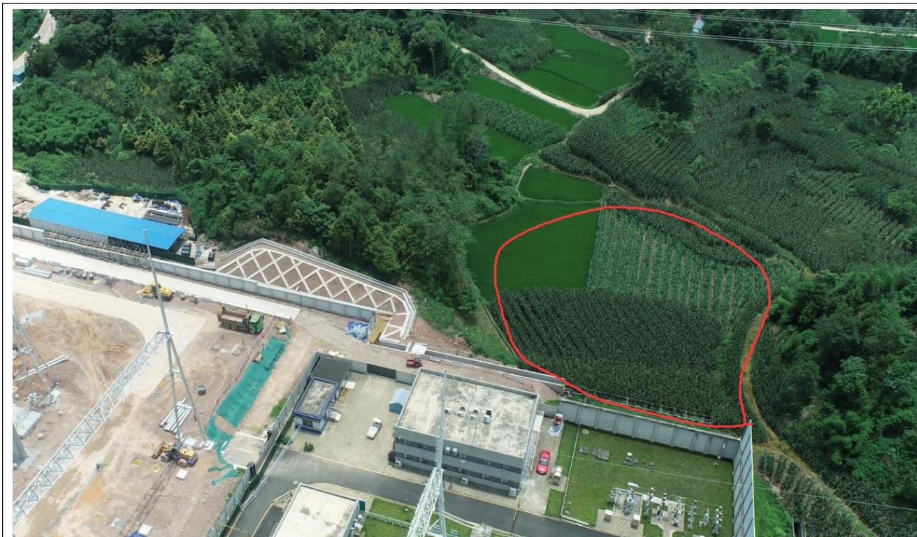
开关站南侧边坡框架护坡，坡顶设截水沟，坡底设排洪沟；方案设计表土堆放场现状
