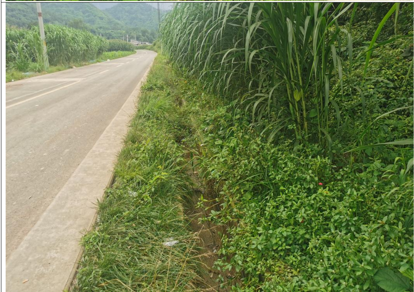
进场道路排水沟及周边绿化恢复
