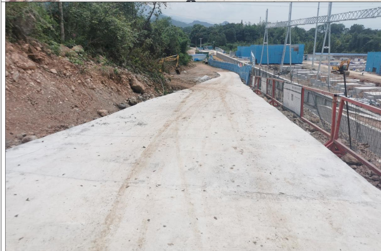
还建道路现状地面硬化
