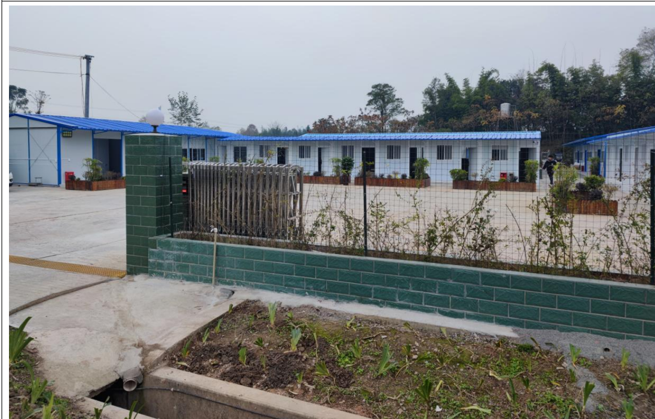
1#施工场地现状
