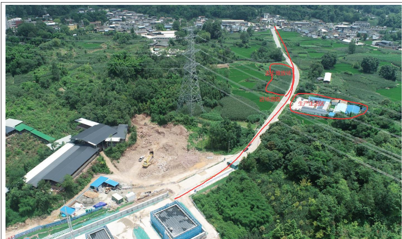
新设表土堆场、1#施工场地、已有进场道路现状
