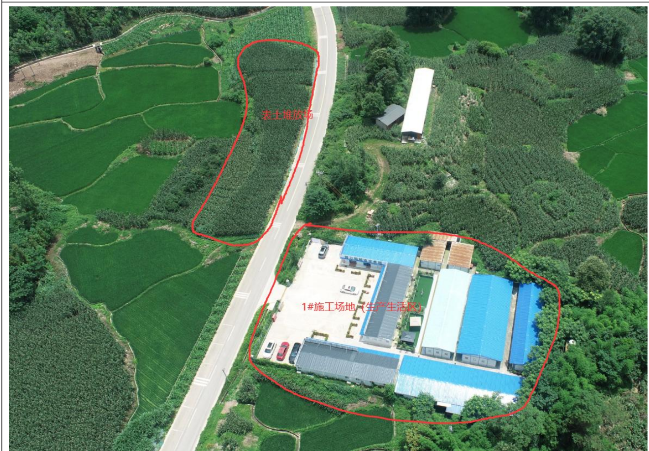
新设表土堆场当地农民耕作和 1#施工场地（施工生产生活区）硬化
