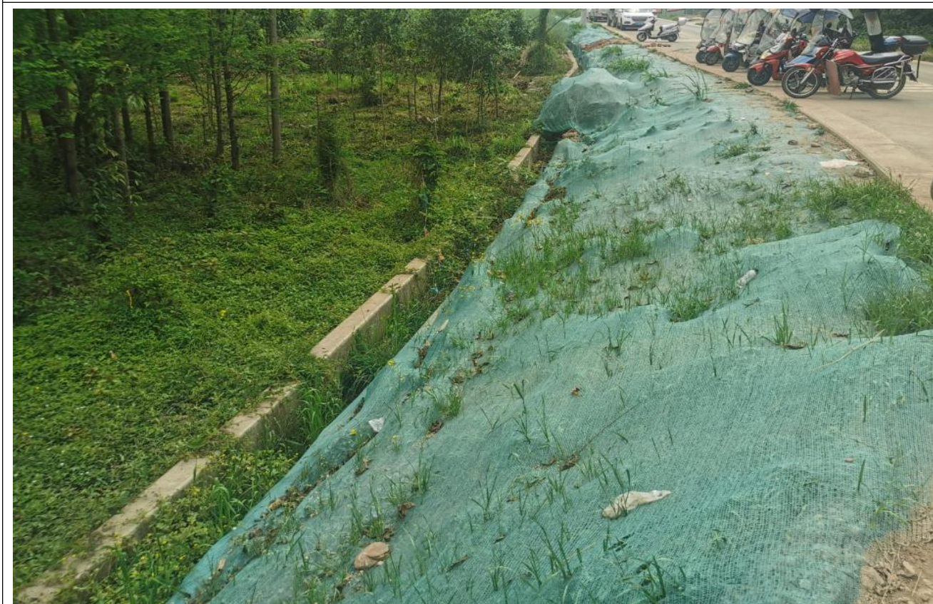
原进站道路及道路边沟
