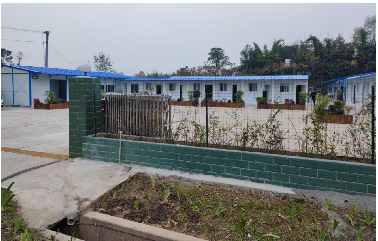
1#施工场地现状
