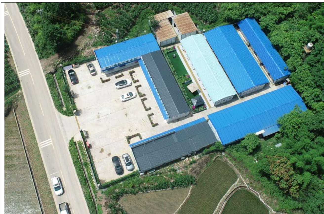
1#施工场地用于施工期生产生活
