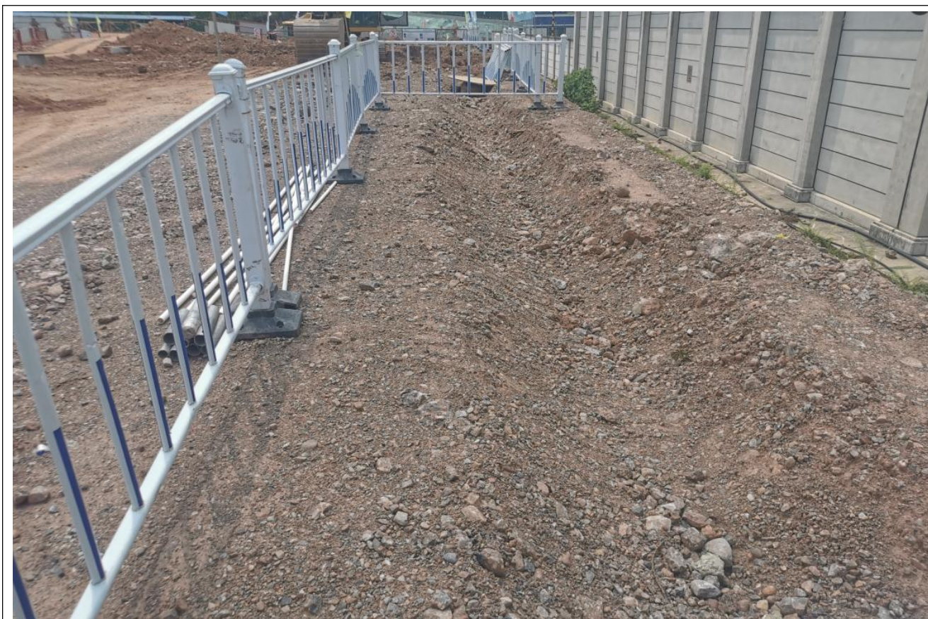
扩建开关站临时排水沟
