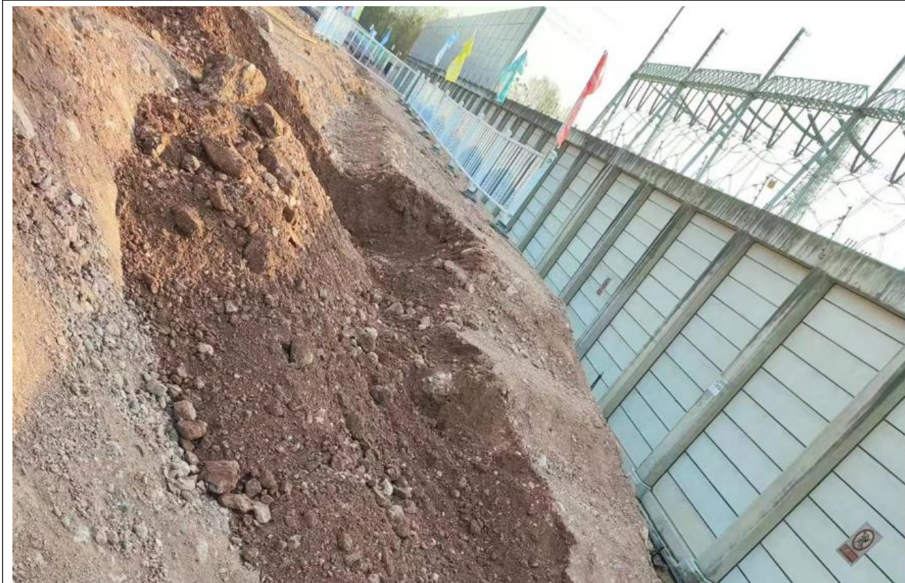
扩建开关站临时沉砂池
