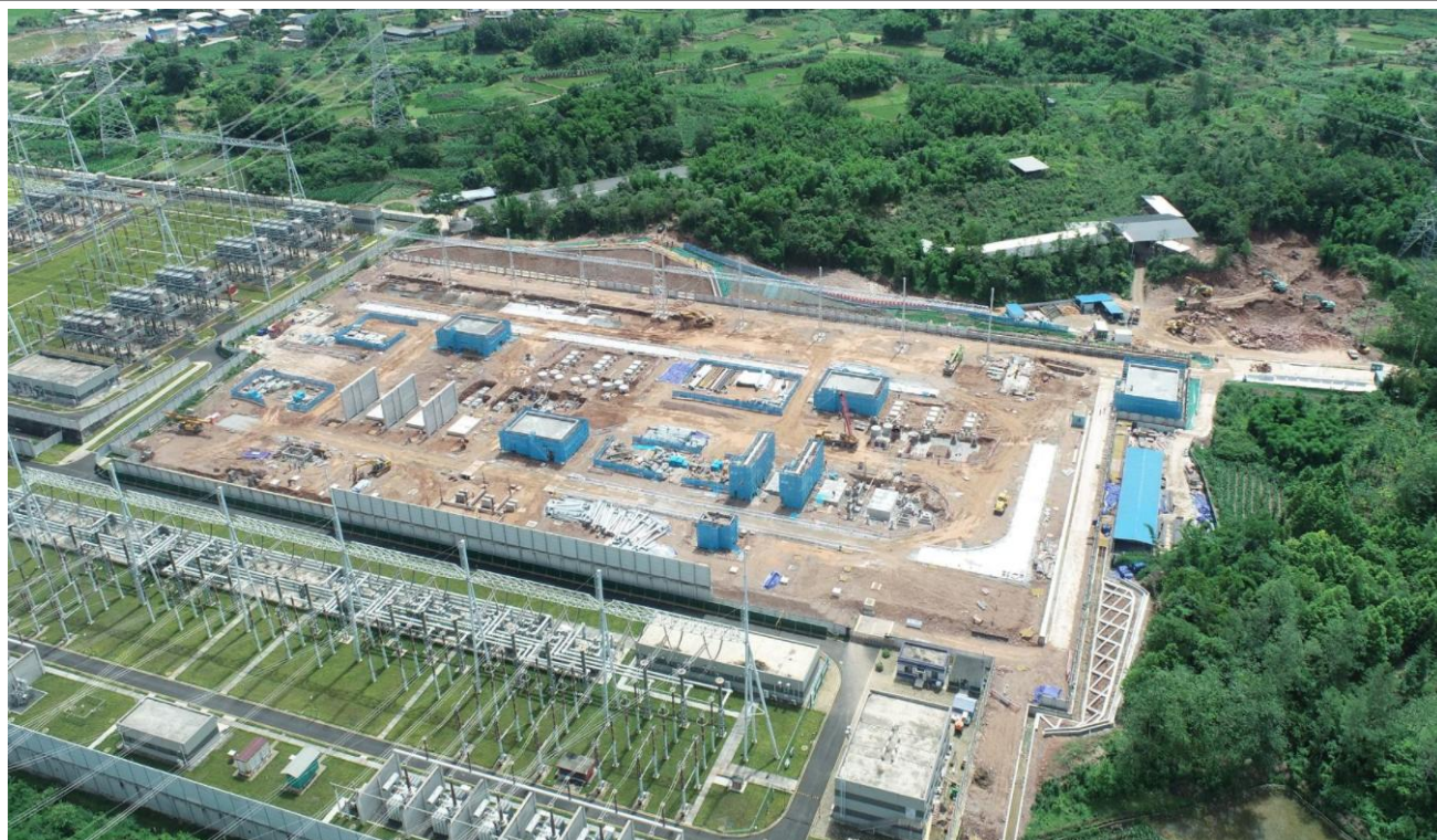
开关站扩建工程施工现状
