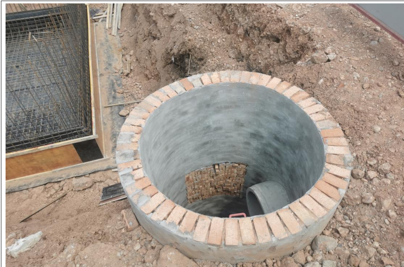
扩建开关站内管道施工
