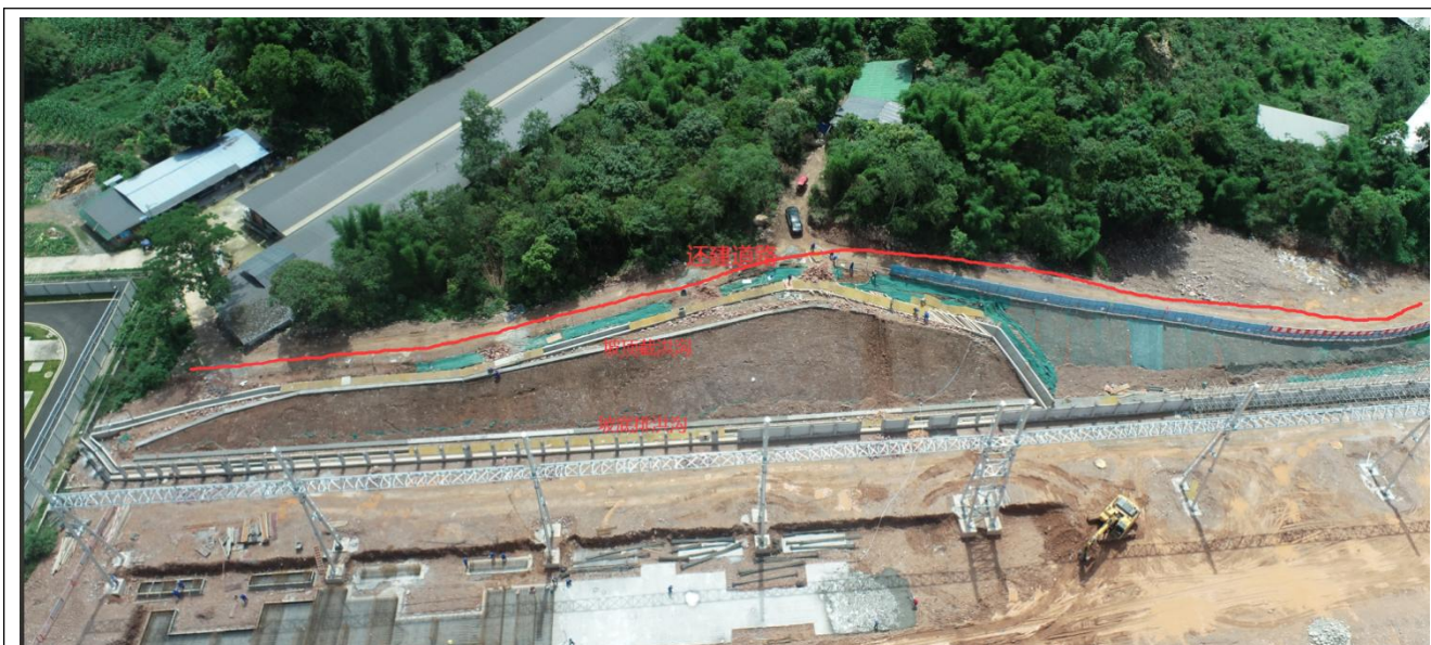
还建道路现状及开关站扩建工程区坡顶截水沟和坡底排水沟
