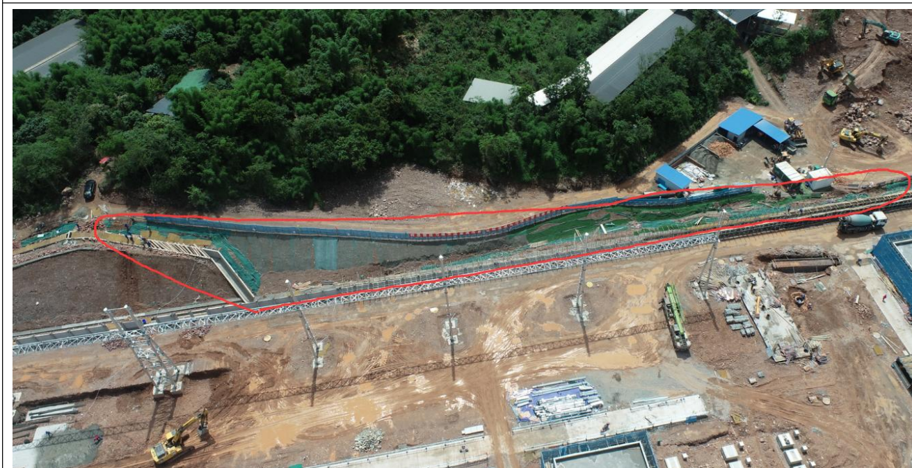
开关站扩建工程区裸露边坡防水布遮盖
