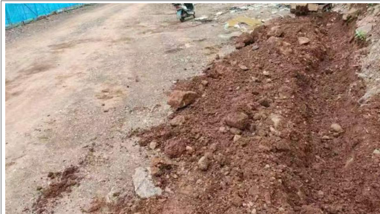
还建道路新挖临时排水沟
