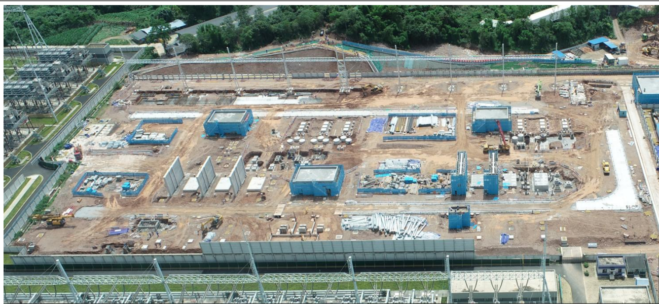
主体工程正在进行基桩施工
