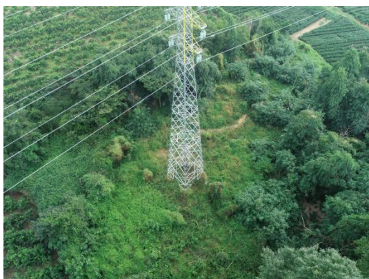
东山村林草地 N46 塔基区、人抬道路植被恢复
