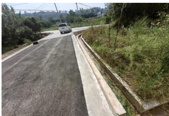
站外排水沟及迹地恢复
