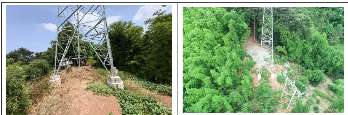
N25 塔基区域植被恢复差
