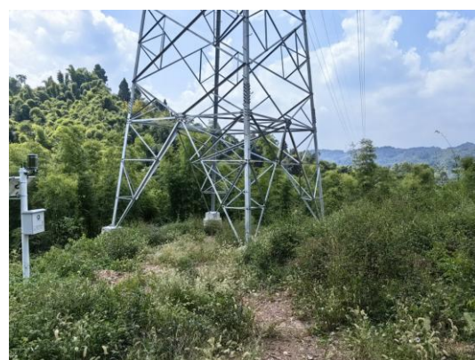
N19 塔基区植被恢复
