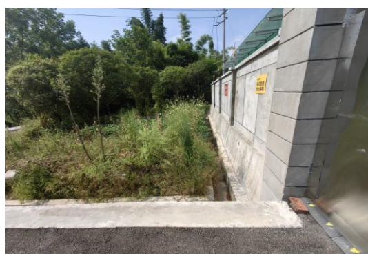
站外排水沟及迹地恢复
