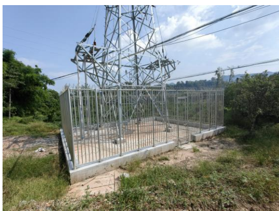
火井站外 NB1 塔位现状
