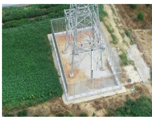
平乐站外 N48 塔基及牵张场迹地恢复
