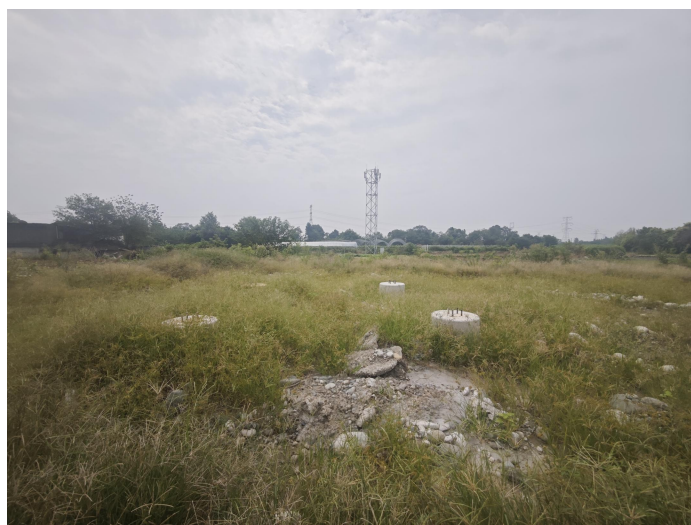
图 4.3-2 N25 塔基施工临时占地区域存在建渣未清理
