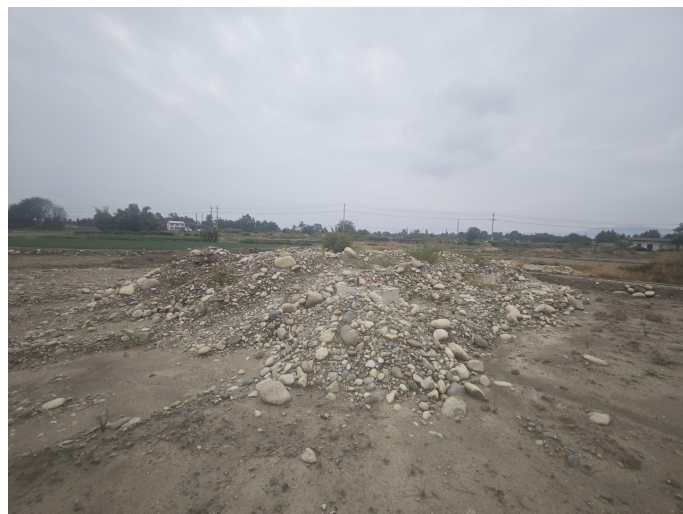
图 4.3-6 N46 塔基施工临时占地区域存在建渣未清理，塔基施工临时占地区域堆存土石方未进行清理、临时堆存期间未进行遮盖、拦挡。
