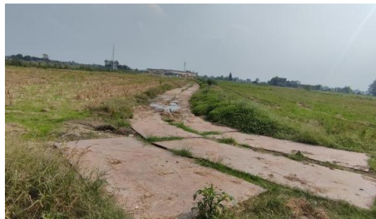
苏场—福田 N5 塔位施工道路现状
