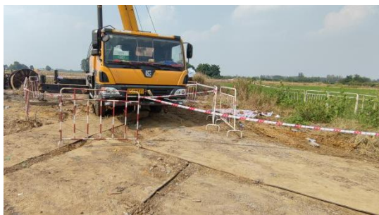
高埂—赵塔 N1 塔位牵张场铺设钢板
