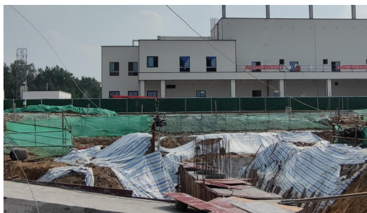
高埂—赵塔电缆沟临时遮盖
