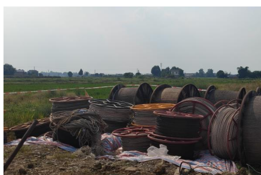
高埂—赵塔 N1 塔位牵张场铺垫隔离
