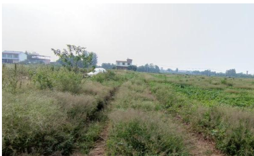
邓寿安线 N25 塔位施工道路现状
