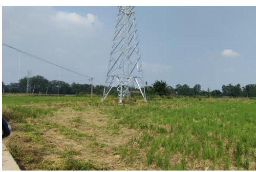
苏场—邛崃 N9 塔位现状
