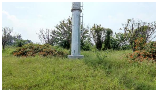
高埂—赵塔 N36 塔位现状
