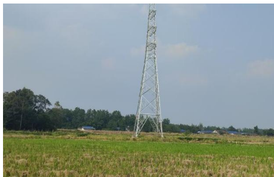
苏场—邛崃 N7 塔位现状
