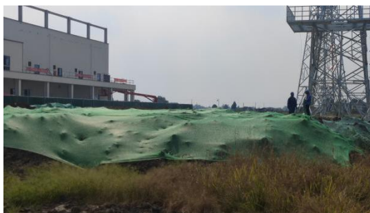
高埂—赵塔电缆沟临时堆土区临时遮盖
