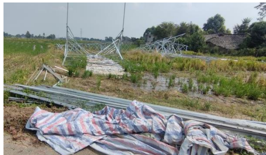
苏场—邛崃 N5 塔位施工场地铺垫隔离
