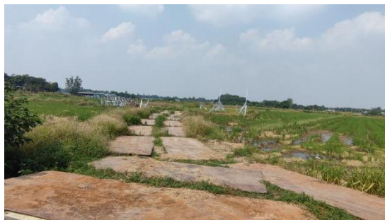
苏场—福田 N6 塔位施工道路现状
