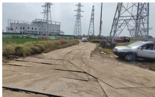
5 条线路 N1 塔位施工道路铺设钢板
