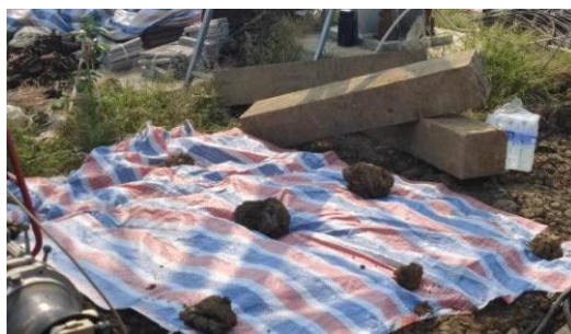
高埂—赵塔 N1 塔位牵张场临时遮盖
