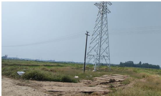
庄园—解林 N18 塔位施工道路现状
