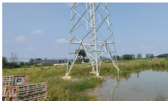
邓寿安线 N5 塔位现状
