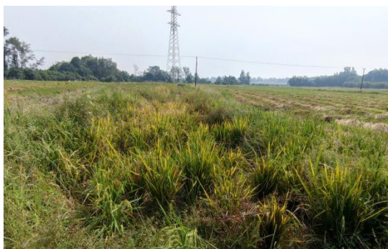
邓寿安线 N16 塔位施工道路现状
