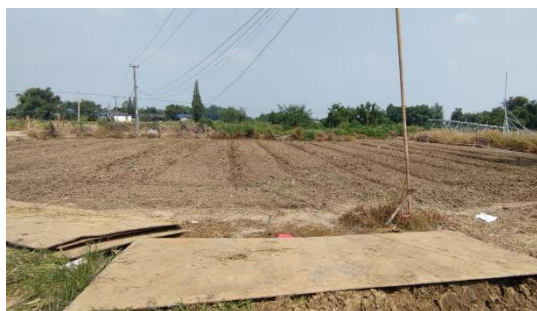
苏场—邛崃 N6 塔位施工场地铺设钢板
