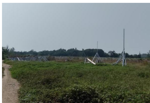
庄园—解林 N23 塔位现状
