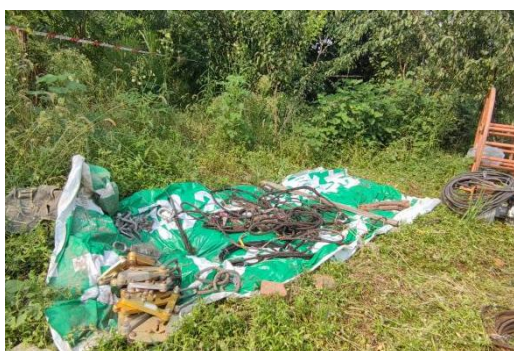
高埂—赵塔 N16 塔位牵张场铺垫隔离
