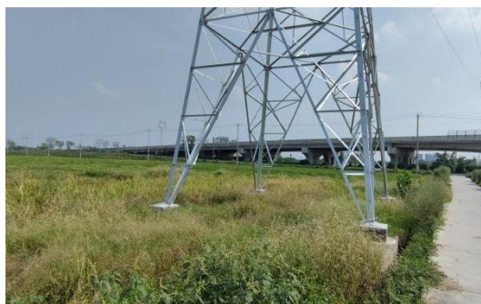
高埂—赵塔 N18 塔位现状
