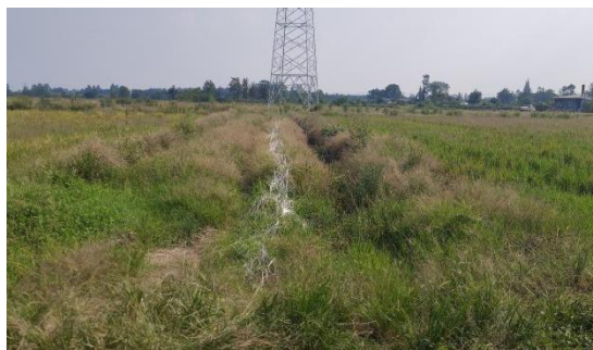
高埂—赵塔 N11 塔位施工道路现状
