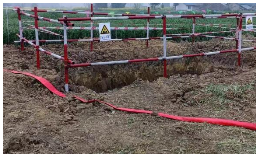
高埂—赵塔 N13 塔位泥浆沉淀池
