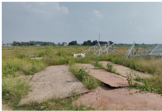
苏场—福田 N4 塔位现状
