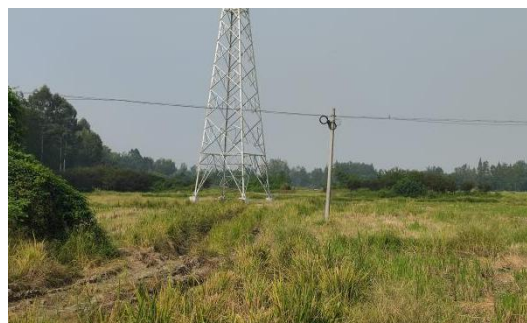
邓寿安线 N15 塔位现状
