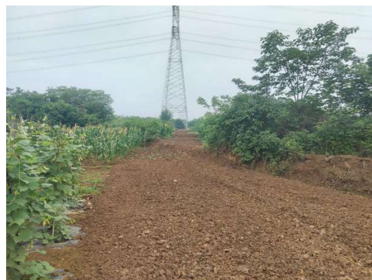
NL11 号塔施工道路土地整治
