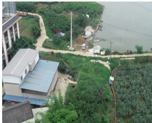
NR19 号塔牵张场植被恢复
