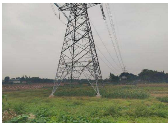
NR5 号塔施工场地恢复
