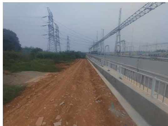
还建道路现状
