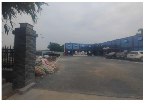
施工临建区现状
