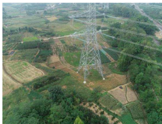
NL12 号塔施工场地植被恢复
