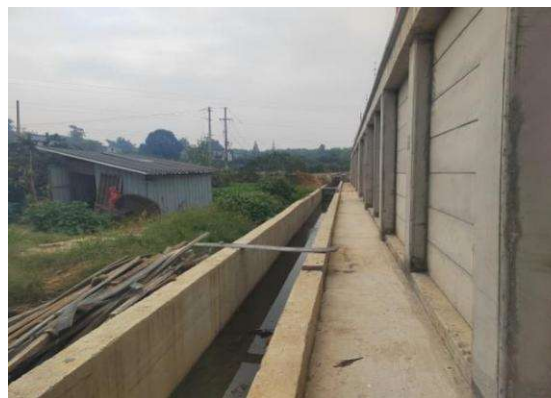
变电站截排水沟
