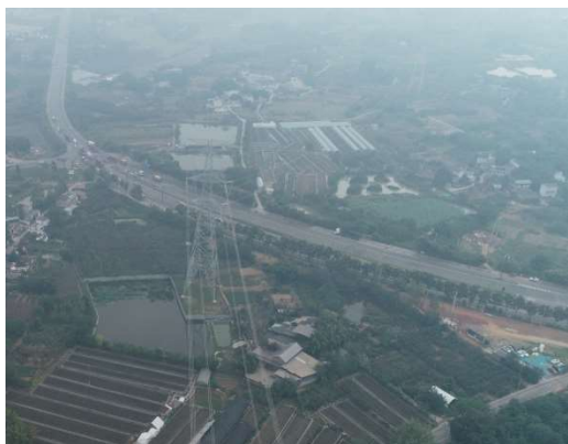
NR2-NR3 跨越场现状
