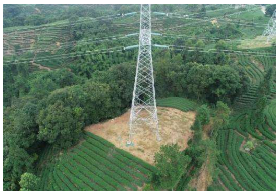
NA58 塔位施工场地现状（土地整治）
