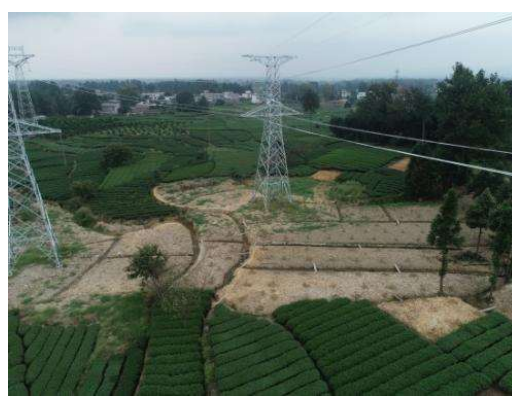
NA75 号塔基施工道路现状
