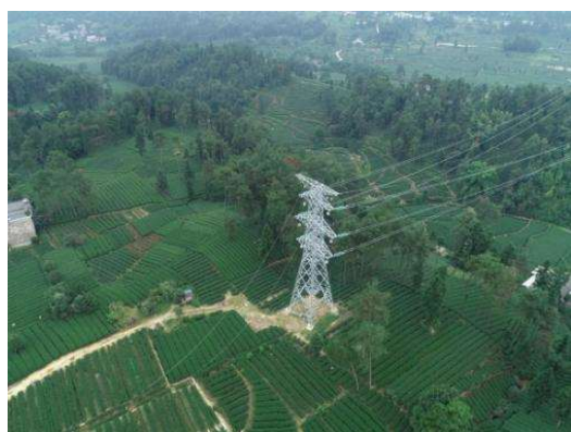
NA81 塔基施工场地现状
