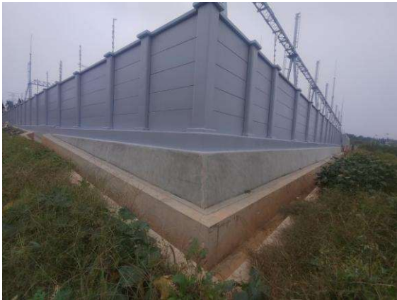
站外截排水沟现状
