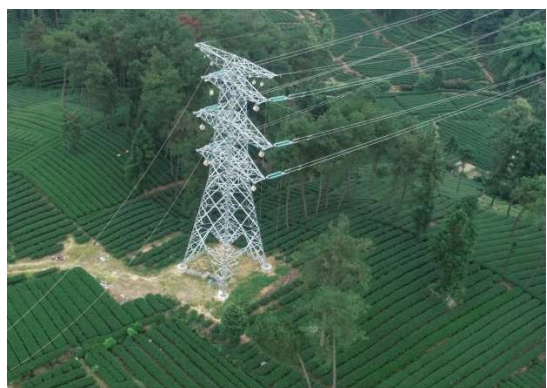
NA85 号塔基施工场地现状（土地整治）
