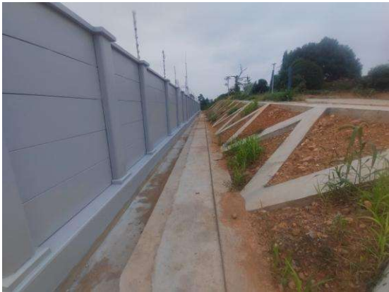
站区框格植草护坡施工现状
