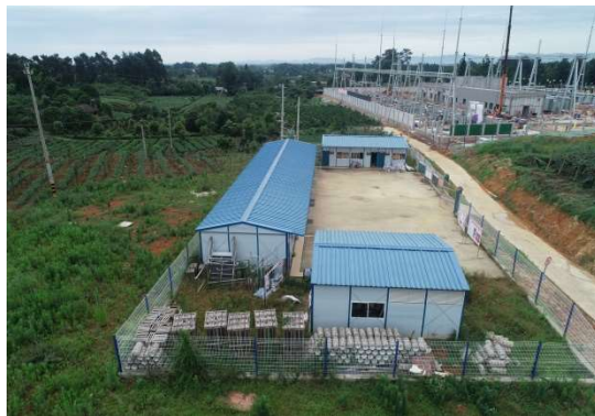
施工临建区现状
