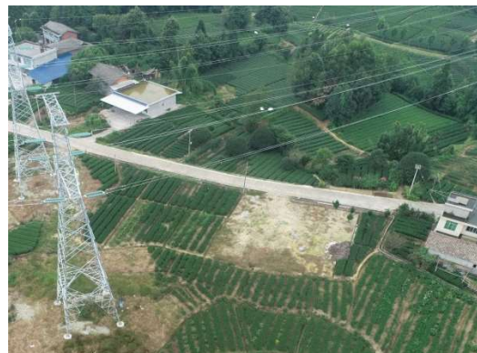
NA68NB61 牵引场现状（土地整治）
