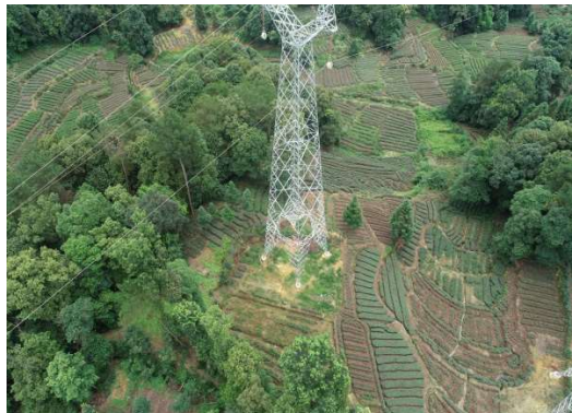
NB55 号塔基施工场地现状（土地整治）
