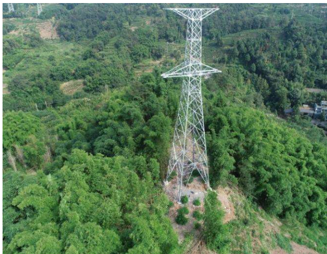
图 4.3-2 NA13 基面有建渣、未进行植被恢复
