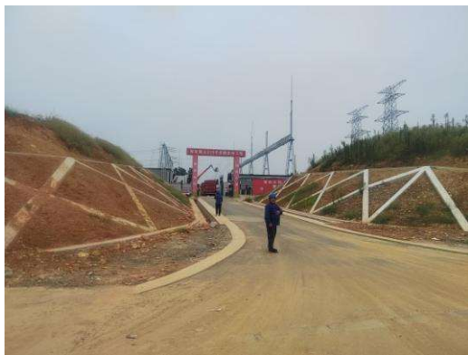
进站道路护坡现状（框格护坡）
