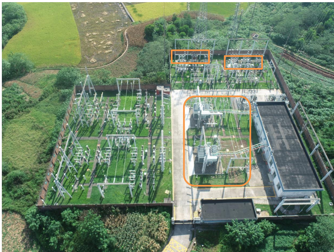
徐家桥 110kV 变电站扩容扩建工程施工后草坪恢复现状
