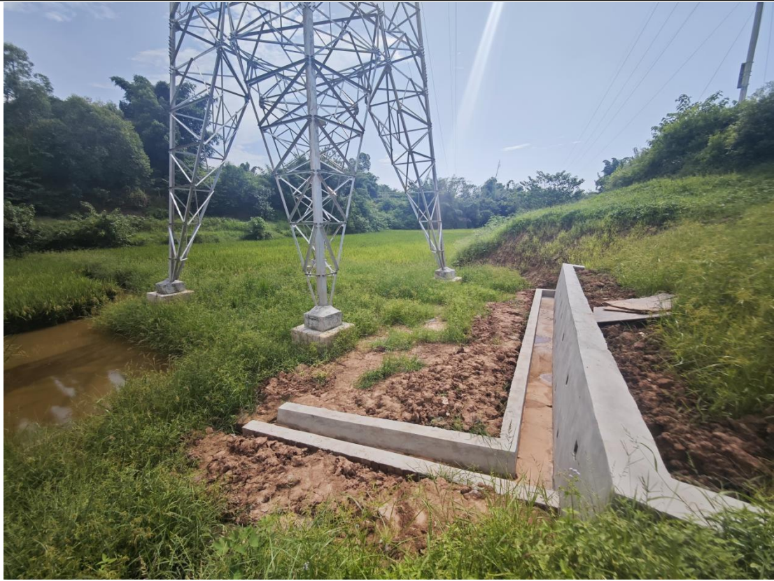
N24 及浆砌石排水沟
