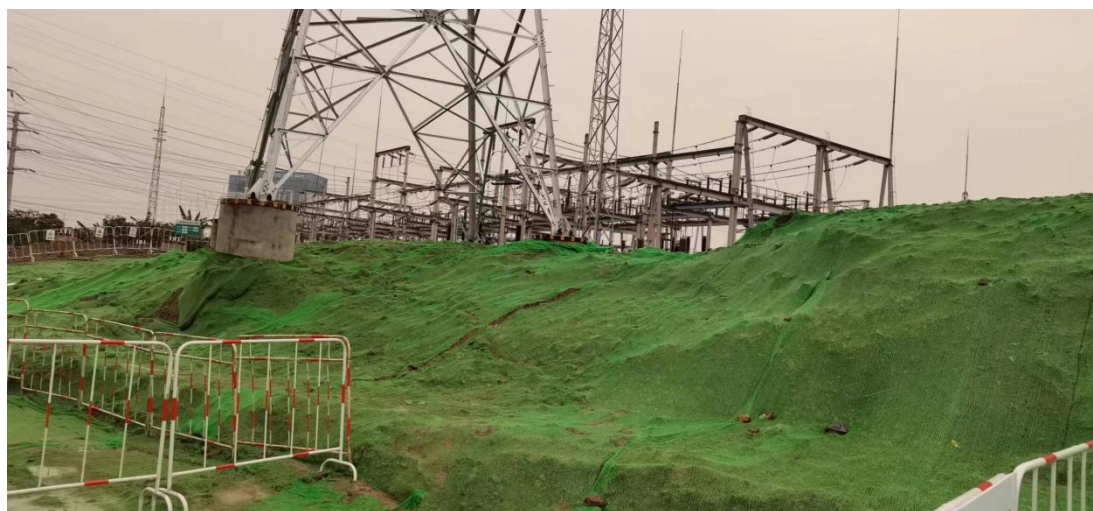
N2 施工现场图 (1)
