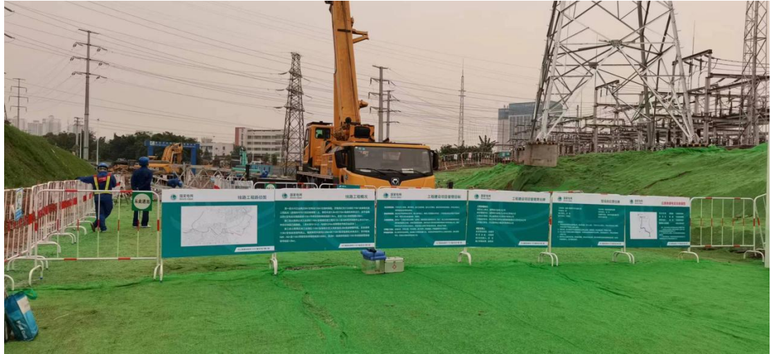
N2 施工现场图 (2)
