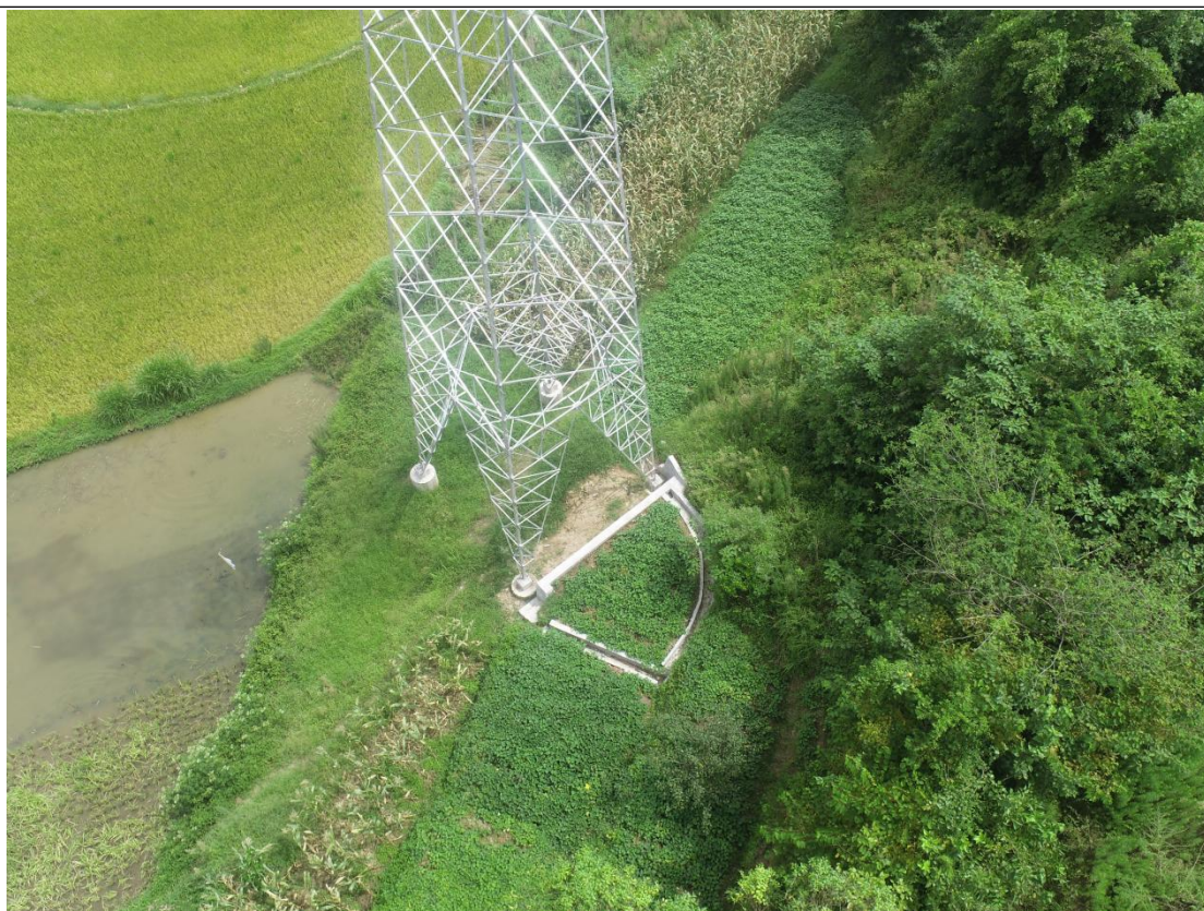
N10 及浆砌石排水沟
