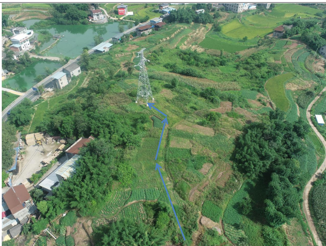
N25 施工道路
