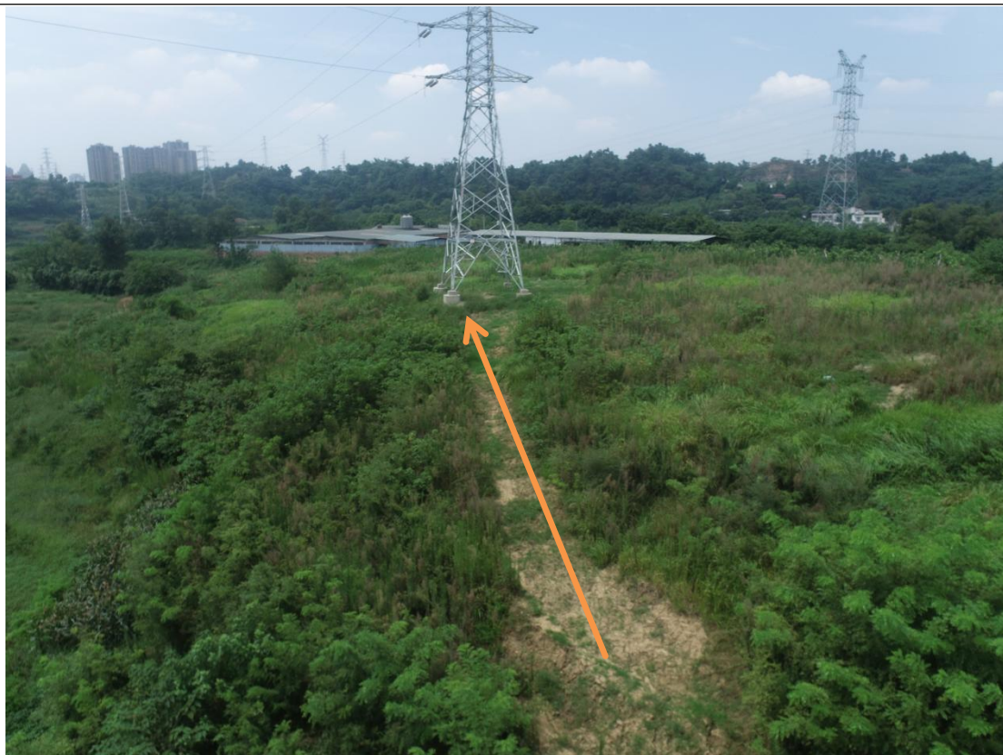
N8 施工道路
