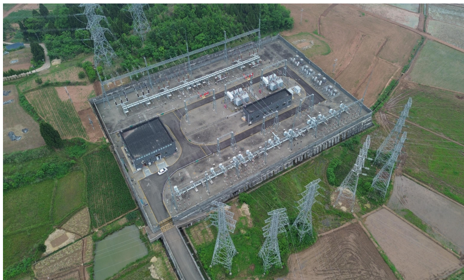
图变电站现状
