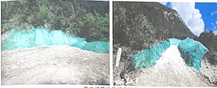
施工道路边坡盖防护
