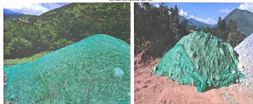
塔基及其施工场地区的生、熟土分开堆放并进行防护
