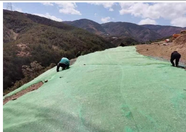
临时道路撒播草籽后密目网苫盖
