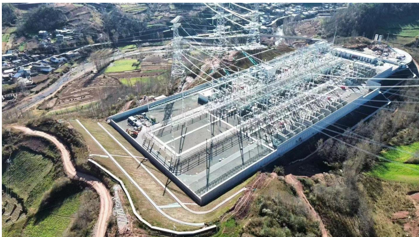
新建开关站边坡已绿化并实施了截排水措施
