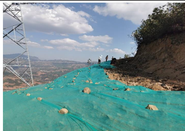
塔基施工区域密目网临时苫盖
