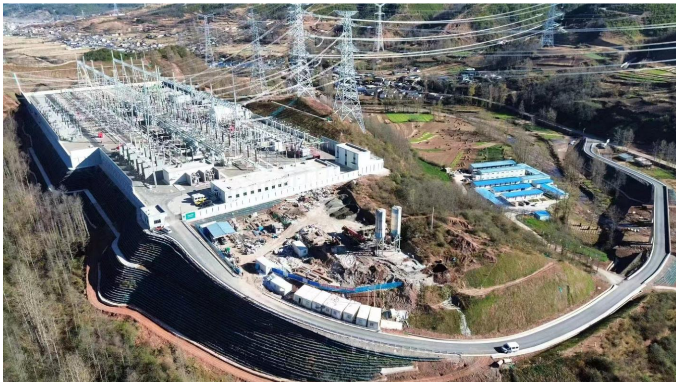
进站道路现状航拍图
