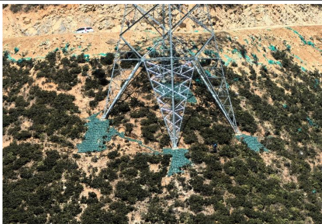
N1083#塔基已绿化并实施了土袋挡护
