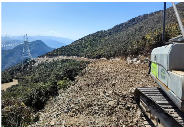
N1081#塔基临时道路修整
