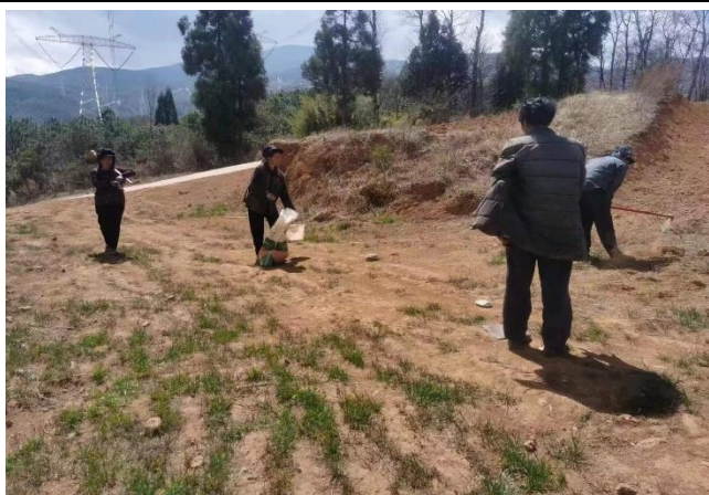
塔基施工区域撒播草籽
