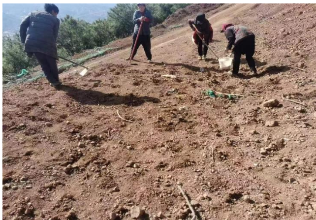
临时道路覆土平整
