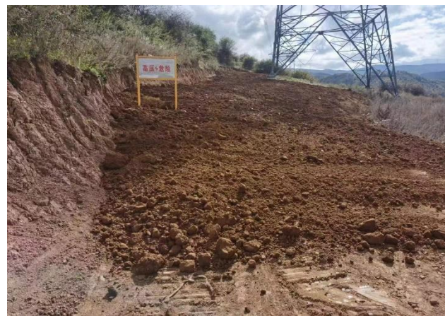
临时道路已覆土平整
