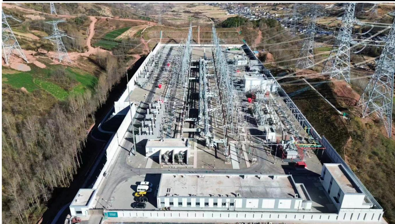
新建开关站现状航拍图
