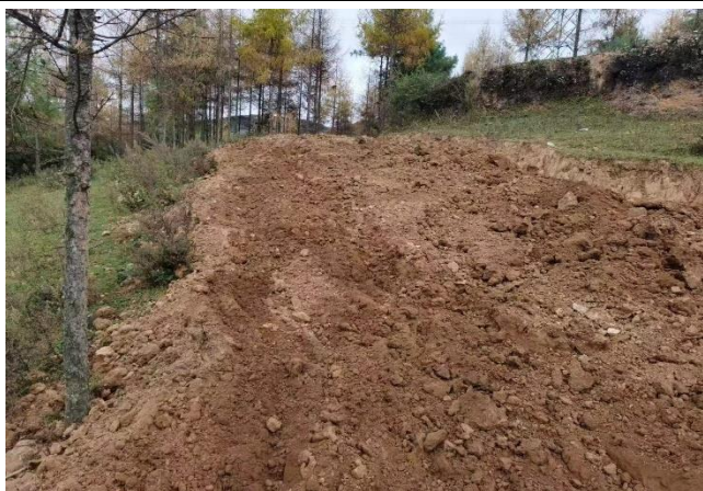
临时道路已覆土平整
