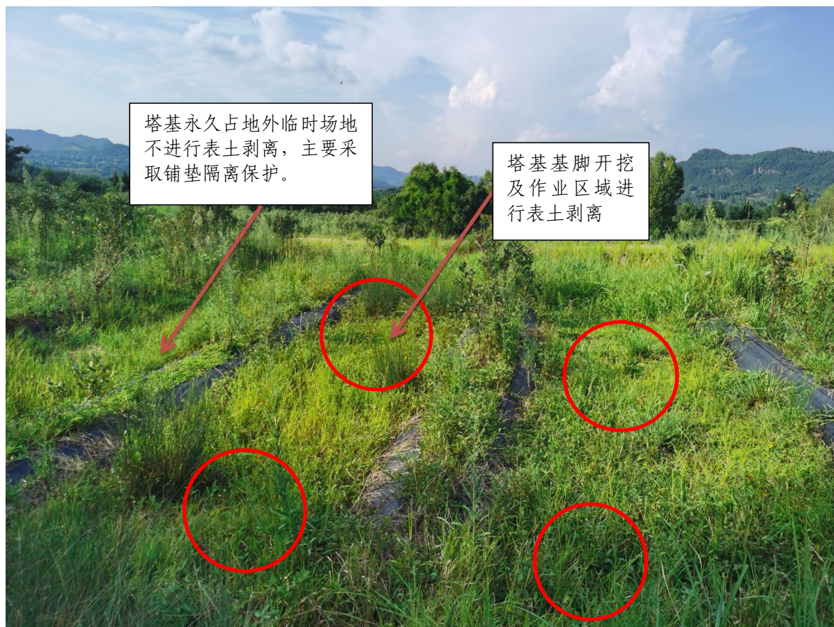
塔基表土剥离规划示例图
