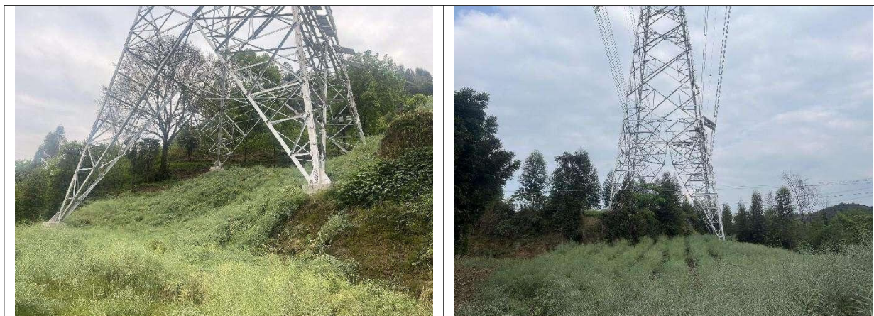
图 3-13 塔基施工临时占地复耕
