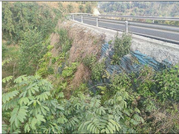
图 1-9 2#进站道路现状
