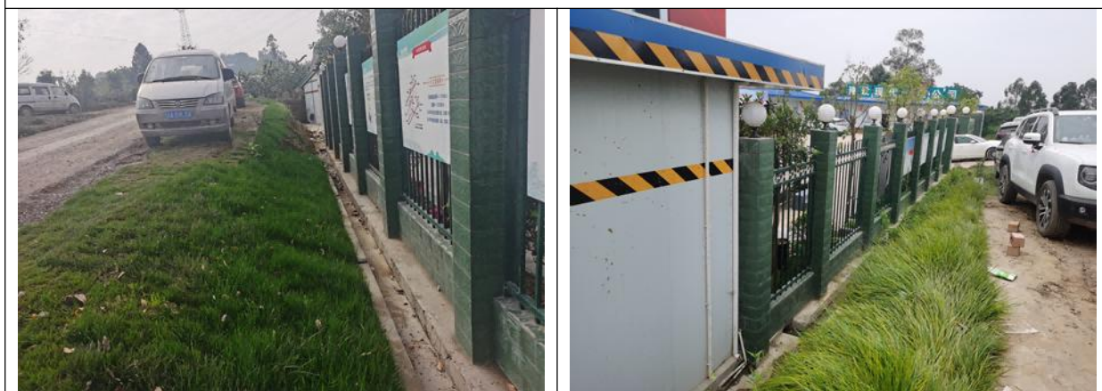
施工场地区施工期临时绿化及临时排水设施
