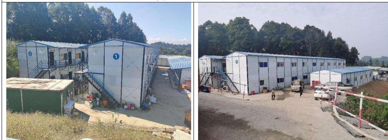
图 1-25 3#施工场地（施工期）
