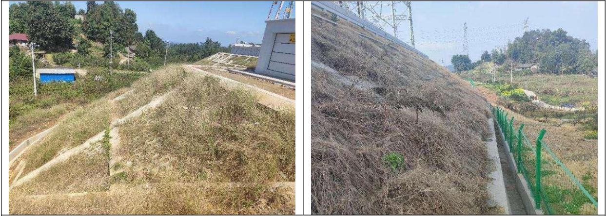
图 3-3 变电站边坡防护（2）
