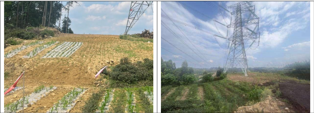
图 3-16 施工道路迹地恢复
