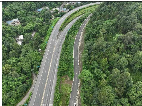
图 1-11 2#进站道路现状
