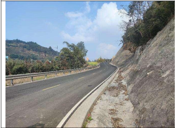
图 1-8 2#进站道路现状
