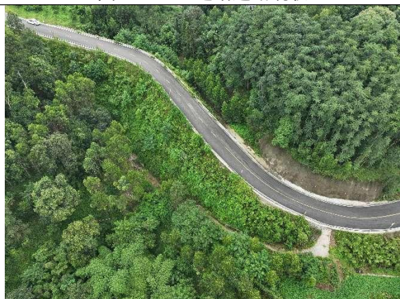
图 1-13 2#进站道路现状
