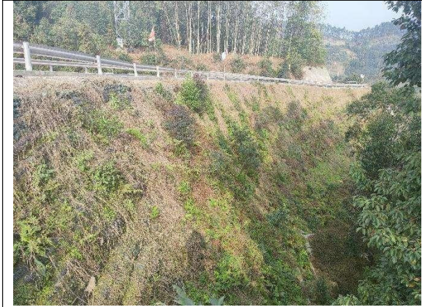
图 1-9 2#进站道路现状
