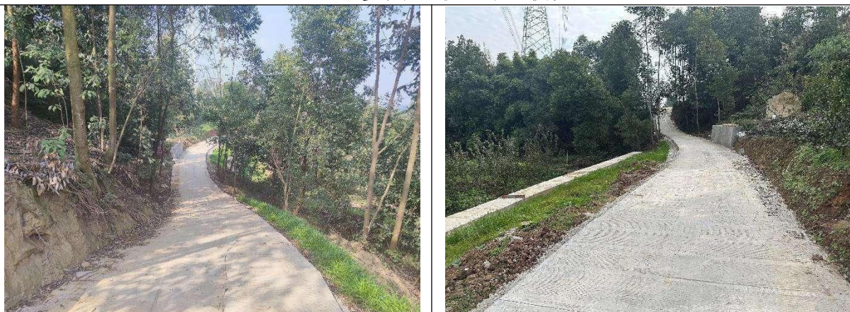
图 1-18 还建道路现状及边坡防护（新建段）
