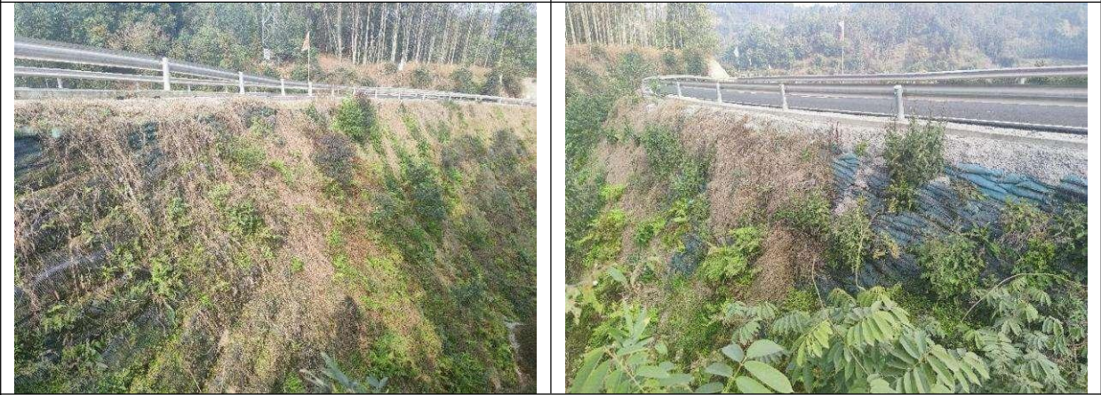
图 3-9 进站道路边坡防护
