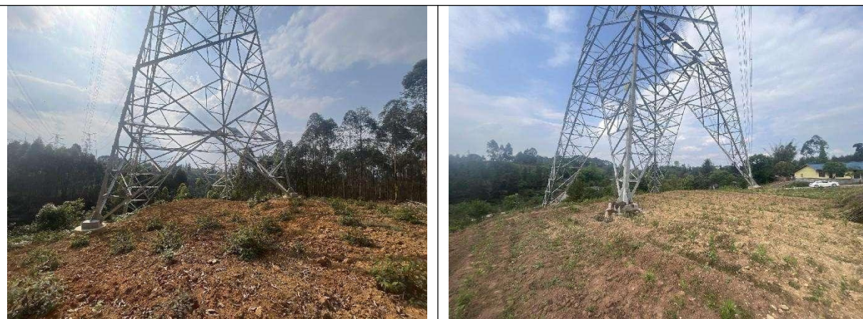
图 3-12 塔基施工临时占地栽植灌木
