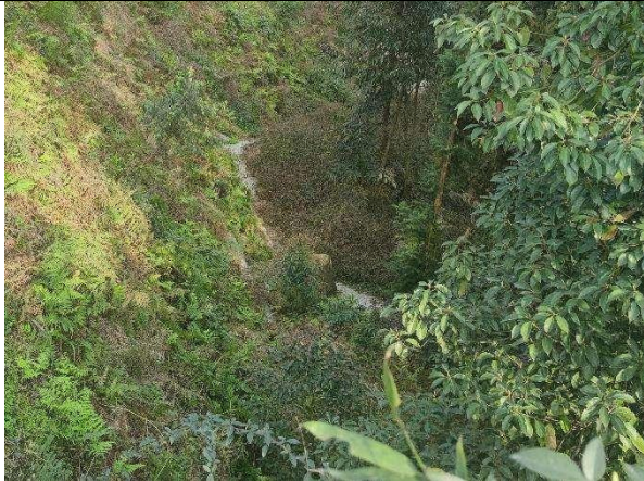
图 1-10 2#进站道路现状
