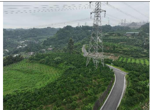
图 1-16 改造道路现状
