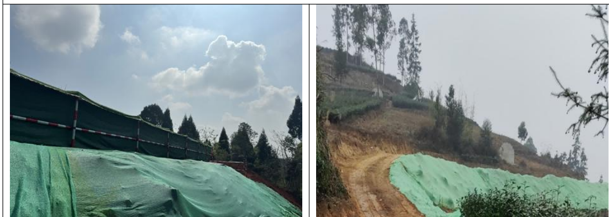
图 3-15 施工道路施工期边坡遮盖措施
