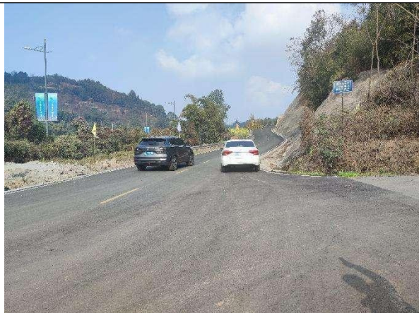
图 1-7 2#进站道路现状
