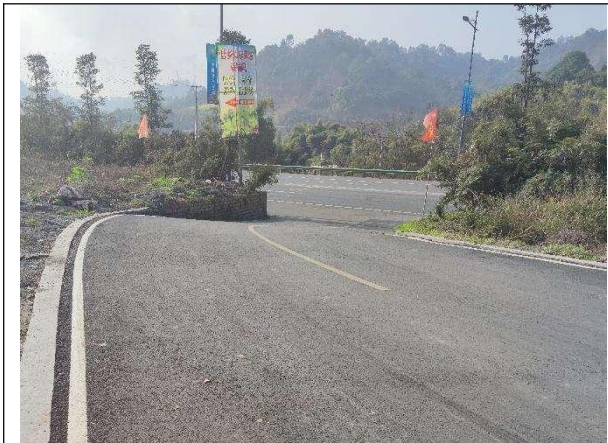
图 1-6 2#进站道路与五通桥过境线相接处
