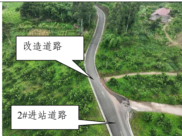
图 1-15 2#进站道路与改造道路相接处
