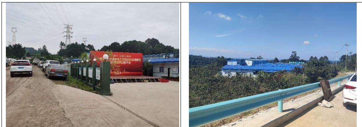
图 1-23 2#施工场地（施工期）
