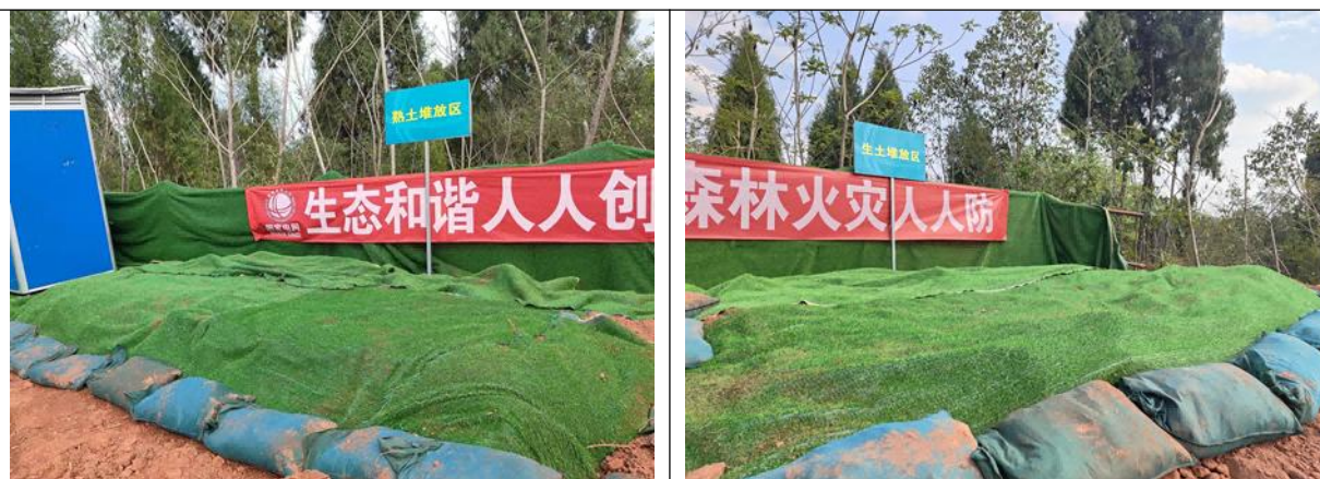
图 3-11 施工期临时堆土拦挡遮盖防护措施
