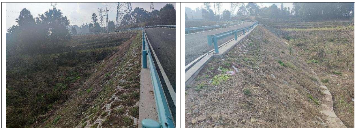
图 3-10 进站道路边坡防护
