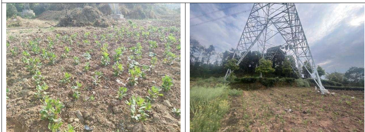
图 3-14 塔基施工临时占地复耕
