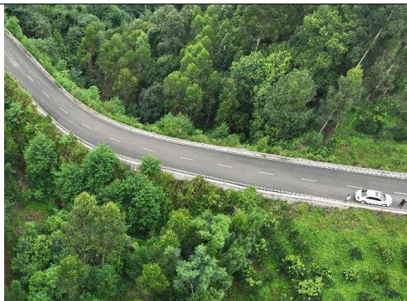
图 1-12 2#进站道路现状
