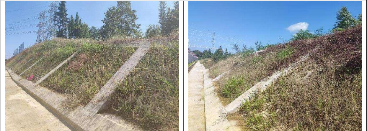
图 3-2 变电站边坡防护（1）
