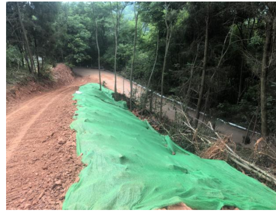
施工道路边坡苫盖防护
