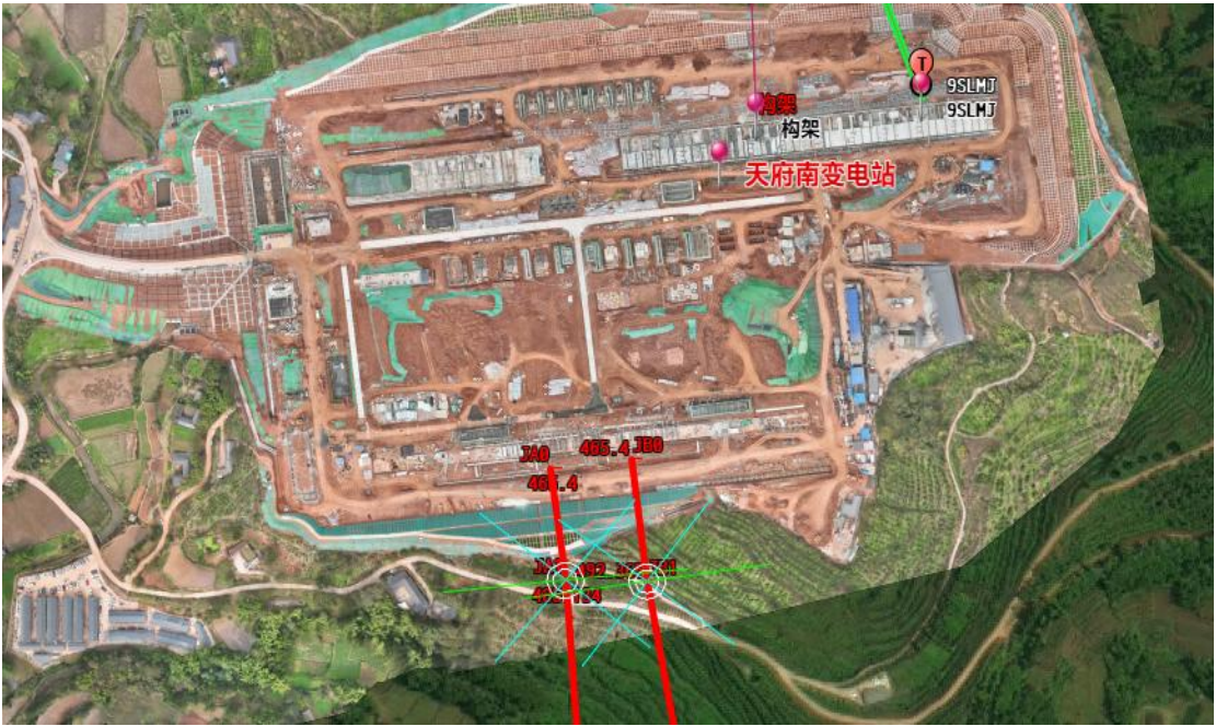
天府南 1000kV 变电站卫星影像
