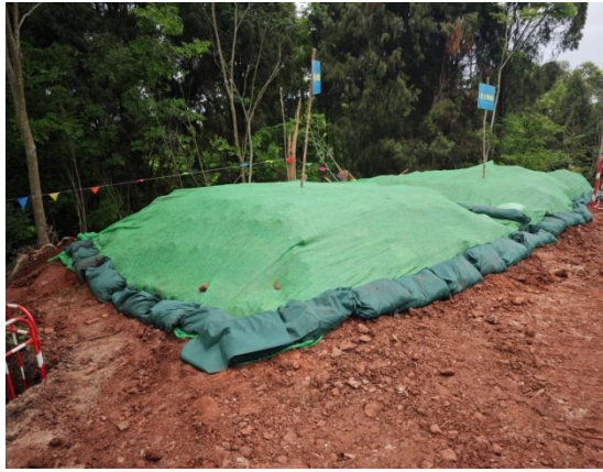
塔基及其施工场地区的生、熟土分开堆放并进行防护
