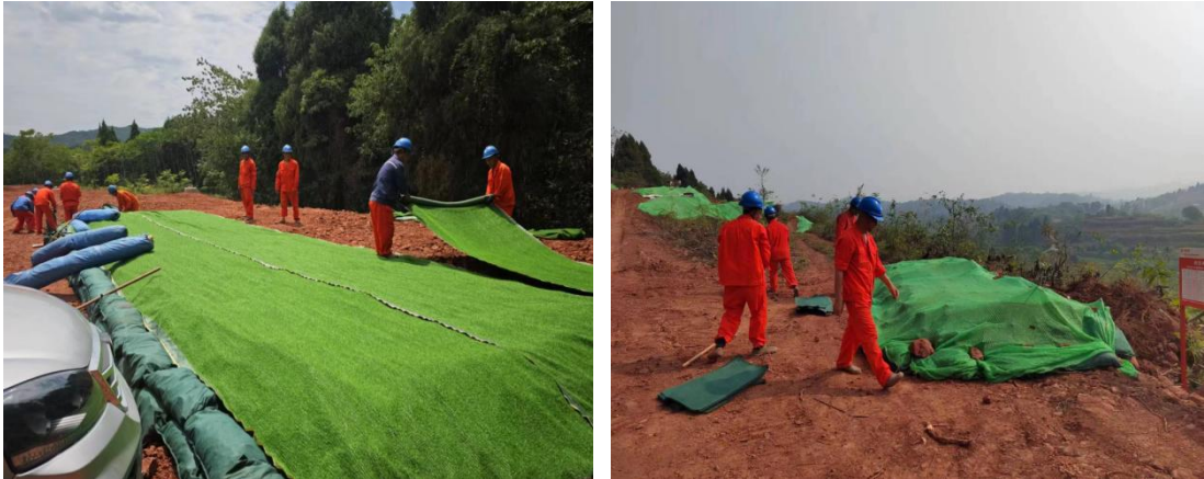
塔基施工场地剥离表土仿生草皮苫盖、植生袋袋装土拦挡
