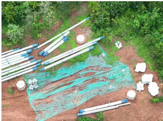
塔基区基础完后及时进行植被恢复
