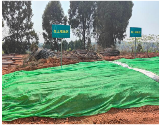
塔基及其施工场地区的生、熟土分开堆放并进行防护
