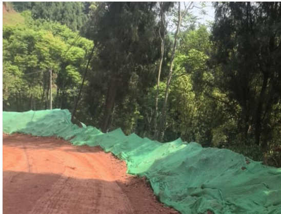
施工道路边坡苫盖防护
