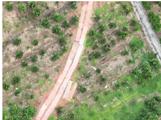
施工道路铺设钢板垫护
