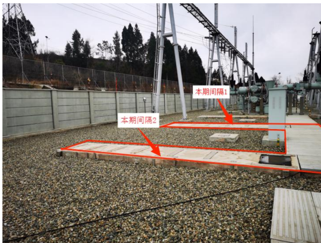
八德 220kV 变电站 110kV 间隔扩建工程现场照片
