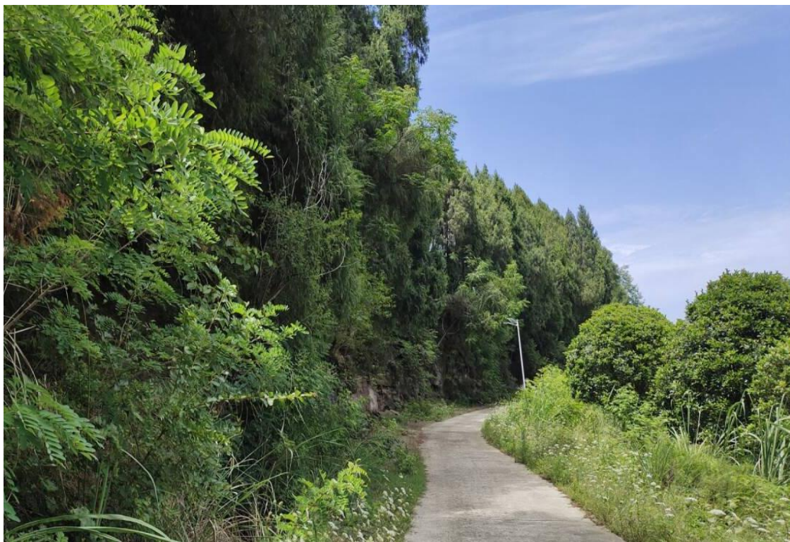
陇黄线天鼓岭支线改接火峰 110kV 线路工程沿线照片
