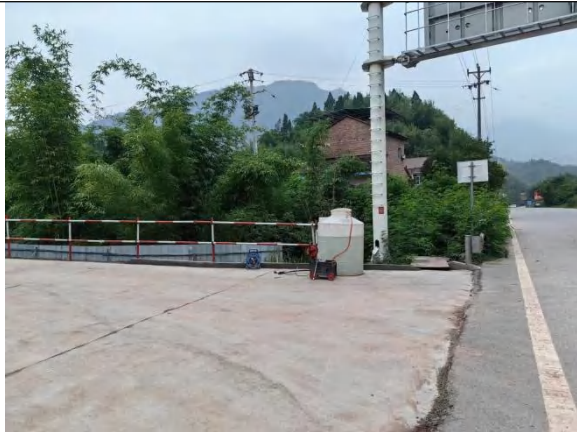
车辆冲洗设施
