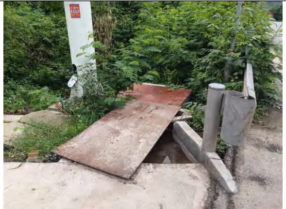
车辆冲洗区域临时沉沙池
