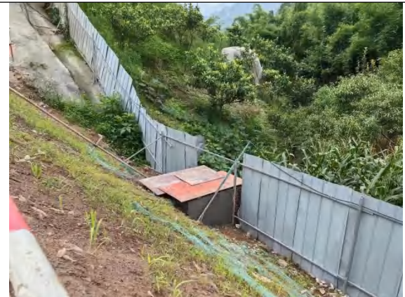
其他占地区临时沉沙池
