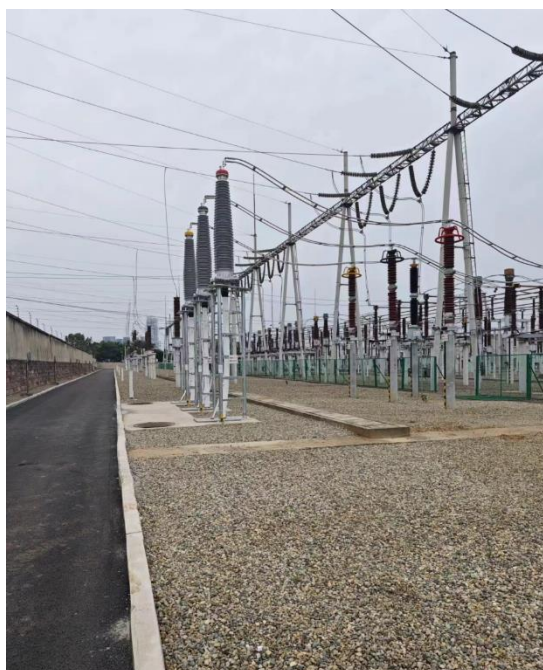
大面220kv变电站间隔改造处设置碎石压盖
