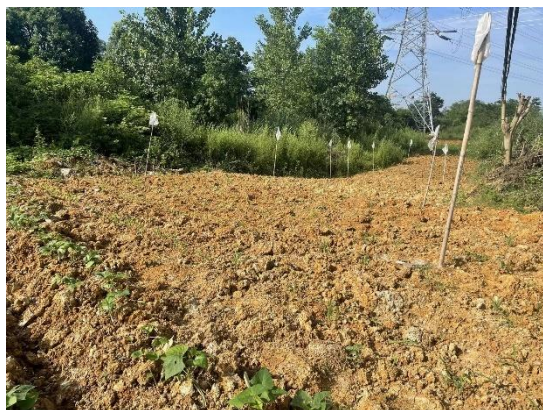
NA5塔位临时道路现状（已复耕）
