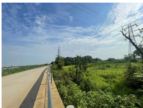
NA9塔位跨越场现状
