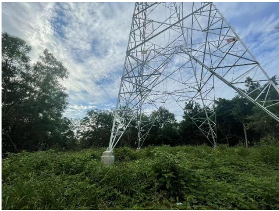
NB4 塔位现状（植被恢复状况良好）
