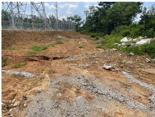
NA25塔位土地整治不到位、植被覆盖率暂不达标
