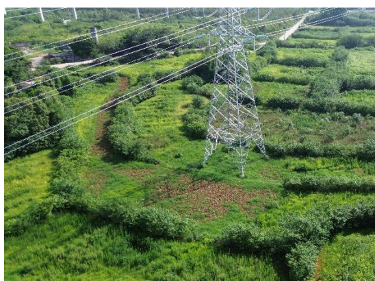
NA9塔位及旁边牵张场现状（植被恢复状况良好）
