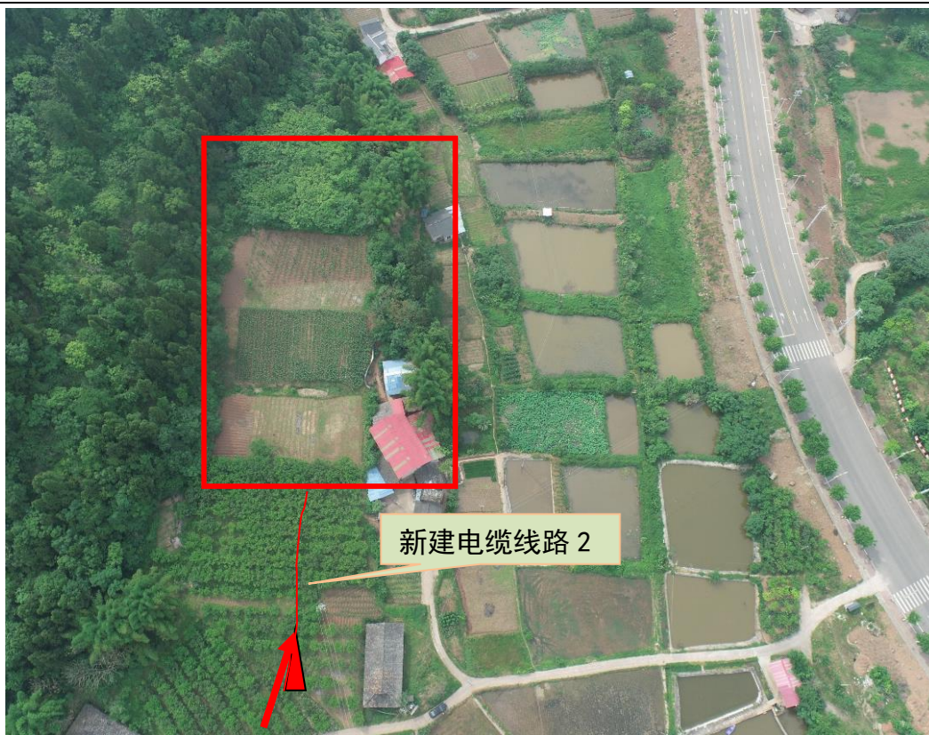
线路工程终点——太吉 110 千伏变电站（单独立项建设）
