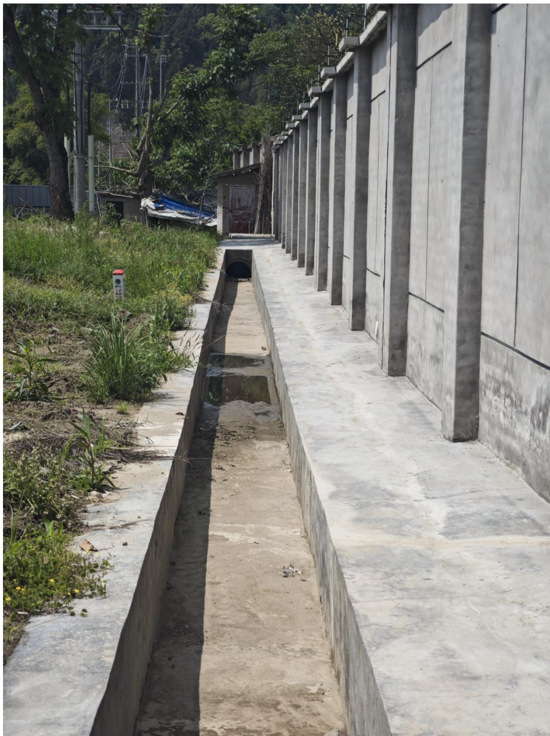
浆砌砖截排水沟
