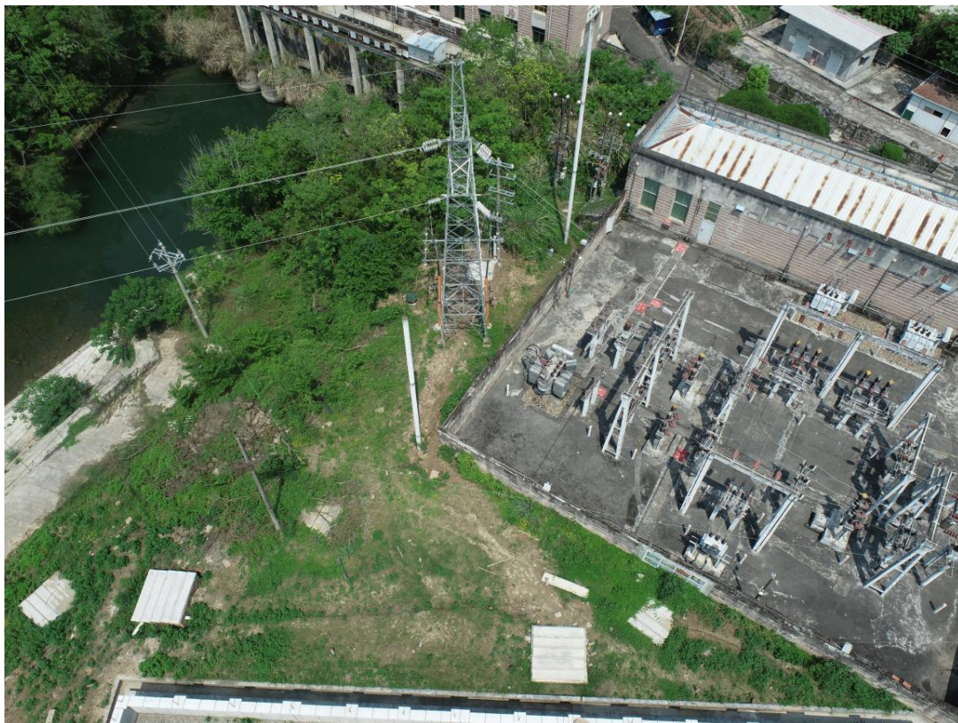
电缆及其施工临时占地区 1
