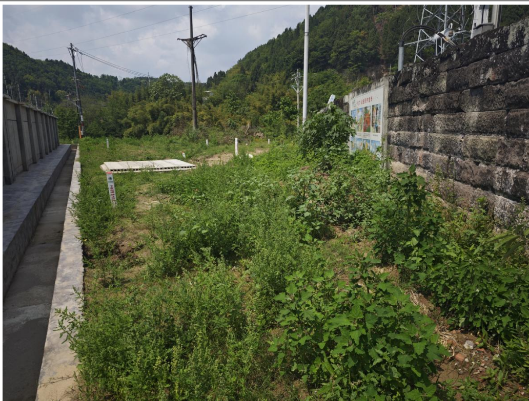
电缆及其施工临时占地区 2
