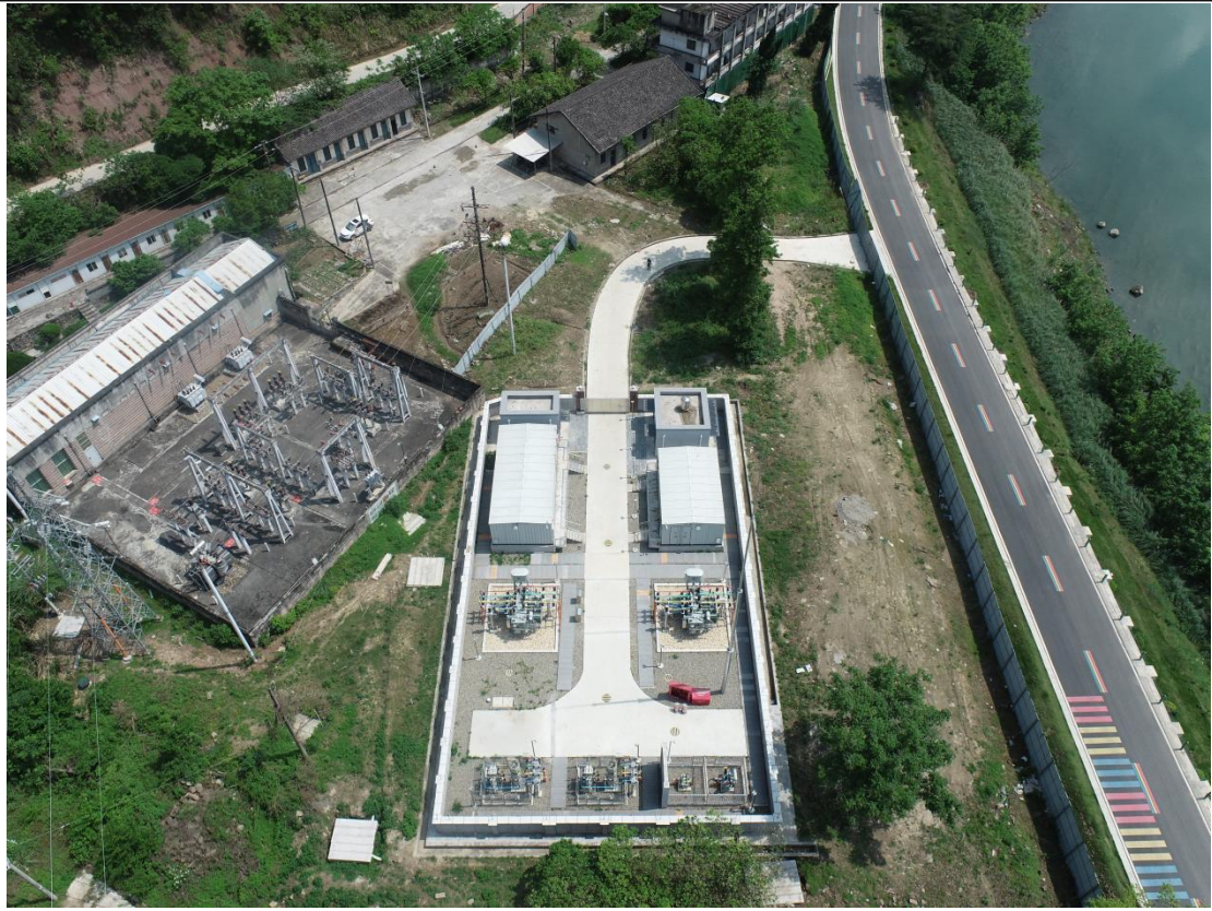
玉台 35kV 变电站
