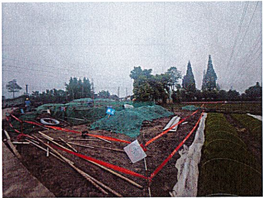
N2 (1) 塔基施工场地现状
