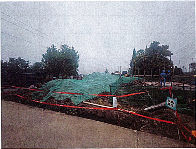
N2 (2) 塔基施工场地现状
