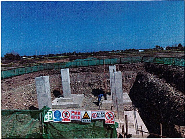
N21 塔基施工场地现状
