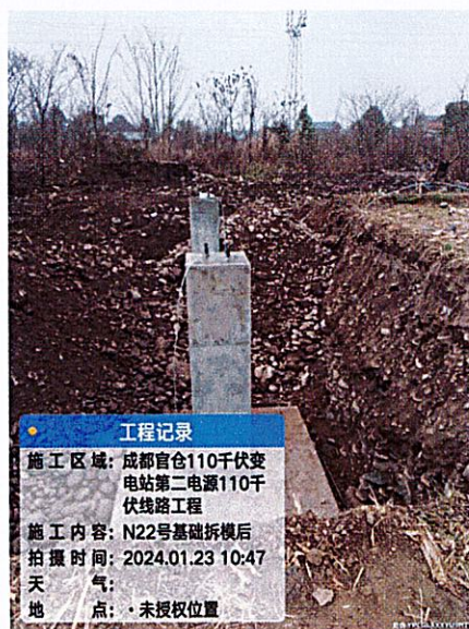
图 4.3-1 N22 塔基临时占地区域存在的土石方
