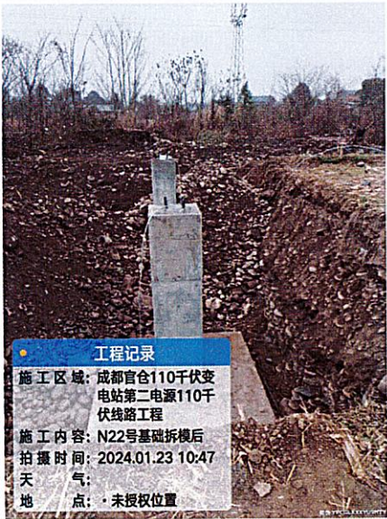
N22 塔基施工场地现状
