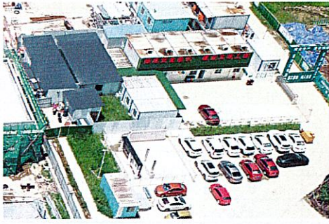
储能项目预留区场地硬化
