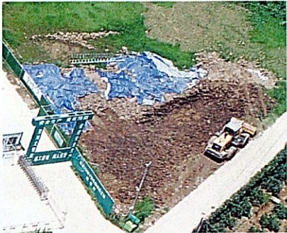
临时堆土区临时遮盖
