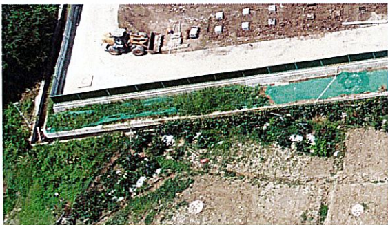
变电站主体工程区排洪沟
