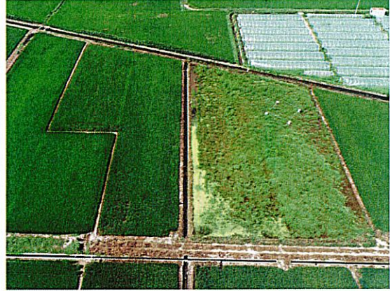
N60 塔位及施工道路
