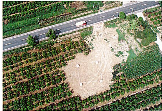
N78 塔位及施工道路
