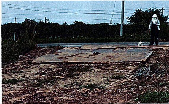
N42 塔位施工道路铺设钢板
