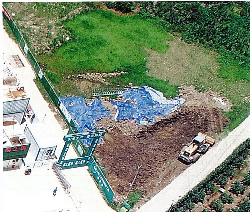
站区北侧临时堆土区现状
