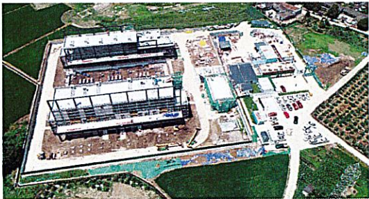
变电站主体工程区全景
