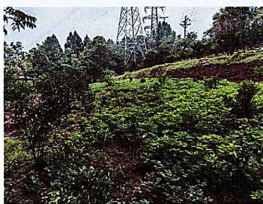
资阳站外 N2 塔基施工道路迹地恢复
