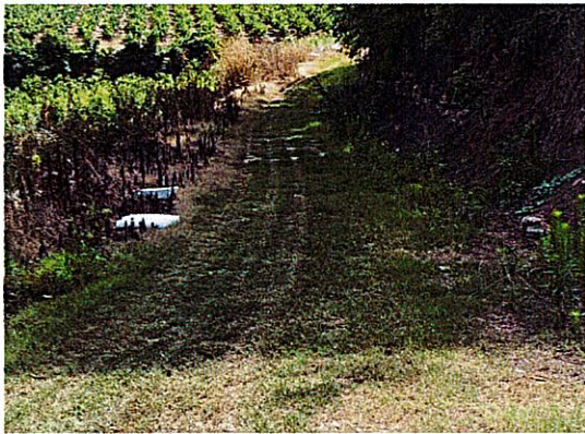
N68 号塔施工临时道路迹地恢复
