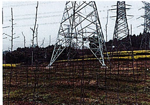
普安站外 N1 号塔基迹地恢复
