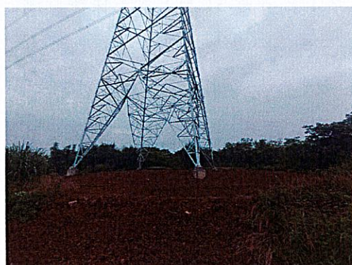
NL11 号塔施工场地土地整治
