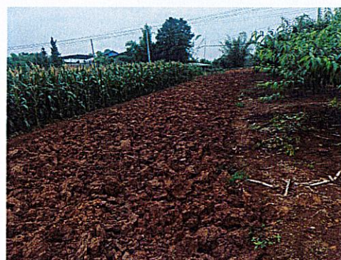
NL11 塔施工道路恢复
