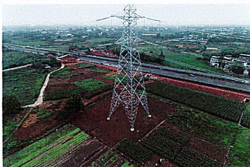
NR5 号塔施工场地恢复
