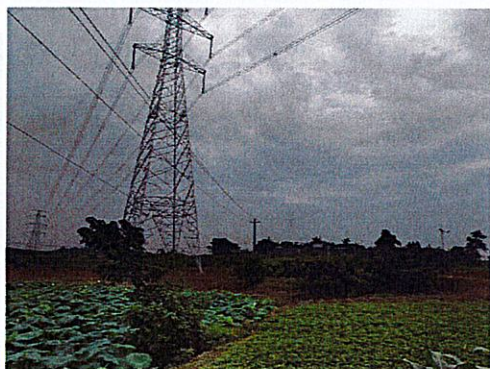
NR2-NR3 跨越场地恢复 (10kV 线路)
