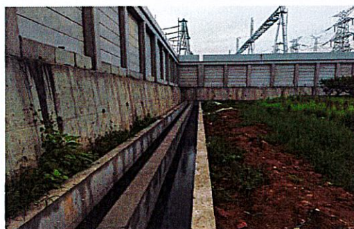
变电站截排水沟修筑
