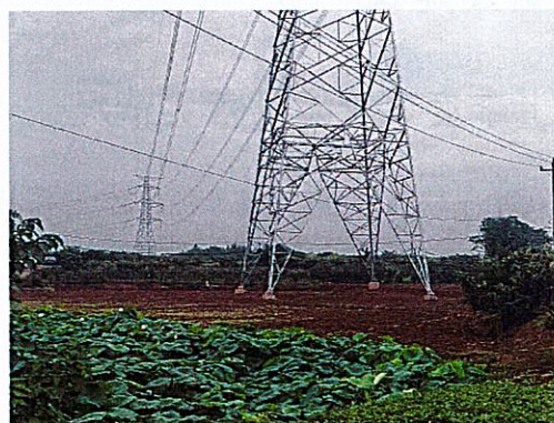
NR3 号塔施工场地土地整治
