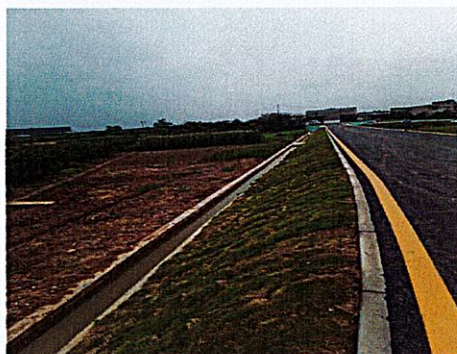
进站道路边坡植草皮护坡
