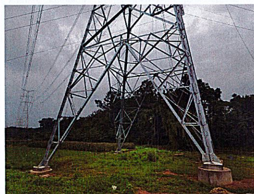
NL12 号塔施工场地植被恢复
