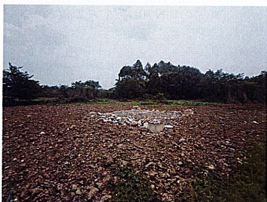
N40 塔基施工场地现状
