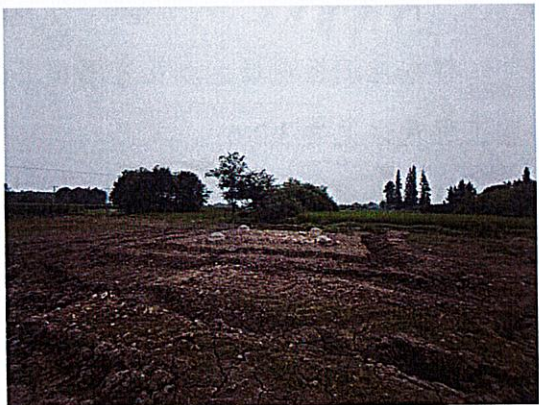
N34 塔基施工场地现状
