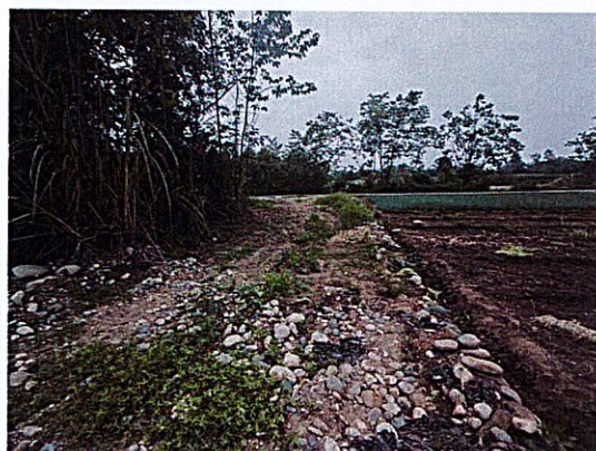
N40 塔位施工道路
