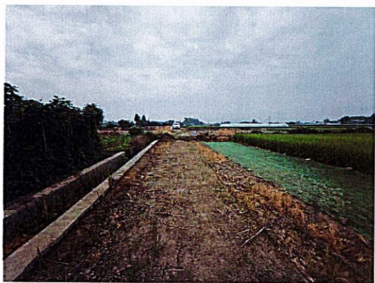
N34 塔位施工道路
