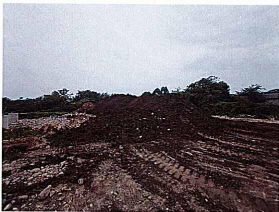
图 4.3-1 N41 塔基临时占地区域存在的土石方
