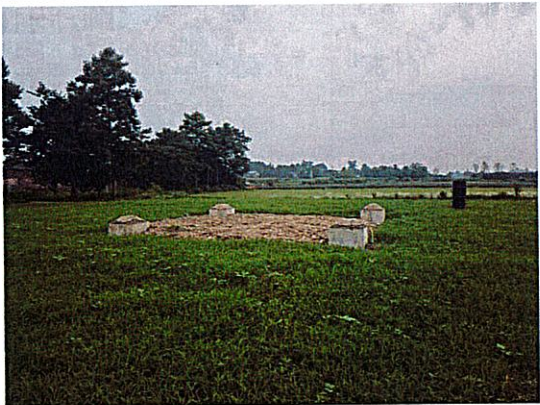
N30 塔基施工场地现状
