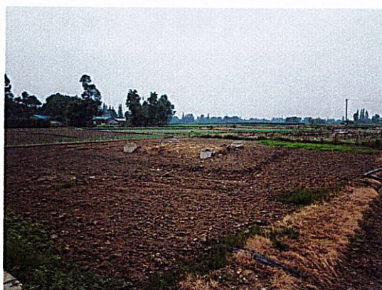
N35 塔基施工场地现状
