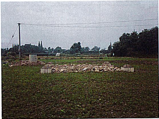
N29 塔基施工场地现状
