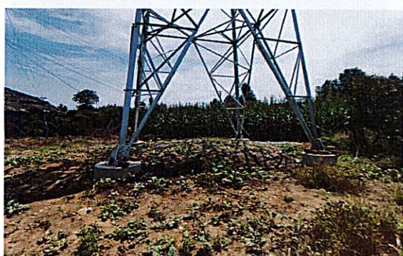
高埂—赵塔 N2 塔位现状
