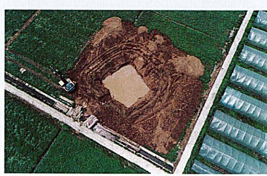
邓寿安线 N25 塔位现状
