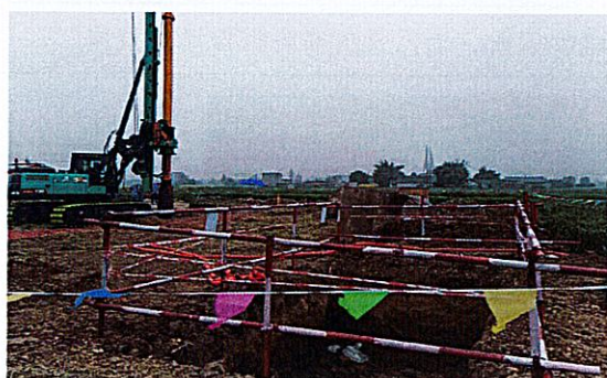
高埂—赵塔 N4 塔位泥浆沉淀池
