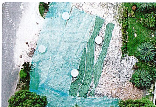
邓寿安线 N46 塔基施工占地区域临时遮盖防护
