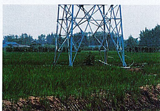
高埂—赵塔 N3 塔位现状
