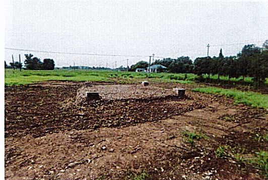
庄园—解林 N21 塔位现状
