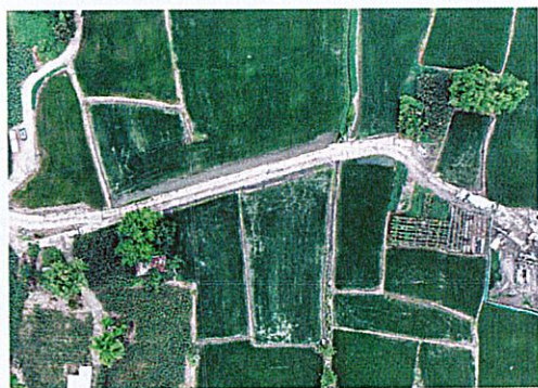
苏场—福田 N12 塔位及施工道路（铺设钢板）
