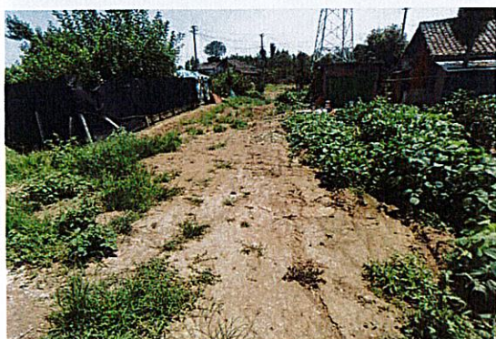
高埂—赵塔 N2 塔位施工道路
