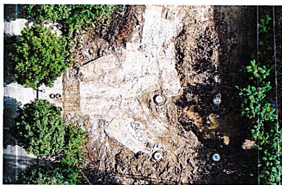
苏场—邛崃 N48 塔位现状（铺设钢板）
