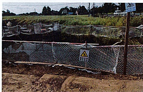
邓寿安线 N22 塔位泥浆沉淀池
