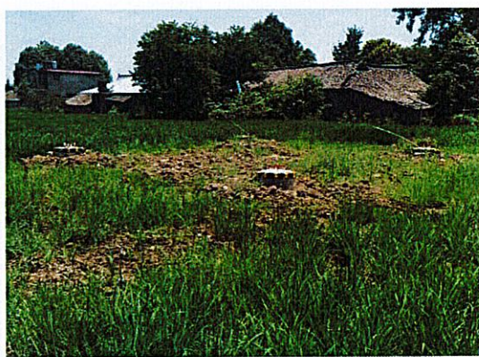
苏场—邛崃 N5 塔位现状
