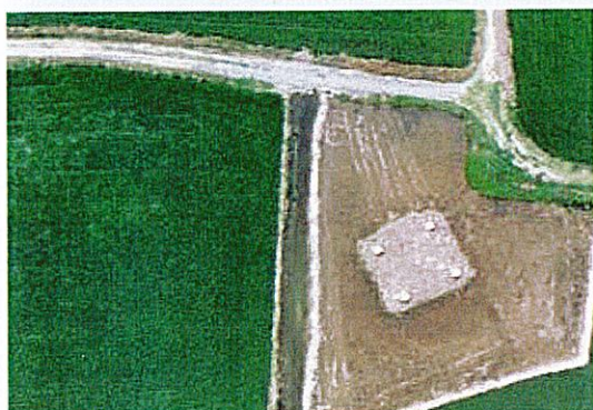
苏场—邛崃 N7 塔位现状
