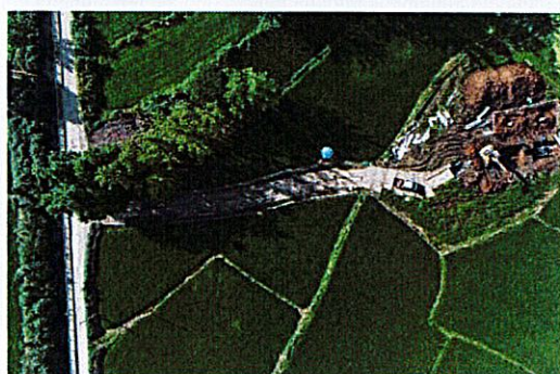
庄园—解林 N8 塔位现状
