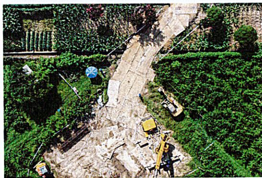
苏场—邛崃 N21 塔位现状（铺设钢板）
